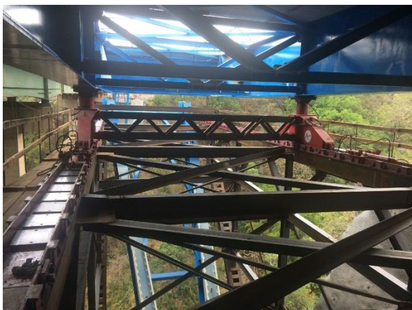
Figura 10. Vista inferior del tablero durante las fases de lanzamiento sobre la estructura auxiliar
