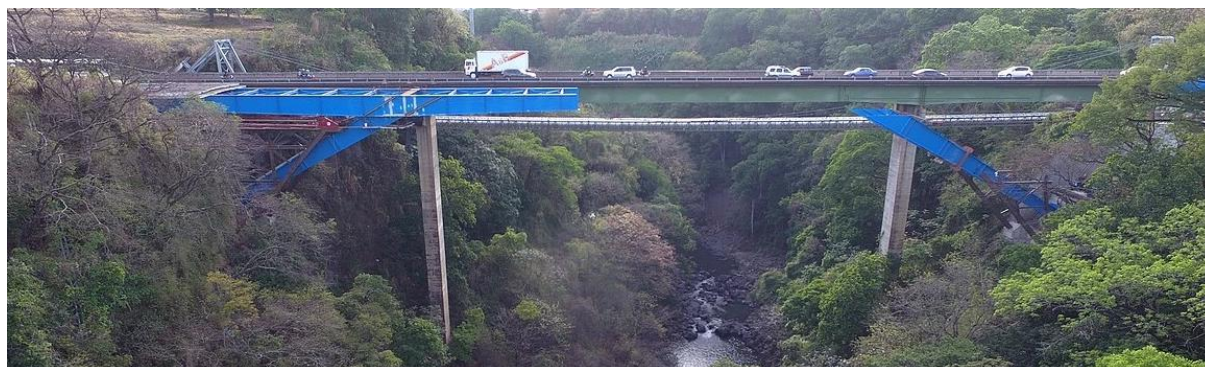
Figura 8. Vista lateral del puente sobre el río Virilla tras la vinculación del tablero del lado San Antonio a la pila P2 y con la pila P1 abatida en su posición definitiva (vista norte-sur: el estribo E2 está a la izquierda)
