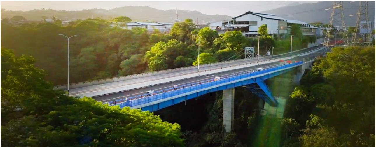
Figura 14. Vista lateral del puente terminado
