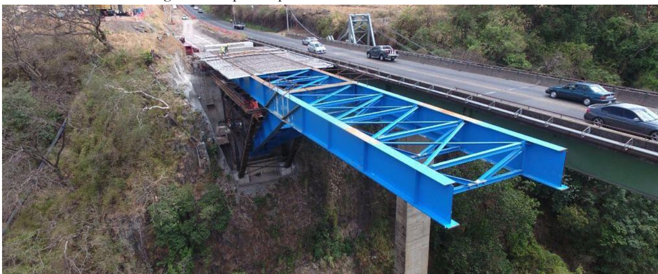
Figura 11. Lado San Antonio durante las últimas fases del lanzamiento sobre la estructura auxiliar
