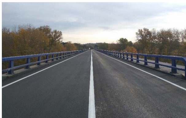
Figura 26. Vista general de plataforma.
