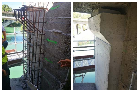
Figura 17. Reconstrucción de montantes
