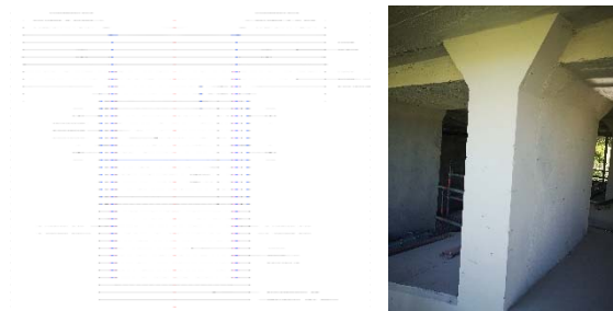
Figura 16. Detalle de recrecido lateral de montante.
