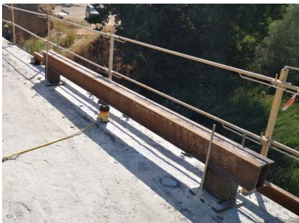
Figura 21. Prueba de carga voladizo
