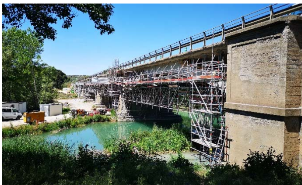
Figura 15. Vista general de andamios colgados.
