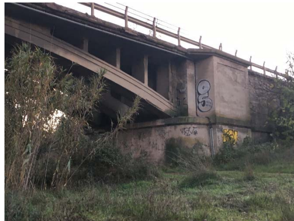
Figura 2. Vista general estribo existente.
