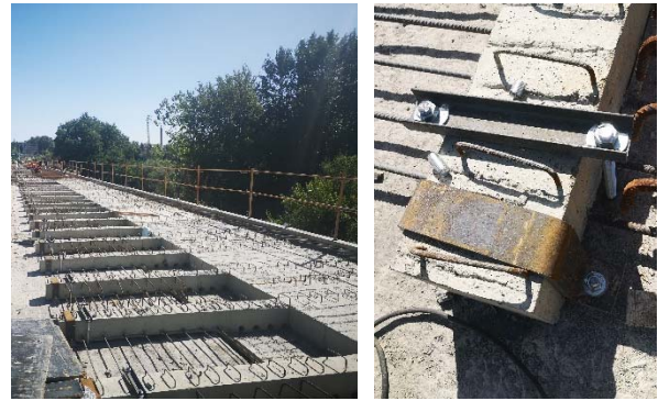
Figura 19. Instalación en obra de prelosas
