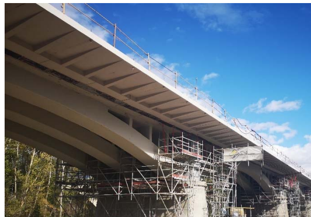
Figura 24. Vista inferior del nuevo tablero.
