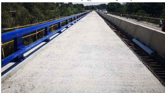
Figura 22. Detalle de semilosa construida, con el sistema de contención implantado
