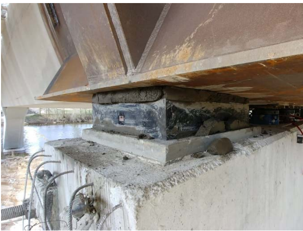
Figura 12. Descenso del tablero sobre los nuevos aparatos de apoyo.
