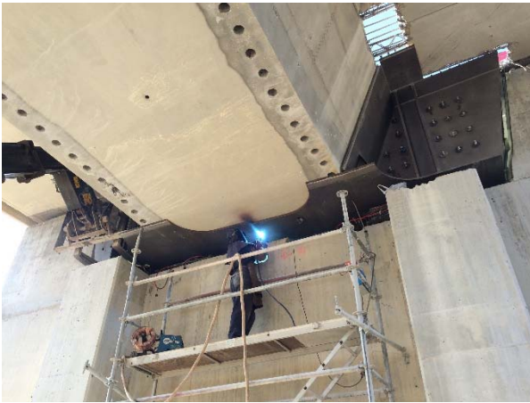
Figura 11. Montaje de dovelas de estribo y ejecución de soldadura de conexión in situ
