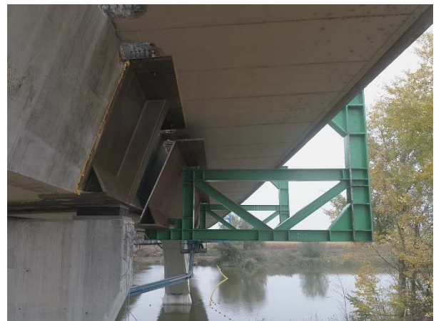
Figura 17. Montaje de dovelas
