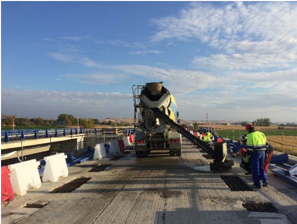
Figura 18. Hormigonado de las ventanas ejecutadas en los voladizos para alojar la conexión superior.
