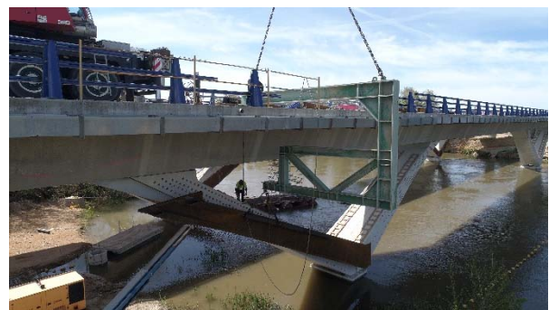
Figura 20. Montaje del forro metálico en pilas en V.
