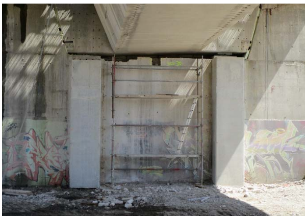
Figura 8. Vista de los recrecidos frontales en los estribos.
