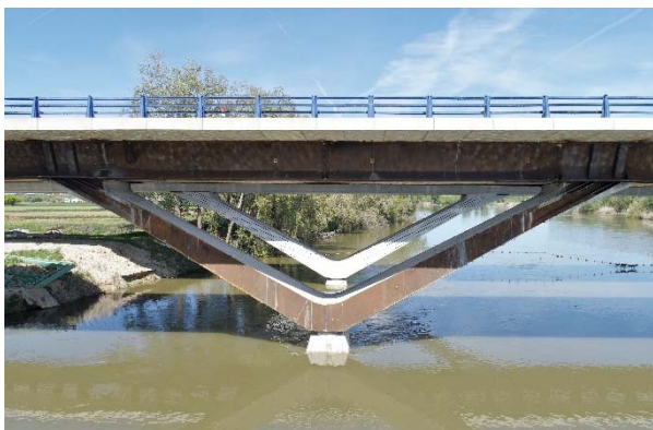
Figura 22. Vista final de las pilas en V.
