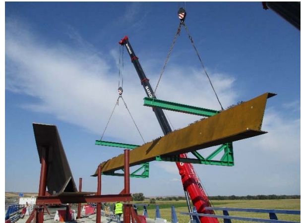
Figura 16. Dovela sobre los útiles de izado diseñados para el montaje.
