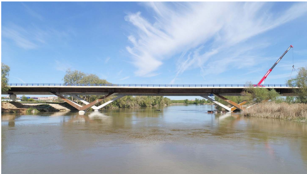
Figura 24. Vista de la estructura tras las obras de reparación
