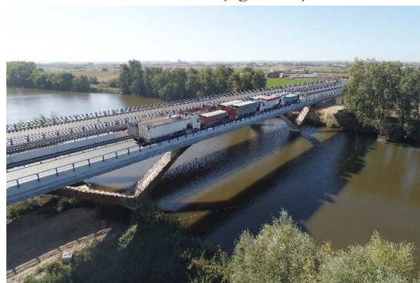
Figura 23. Prueba de carga.
