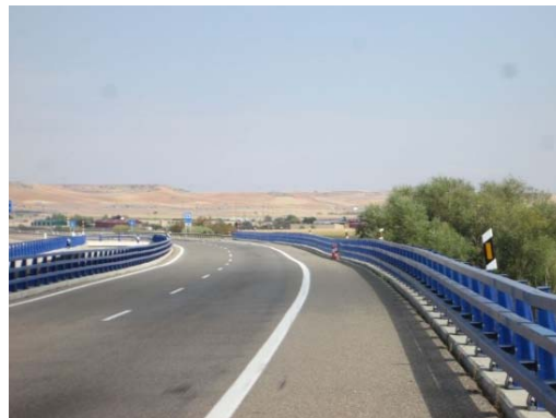
Figura 5. Deformación aparente del tablero.
