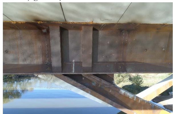
Figura 21. Vista del nudo de las pilas en V.
