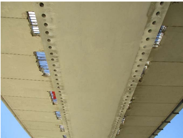
Figura 15. Vista inferior del tablero con las ventanas en el voladizo y los taladros en la losa inferior para alojar los pernos de conexión.
