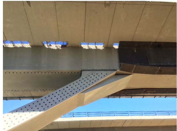
Figura 19. Taladros en la pila en “V” para alojar los pernos.
