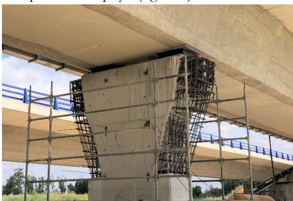
Figura 9. Vista de los recrecidos laterales en las pilas convencionales
