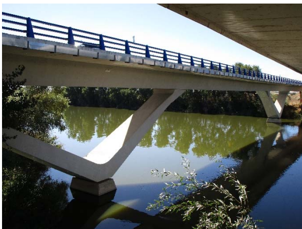
Figura 2. Vista general de la estructura.
