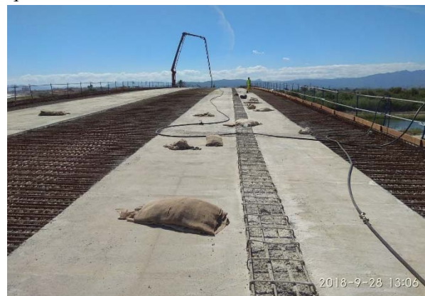
Figura 13. Losa hormigonada en primera fase.
