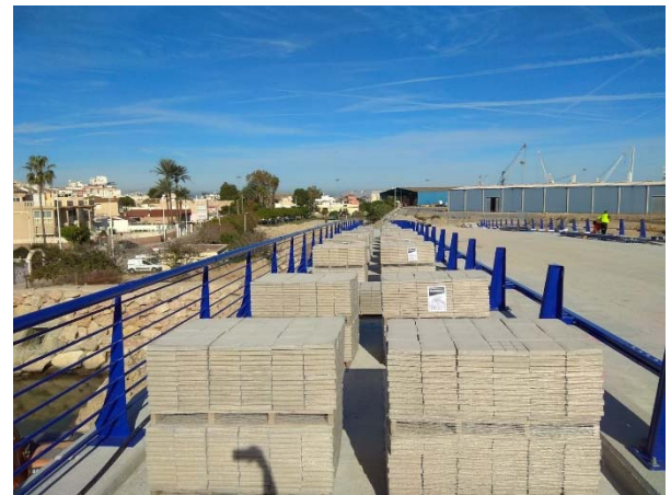
Figura 16. Prueba de carga en la zona peatonal y carril ciclista.
