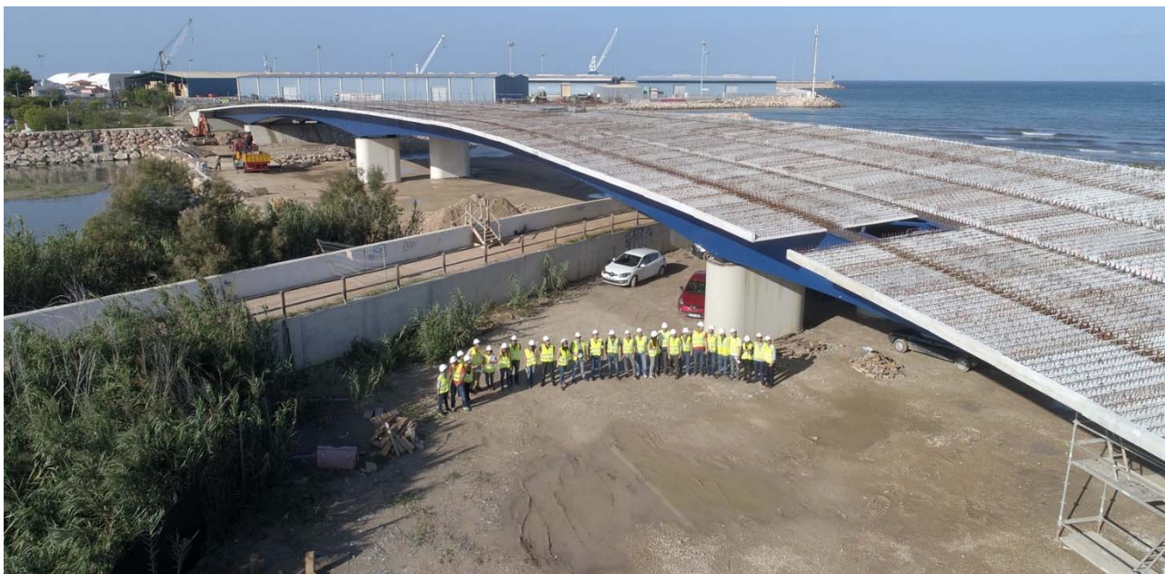
Figura 18. Vista general de la estructura durante las obras en una visita de parte del equipo de IDEAM
