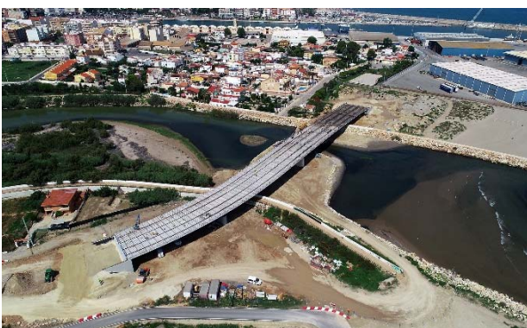
Figura 15. Vista aérea del viaducto colocando prelosas.
