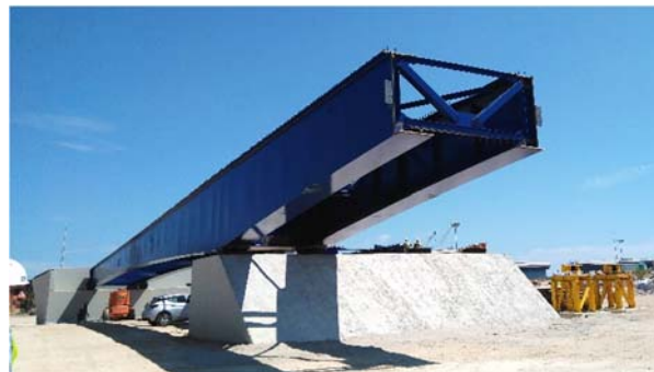
Figura 9. Mota de protección en pila P-3.
