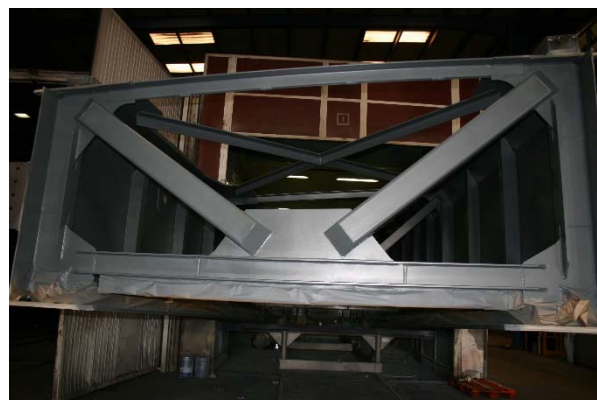
Figura 8. Vista de una celosía de la zona de negativos en taller.
