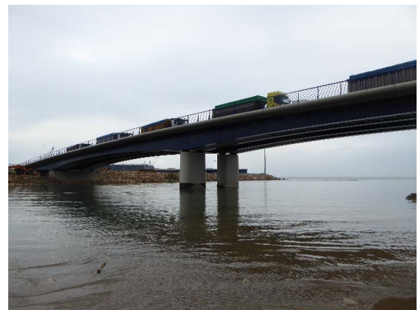
Figura 17. Prueba de carga en calzada
