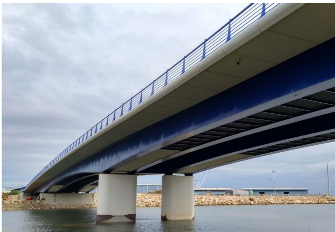
Figura 4. Vista general del Viaducto sobre el río Serpis.
