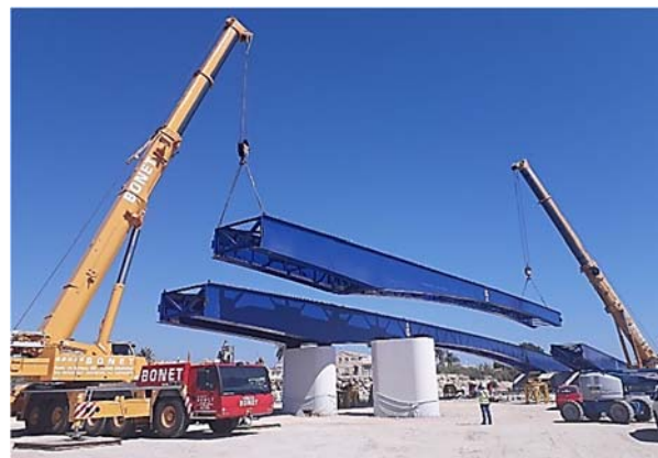
Figura 12. Izado mediante grúa de tramo metálico.
