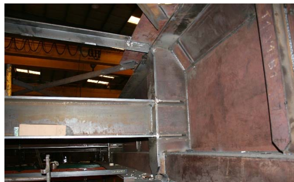
Figura 7. Imagen de arriostramiento en H en zona cambio de vano.
