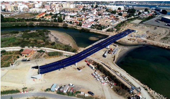
Figura 14. Imagen aérea de las 4 vigas colocadas en obra.
