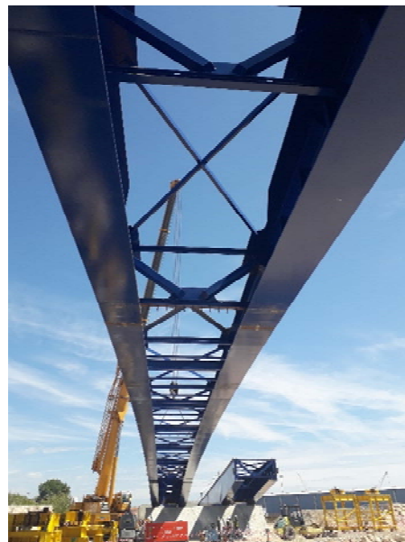
Figura 6. Vista inferior durante la construcción.
