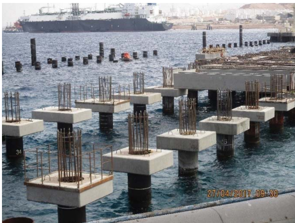
Figura 9. Pilotes coronados por los capiteles tipo tapón, con armadura longitudinal en espera.
