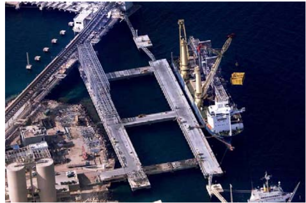
Figura 2. Vista de los dos jetties , puentes de acceso, y puente de aproximación.
