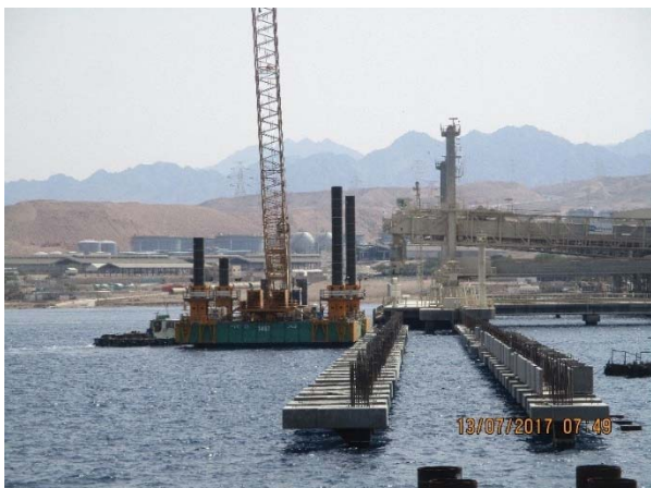
Figura 13. Vista del jetty con los capiteles colocados.
