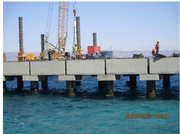
Figura 14. Colocación del encofrado de hormigón prefabricado del emparrillado de vigas.
