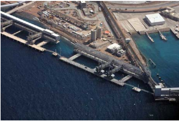
Figura 1. Vista general del nuevo muelle de Aqaba, cinta transportadora, y cargadores de graneles.
