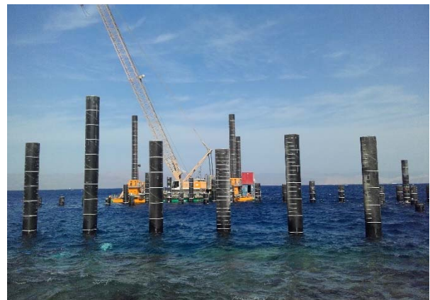
Figura 11. Pilotes metálicos en espera.
