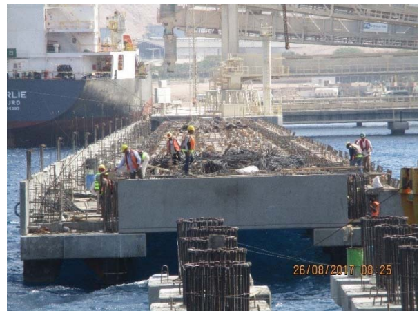
Figura 16. Colocación de la armadura y hormigonado in-situ de la losa.
