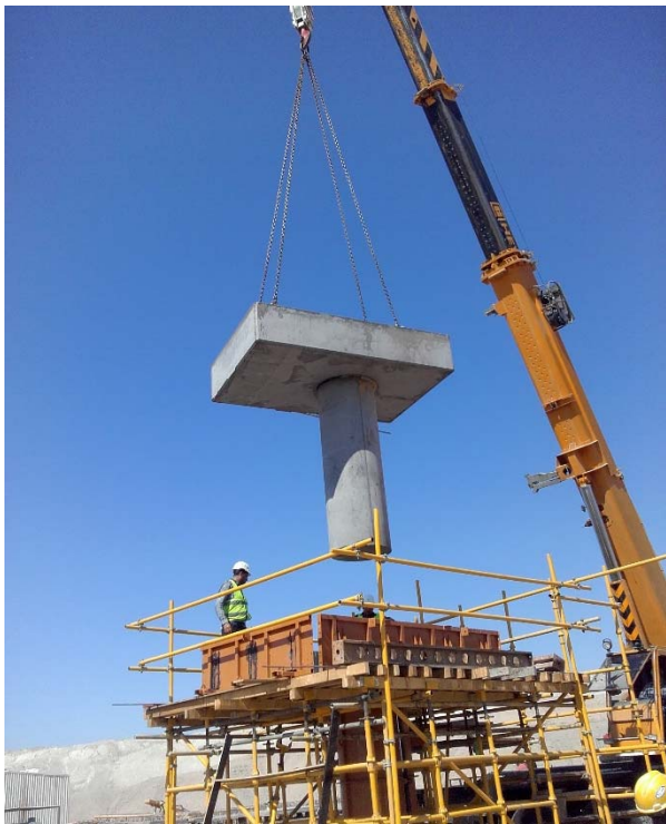
Figura 12. Colocación del capitel tipo “tapón” prefabricado de hormigón.
