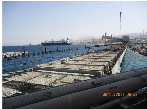
Figura 15. Colocación de las prelasas no colaborantes de la losa del jetty lado tierra.
