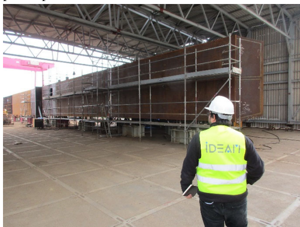
Figura 7. Visita a obra, punto de parada para la supervisión del dintel de pila.
