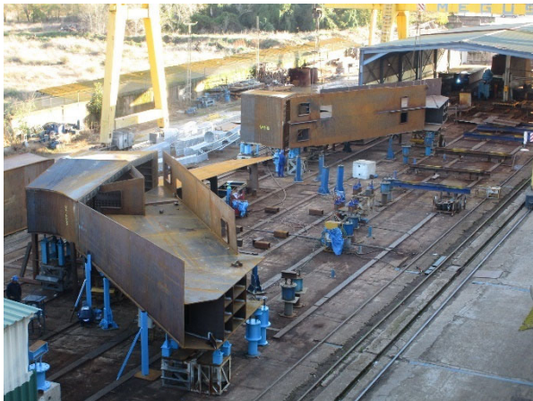
Figura 5. Montaje del dintel de pila en taller.
