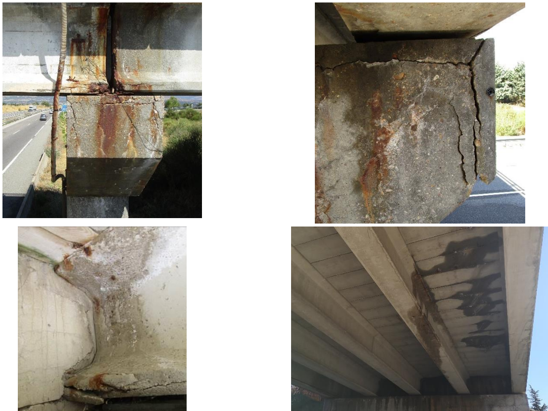
Figura 1. Ejemplos de daños tipo en tableros de vigas por ataque químico de sales fundentes y ciclos de hielo-deshielo
