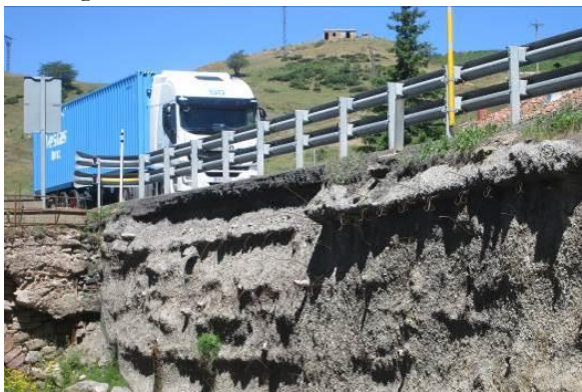
Figura 2. Degradación de muro de hormigón en masa por efecto de las sales fundentes y los ciclos de hielo/deshielo
