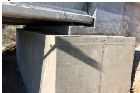
Figura 14. Vista general de estribo recrecido finalizado
