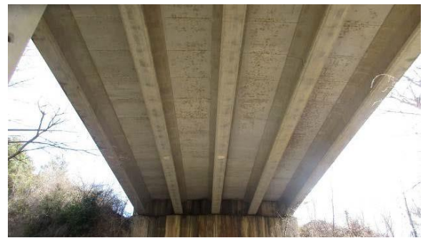
Figura 5. Puente de vigas con aparente buen estado de conservación
