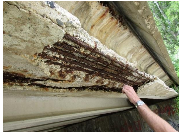
Figura 4. Grave afección al pretensado de las vigas laterales por afección directa de agua con fundentes sobre los paramentos de hormigón
