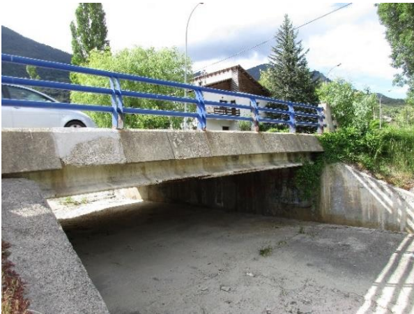
Figura 3. Obra de fábrica con daños severos por corrosión de armaduras por efecto de la circulación de aguas con sales fundentes
