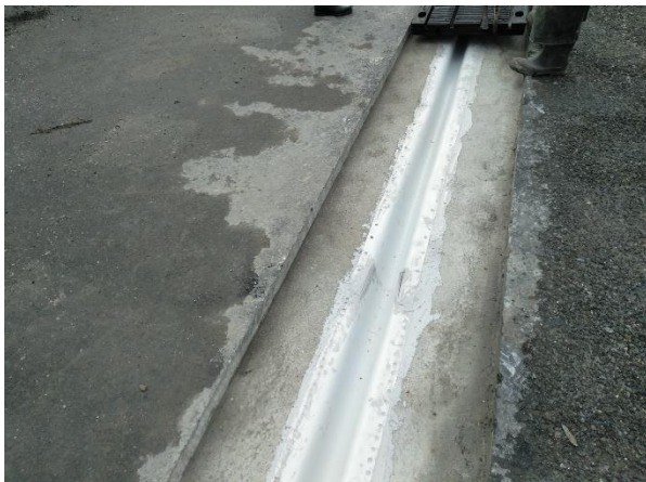
Figura 16. Vista del faldón instalado en la junta para la recogida de aguas.
