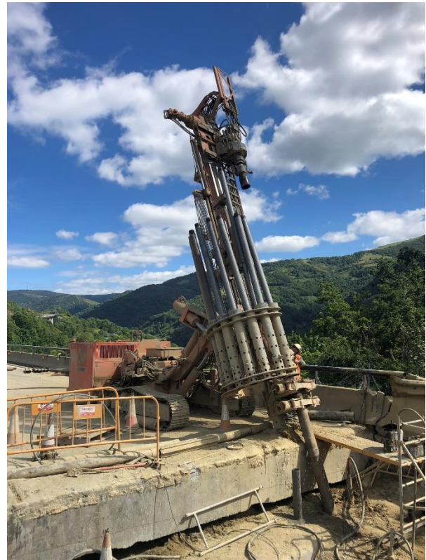
Figura 9. Ejecución de micropilotes inclinados.
