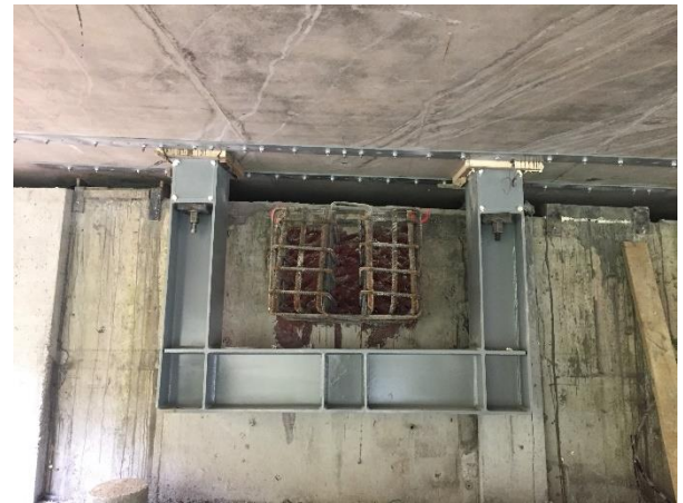
Figura 12. Vista estructura metálica y armado de la mensula corta.
