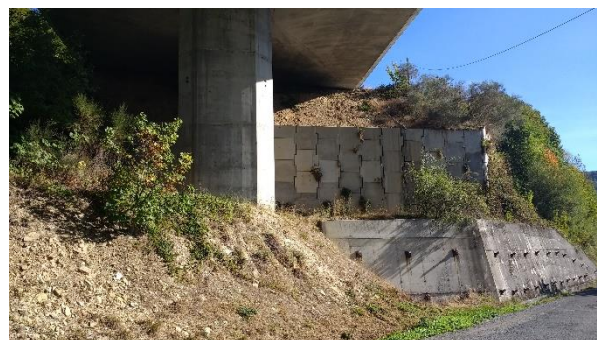
Figura 2. Estribo E-1 del viaducto de Noceda I.
