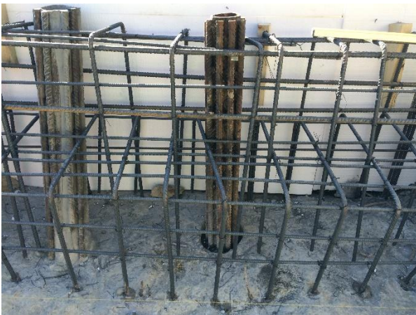
Figura 11. Detalle de conexión de micropilotes traseros.
