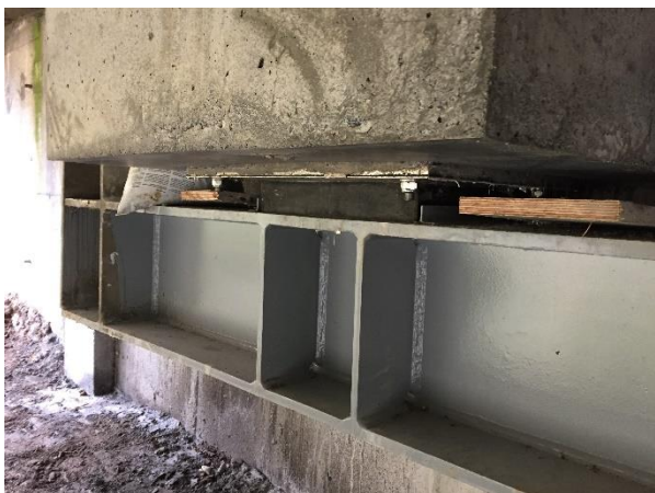
Figura 13. Apoyo deslizante en contacto ménsula-estructura metálica
