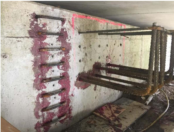
Figura 10. Detalle de conexión de los micropilotes delanteros.
