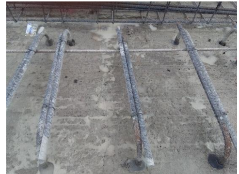
Figura 28. Detalle de parte superior de cercos en plataforma
