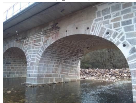
Figura 25. Vista general de bóveda tipo donde se pueden apreciar los trabajos de restauración, así como los taladros de cosido transversal de la propia bóveda.
