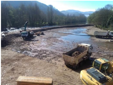
Figura 17. Trabajos de desvío del cauce
