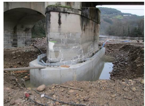
Figura 20. Zuncho de protección de hormigón armado perimetral a la cimentación.
