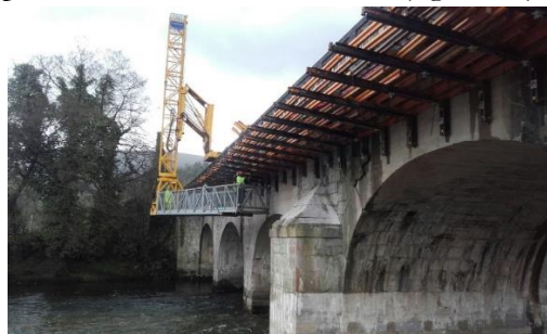
Figura 31. Vista general de ampliación de voladizos
