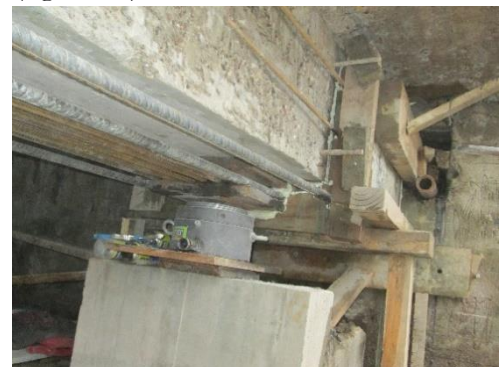
Figura 29. Puente metálico para permitir compaginar el refuerzo del extremo de vigas con el cambio de apoyos y el tráfico de plataforma.
