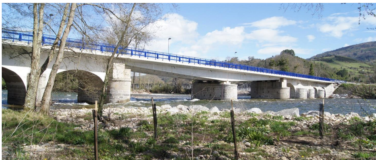
Figura 32. Vista general del puente reparado
