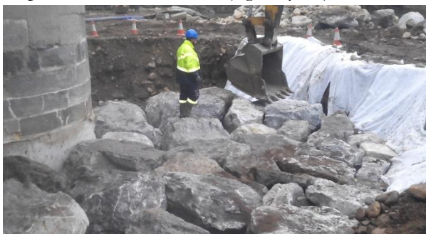
Figura 22. Detalle de colocación de escollera de protección. Bloques de 1500 kg.
