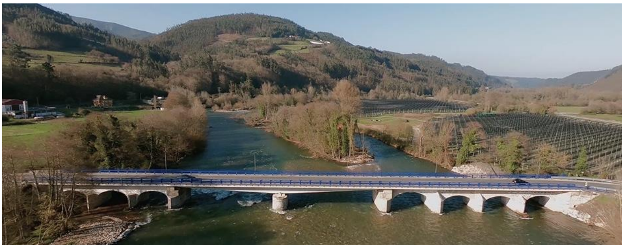
Figura 3. Vista general del puente tras la reparación realizada
