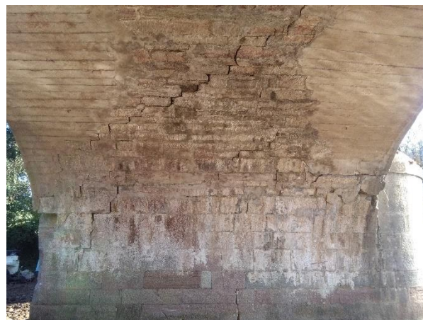
Figura 12. Detalle de bóveda tipo: Zona central no demolida y reaprovechada. Laterales reconstruidos con hormigón en masa. Grieta central en fábrica.
