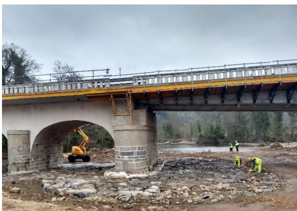
Figura 23. Vista general de pila con su manto perimetral de protección de escollera.
