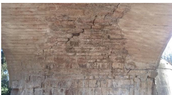
Figura 4. Vista general de bóveda de vano v-3, donde se pueden observar la zona central de fábrica y los laterales reconstruidos.
