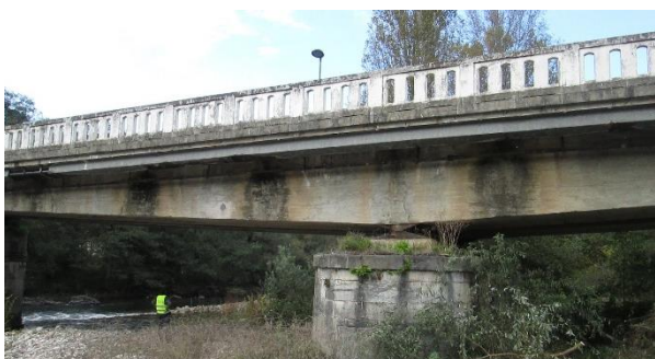
Figura 5. Vista del tablero central desde aguas abajo
