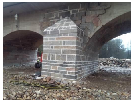
Figura 24. Vista general de pila tipo tras la actuación de limpieza, reparación y rejuntado de llagas.
