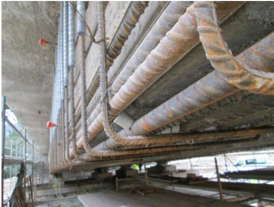
Figura 26. Disposición de ferralla perimetral a nervio de tablero.
