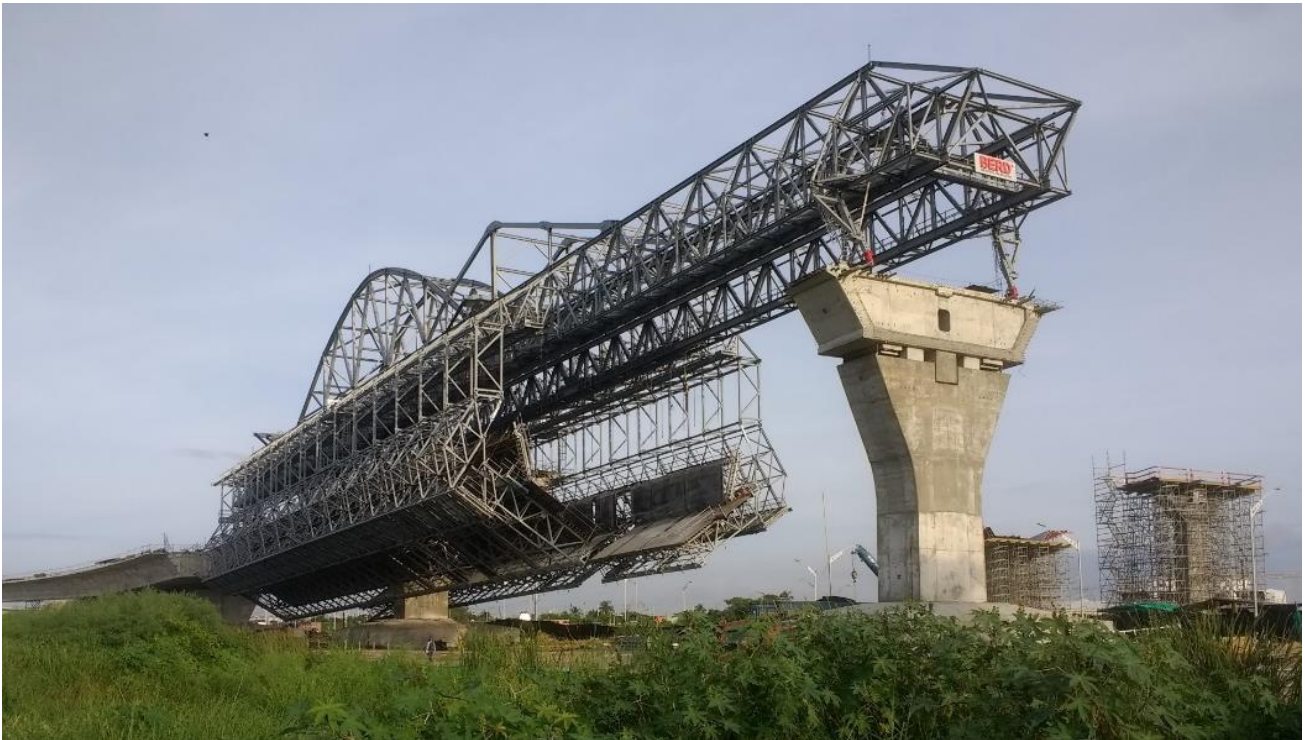
Figura 13. Proceso de ejecución de los viaductos de acceso con autocimbra (Foto: David Ruiz).
