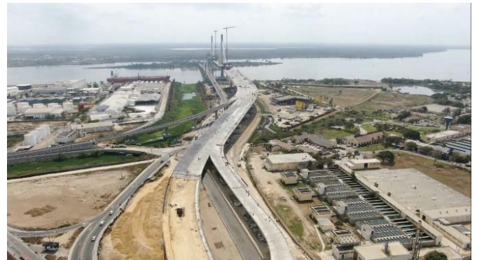
Figura 7. Vista aérea del viaducto de acceso de la margen izquierda y los ramales
