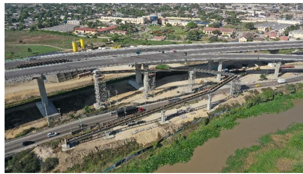
Figura 10. Vista de pasarela Norte durante su construcción
