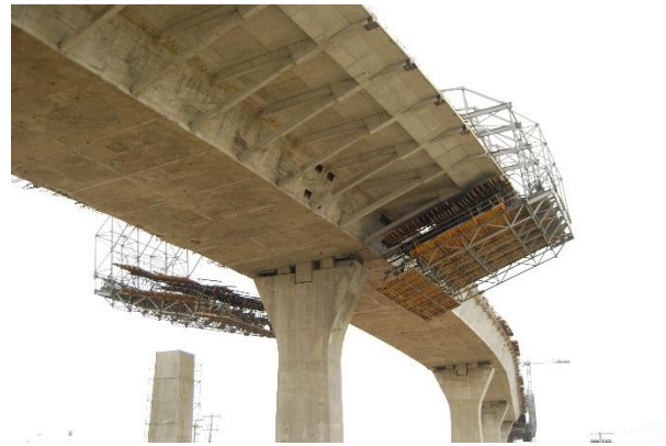
Figura 17. Ejecución de los voladizos laterales con carro de alas
