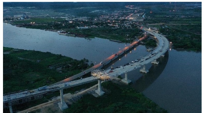
Figura 6. Vista del viaducto de acceso de la margen derecha
