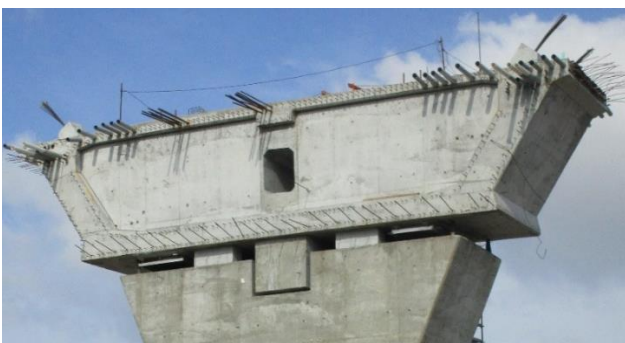
Figura 14. Mamparo con dados de hormigón provisionales y anclajes provisionales.
