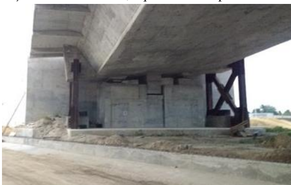
Figura 16. Puntos fijos provisionales en fase constructiva
