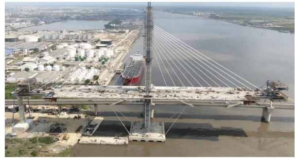
Figura 20. Vista aérea del pilono P14 en la que se aprecian los cables de arriostramiento inferiores
