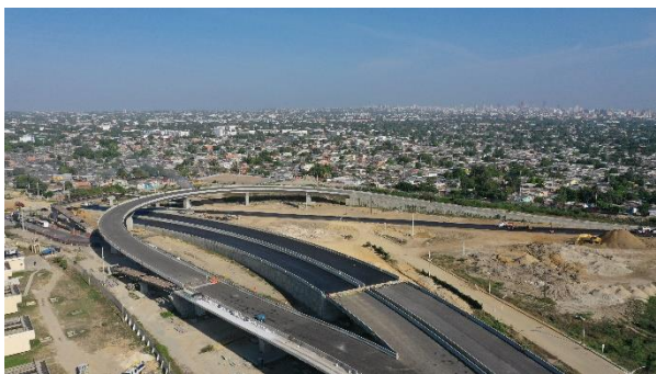
Figura 9. Vista aérea del Ramal Sur
