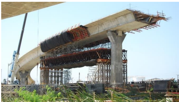
Figura 8. Construcción del Ramal Norte
