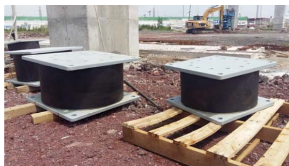
Figura 16. Aparatos de neopreno con núcleo de plomo D_{ext}=700 mm.
