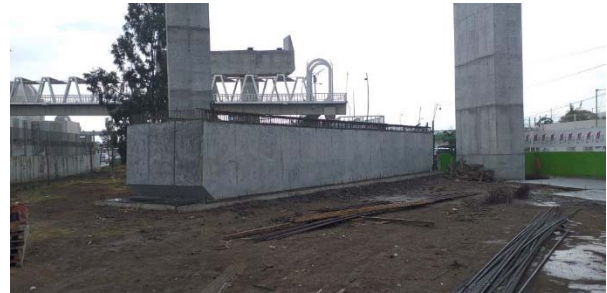
Figura 5. Fotografía de dintel prefabricado preparado para el izado y montaje sobre los fustes.
