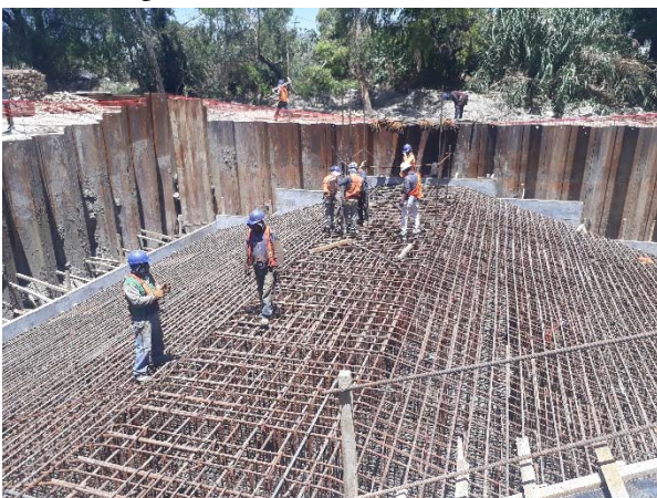
Figura 12. Ferrallado de encepado de canto variable.
