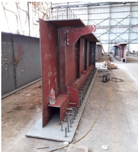
Figura 3. Fabricación en taller de un tramo de viga metálica.
