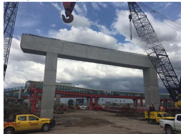
Figura 10. Pila en pórtico de hormigón P46.
