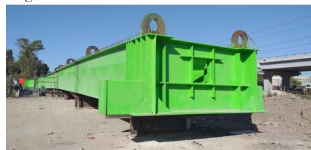
Figura 14. Tramo metálico preparado para ser izado.
