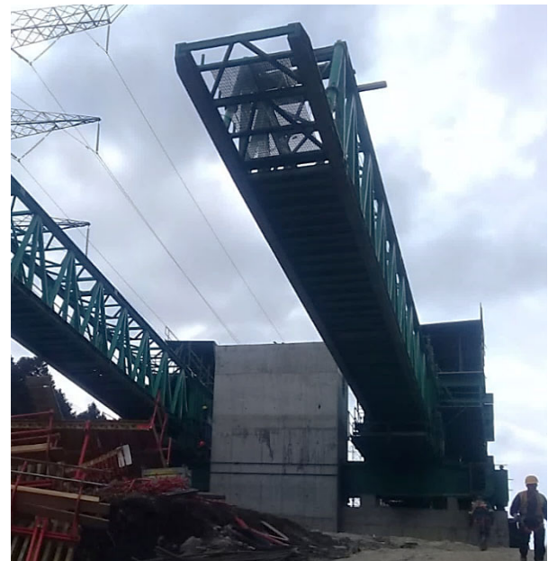
Figura 15. Imagen del lanzamiento de la segunda autocimbra, apoyada en los fustes provisionales.
