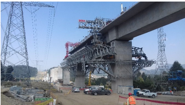
Figura 14. Imagen de la primera autocimbra durante la ejecución del tablero.
