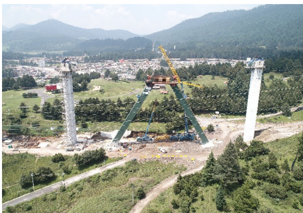
Figura 19. Vista general de la pila 4-13 tras el izado de ambos fustes.
