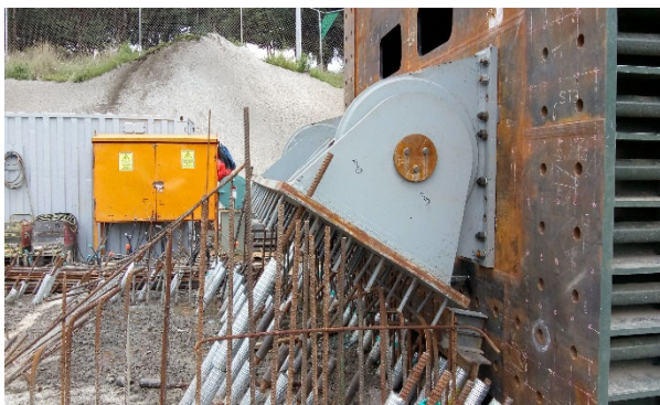
Figura 18. Vista de detalle de la rótula de giro.
