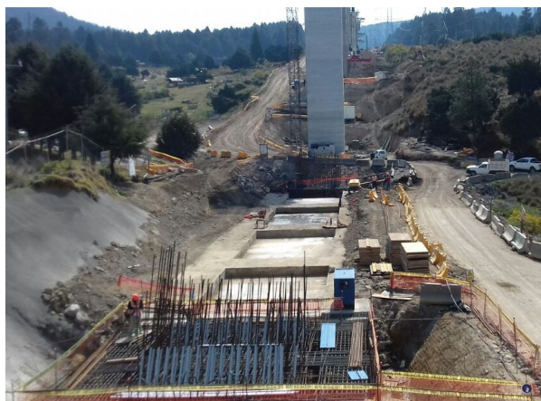
Figura 5. Imagen general de la ejecución de la cimentación de la pila 4-13
