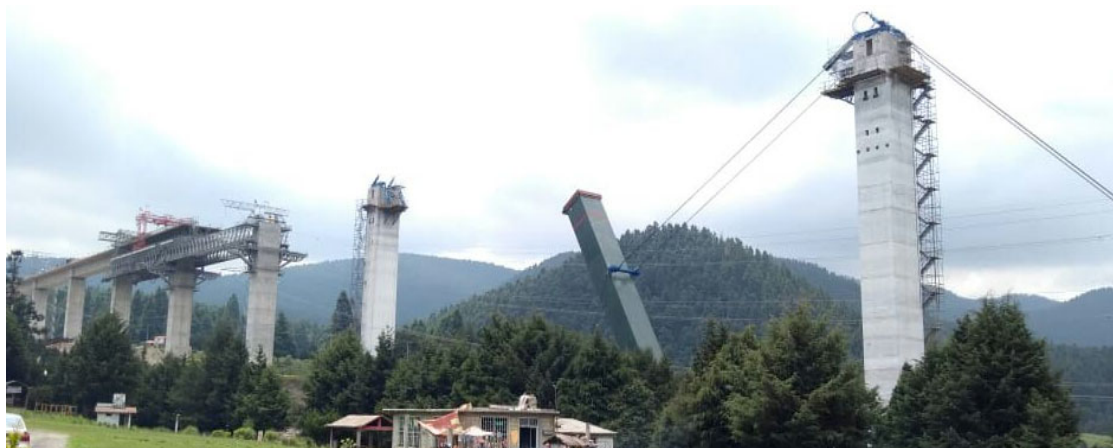
Figura 3. Imagen general del Viaducto 4 durante el izado de uno de los fustes del apoyo 4-13
