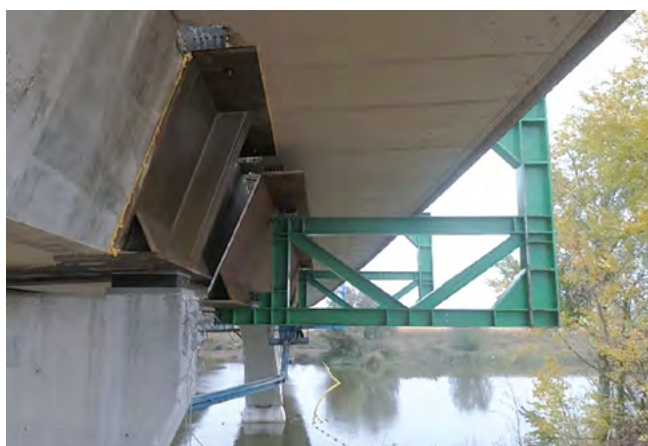
Figura 29. Montaje de dovelas.
