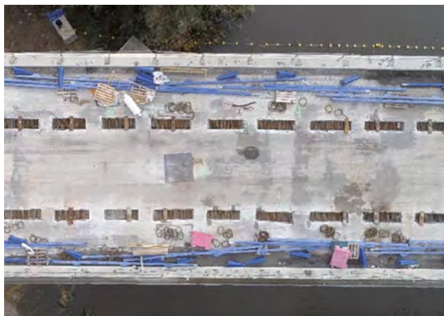
Figura 25. Vista en planta de la estructura con las ventanas ejecutadas en los voladizos para alojar los pernos conectadores de la platabanda superior.
