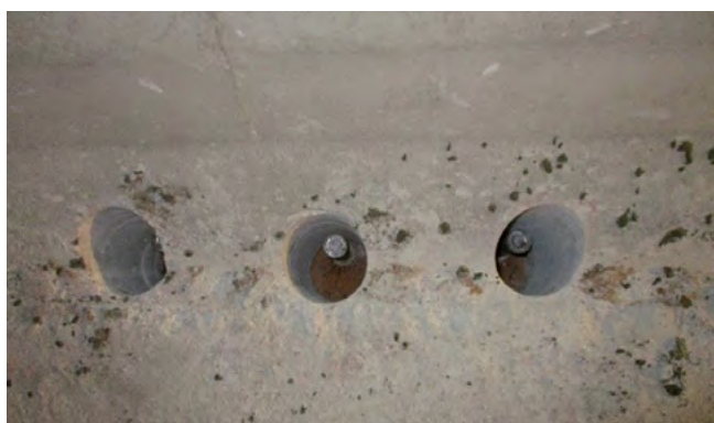
Figura 11. Soldeo de pernos en el interior de un cajón de hormigón.
