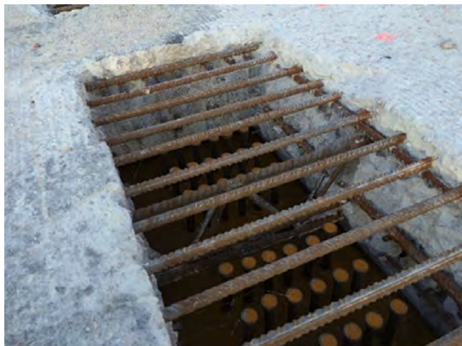
Figura 10. Hidrodemolición de una losa de hormigón para albergar los pernos conectadores de la futura sección mixta.
