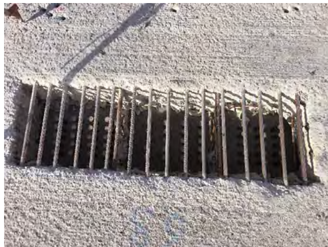
Figura 10. Hidrodemolición de una losa de hormigón para albergar los pernos conectadores de la futura sección mixta.
