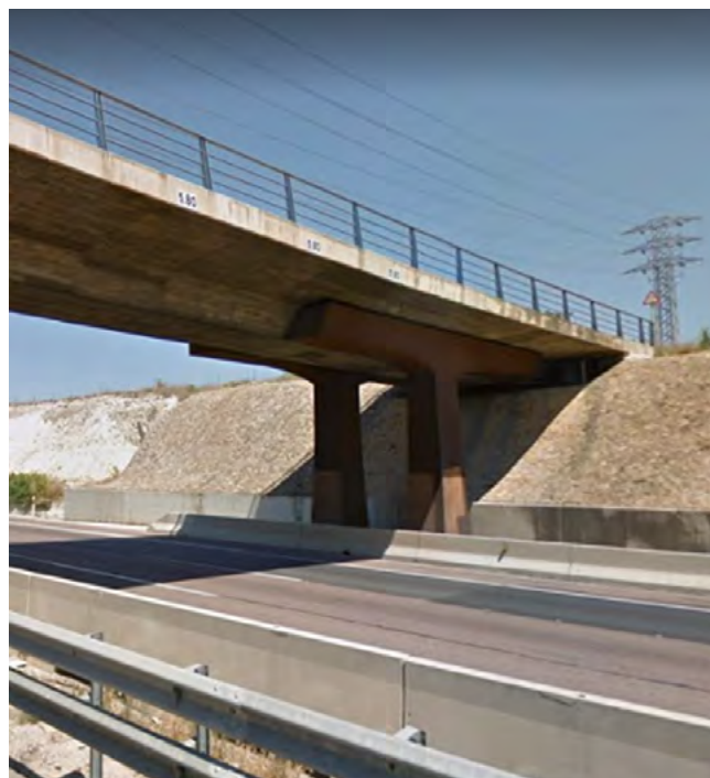
Figura 8. Ampliación de luces en paso superior mediante pescante metálico.
