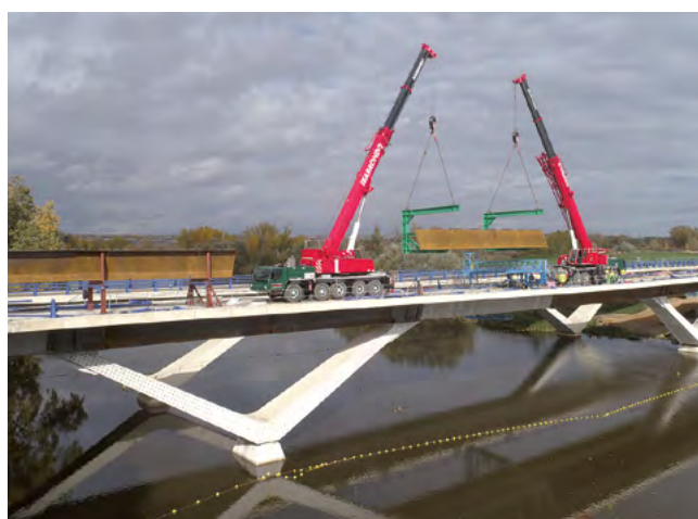
Figura 28. Montaje de dovelas.
