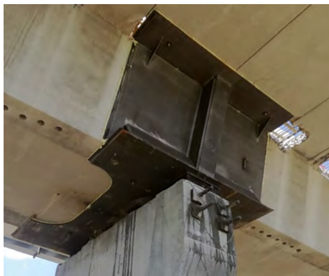
Figura 20. Montaje de dovelas de pila.
