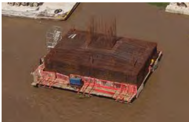
Figura 17. Cimentación ejecutada en agua.
