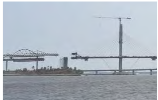
Figura 30. Autocimbra en avance a vano 11.
