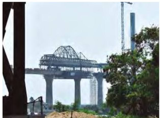
Figura 34. Punto fijo en margen derecha.
