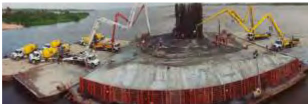
Figura 49. Hormigonado encepado pilono P13 desde pontonas.
