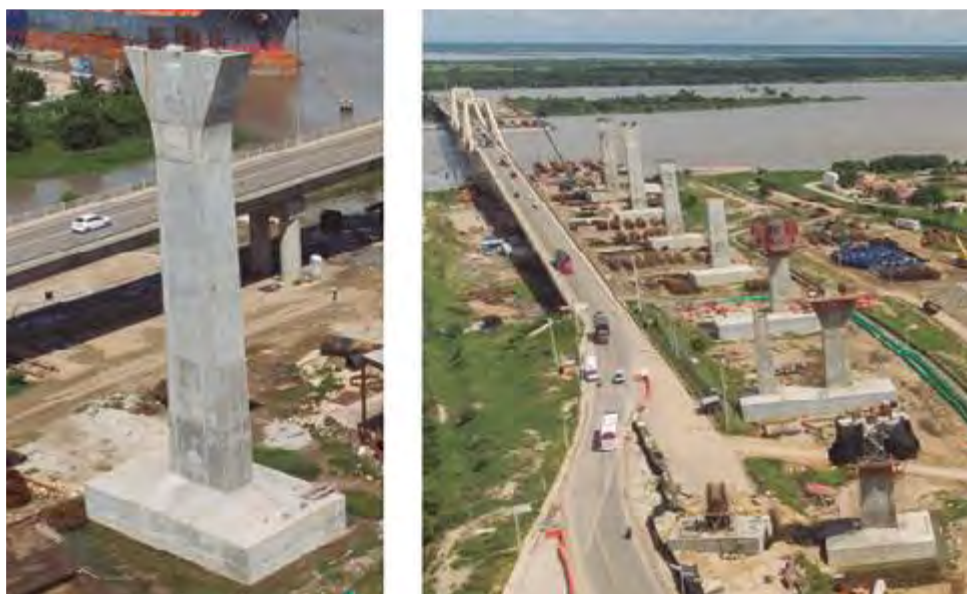
Figura 18. Alzado de fuste y capitel de las pilas de los vanos de acceso. Fustes pilas ejecutadas.
