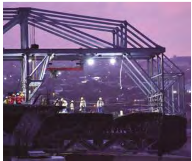
Figura 26. Carro de alas en viaductos de acceso.
