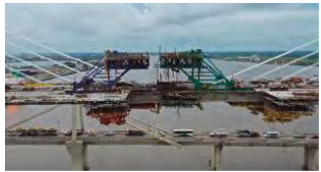
Figura 39. Ejecución de la dovela de cierre de centro de vano atirantado, en el que se aprecian tanto el sistema de fijación de la dovela de cierre como los carros de alas 2-3 dovelas por detrás.
