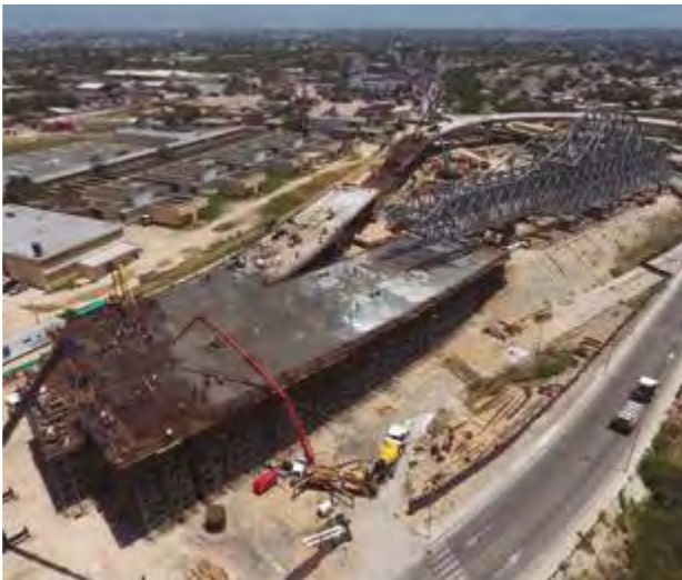
Figura 24. Montaje autocimbra en el lado Barranquilla.
