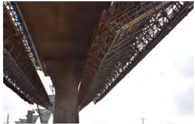
Figura 29. Autocimbra en avance a vano 21.
