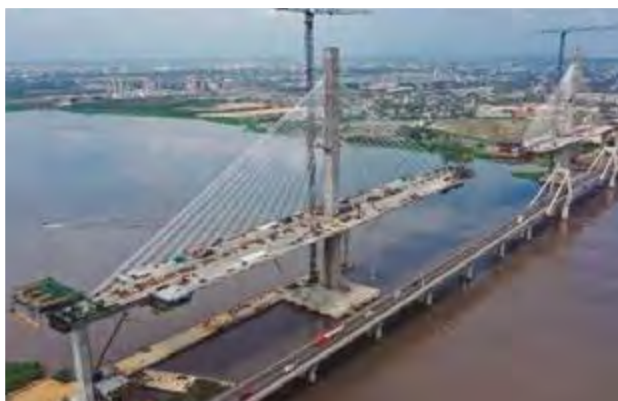
Figura 40. Vista de los carros de avance por voladizos sucesivos y los carros de alas 3 dovelas por detrás.
