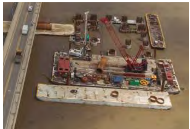
Figura 48. Ejecución pilotes encepado pilono P13 desde pontonas.
