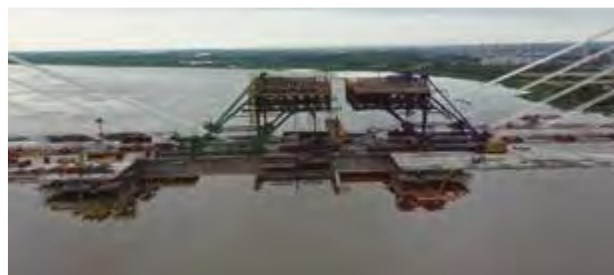
Figura 53. Vigas de continuidad en cierre vano principal.
