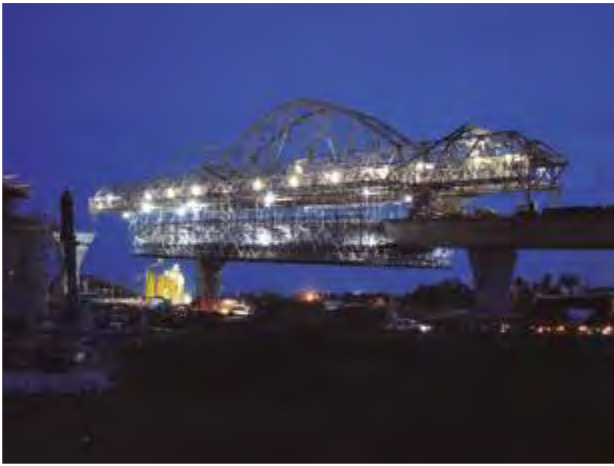
Figura 23. Autocimbra en posición de hormigonado.
