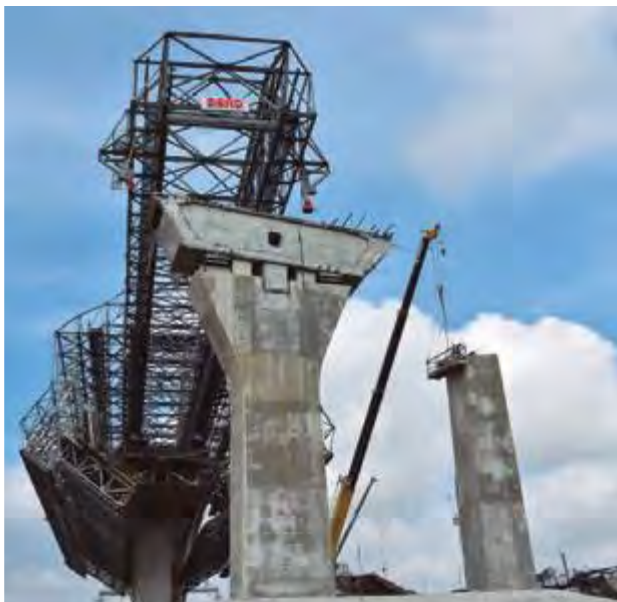
Figura 28. Autocimbra en avance a vano 21.
