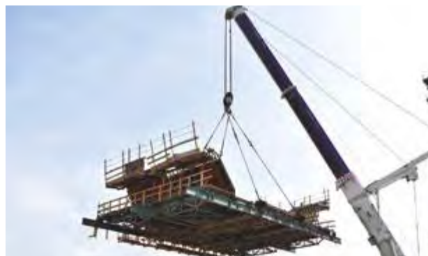
Figura 52. Flanqueo plataforma inferior carro de avance pila 12.
