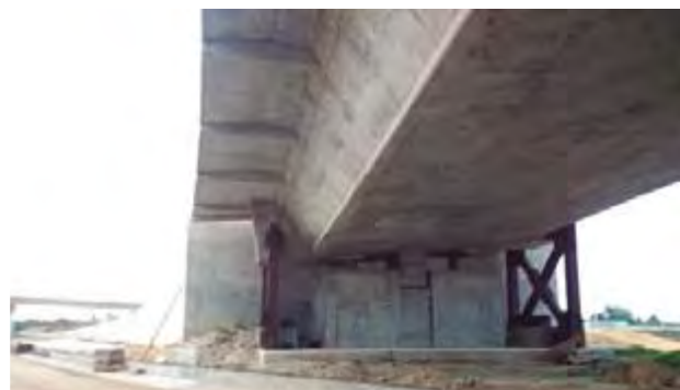
Figura 22. Puntos fijos provisionales en fase constructiva.
