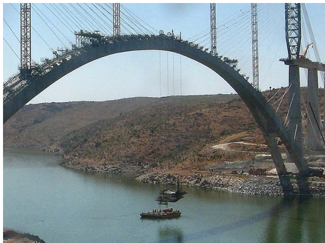
Figura 14. Descenso del carro lado norte.
