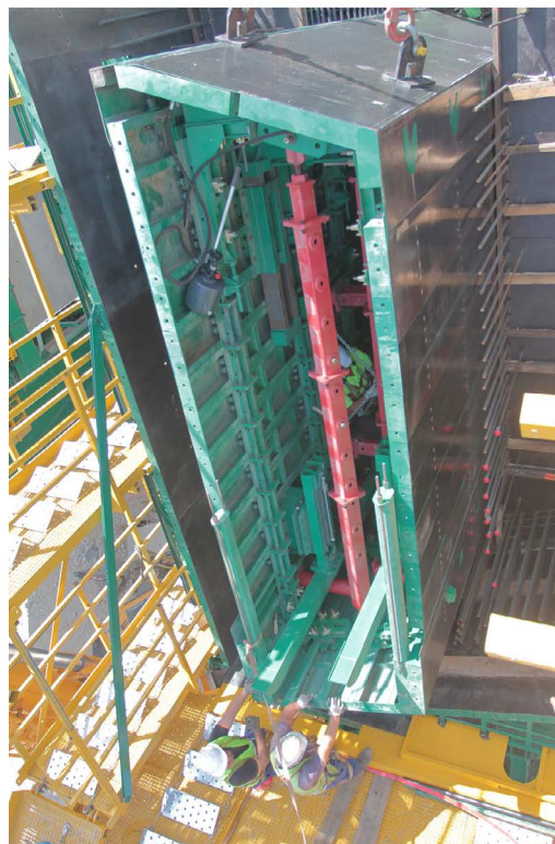
Figura 16. Detalle de paneles de encofrado interior.
