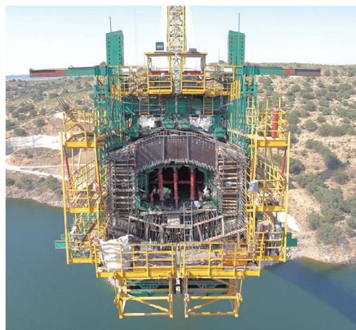
Figura 15. Detalle de paneles de encofrado interior.
