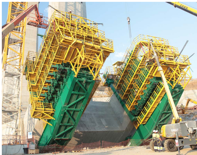
Figura 2. Carros de encofrado montados sobre el arranque.
