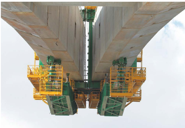
Figura 12. Vista trasera desde el estribo de los carros una vez realizada la maniobra de unión de carros.
