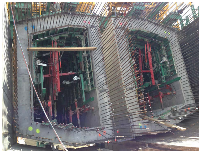
Figura 15. Detalle de paneles de encofrado interior.
