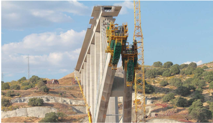
Figura 10. Detalle de posición de los carros en desfase debido a la interferencia entre los dos carros.
