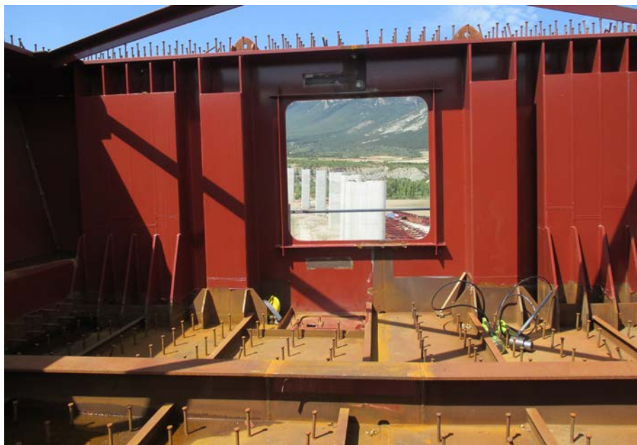
Fig. 8: Aspecto do banzo inferior junto ao septo de apoio sobre os pilares
