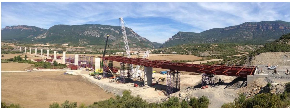
Fig. 16: Aspecto da obra (foto captada em Setembro deste ano)
