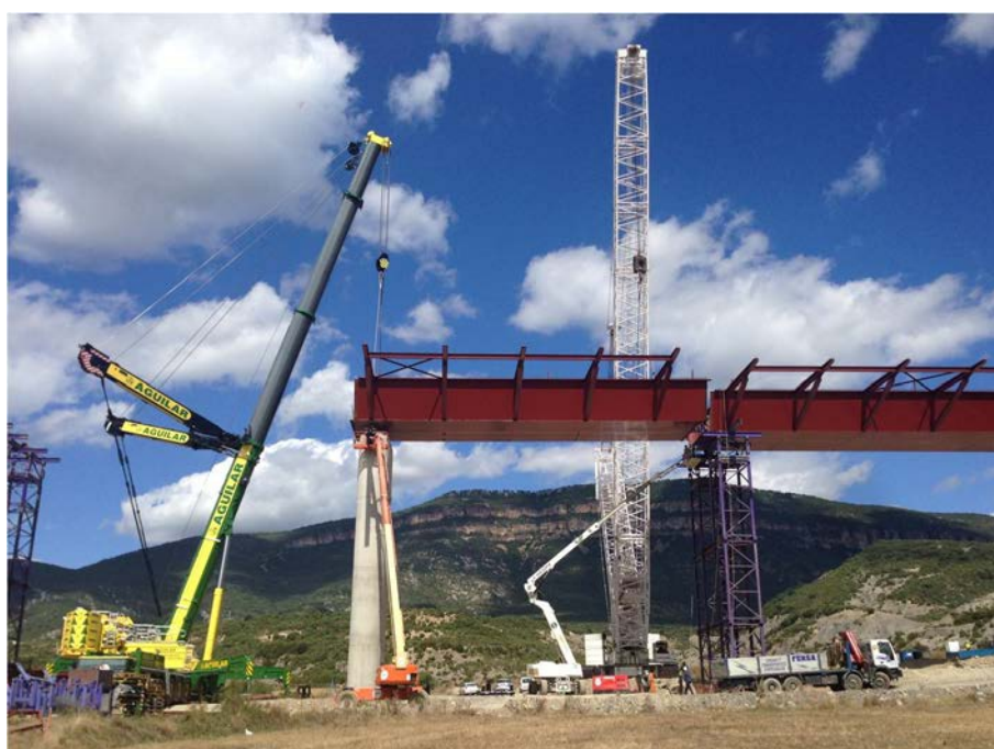
Fig. 14: Içamento de um dos tramos
