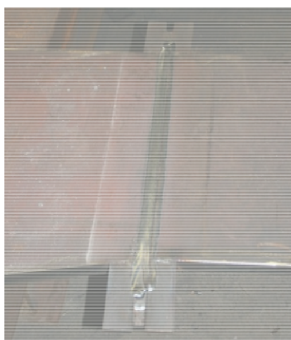
Figuras 11a y 11b. Soldadura con chapas de derrame y soldadura amolada sin sobreespesores
