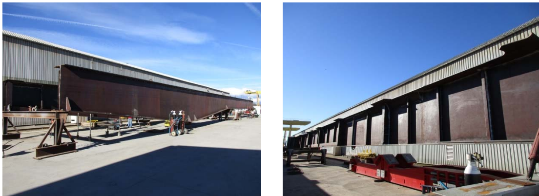
Figuras 15a y 15b. Imagen del Montaje en blanco de las primeras vigas.
