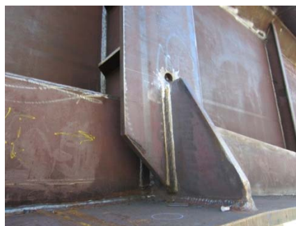
Figura 13a, 13b, 13c y 13d. Diafragmas transversales y detalles de rigidizadores verticales de almas.
