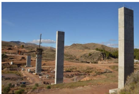
Figura 7. Vista general de la ejecución de las pilas.
