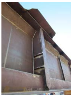
Figura 13a, 13b, 13c y 13d. Diafragmas transversales y detalles de rigidizadores verticales de almas.
