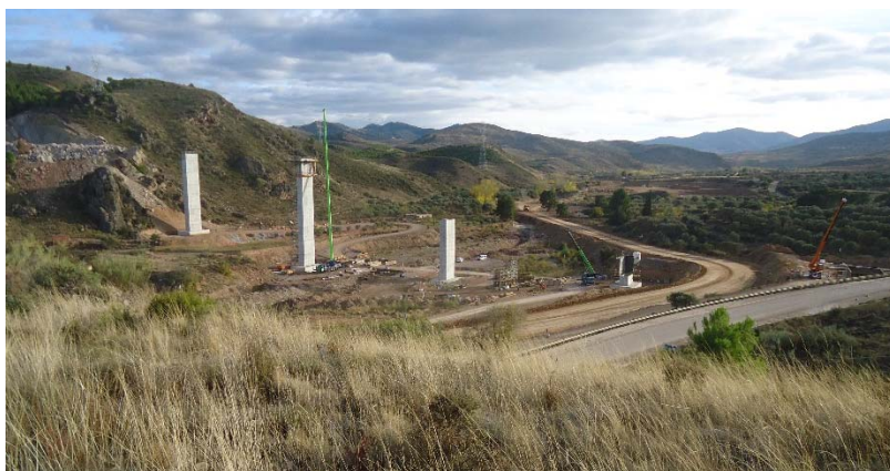
Figura 1. Vista general de la traza del puente con las pilas en ejecución en la zona del futuro embalse (enero 2017)
