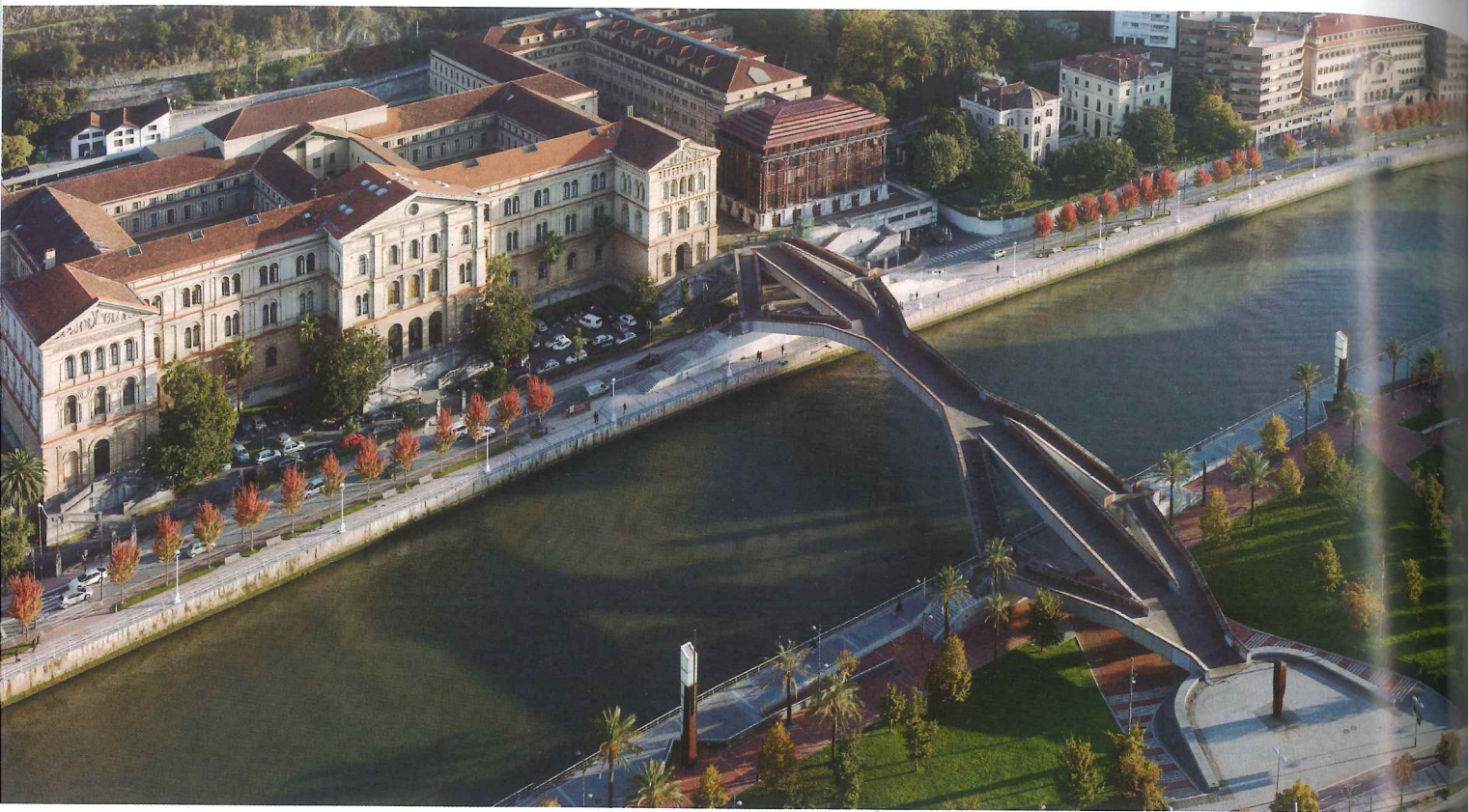
Vista aérea completa del puente
