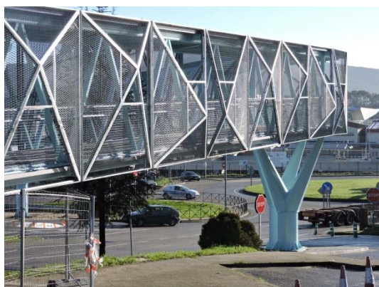
Figura 4a y 4b. Detalle del cerramiento lateral e iluminación de la pasarela
