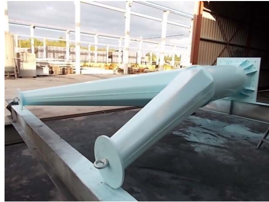
Figuras 10a y 10b. Detalle del sistema de protección anticorrosiva de la estructura metálica mediante pintura
