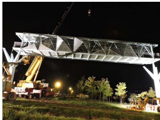
Figuras 11a y 11b. Montaje con grúa de estructura metálica (pilas y celosía)
