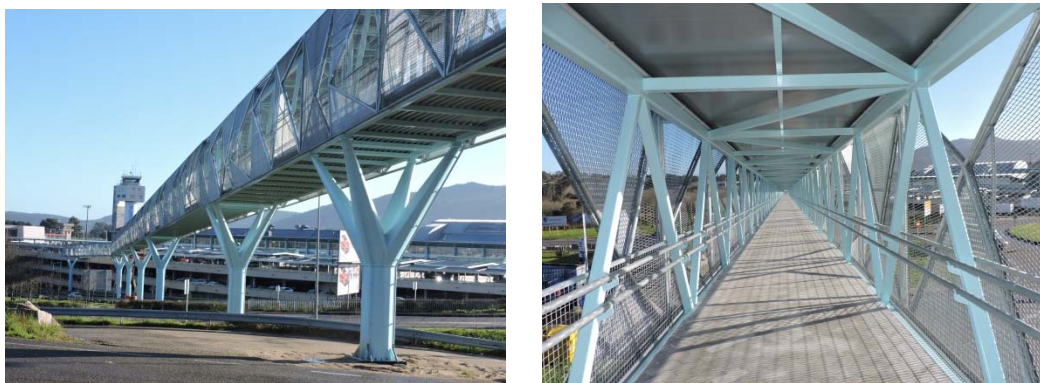
Figura 1a y 1b. Vista general y detalle del interior de la Pasarela Peatonal entre el aeropuerto de Vigo-Peinador y el Instituto Ferial de Vigo (IFEVI)
