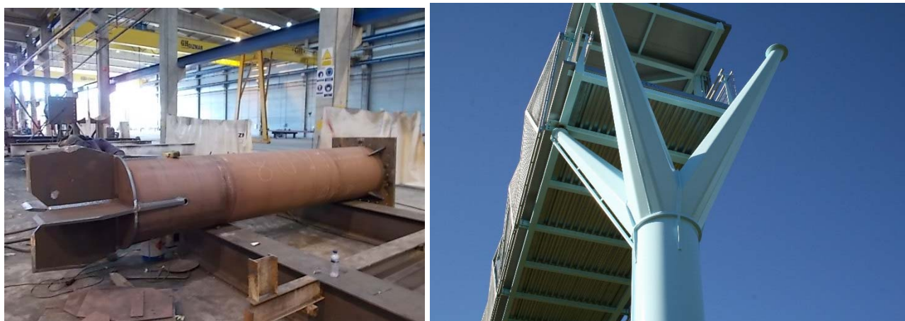
Figuraa 15a y 15b. Imágenes del nudo de conexión de las ramas con el fuste de una pila
