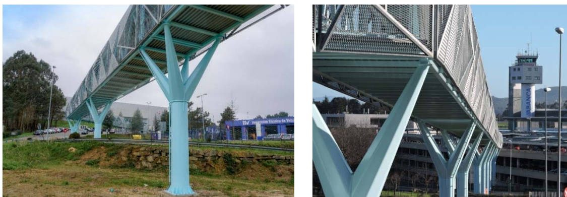
Figuras 6a y 6b. Vista general de las pilas de la pasarela
