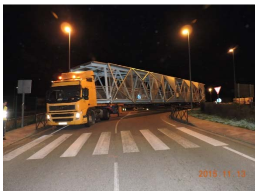
Figuras 12a y 12b. Transporte a obra en camión de las estructuras metálicas
