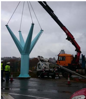
Figuras 11a y 11b. Montaje con grúa de estructura metálica (pilas y celosía)
