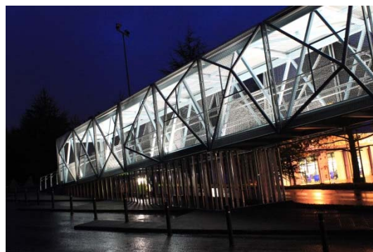
Figura 4a y 4b. Detalle del cerramiento lateral e iluminación de la pasarela
