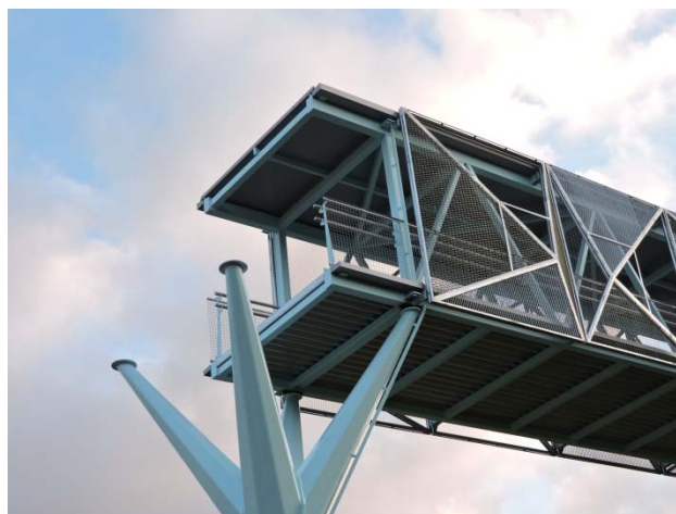
Figuras 14a y 14b. Mecanismo resistente frente a acciones transversales
