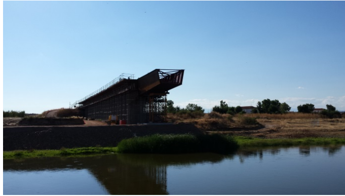
Figura 9. Colocación de estructura metálica de conexión con el sección de hormigón pretensado.
