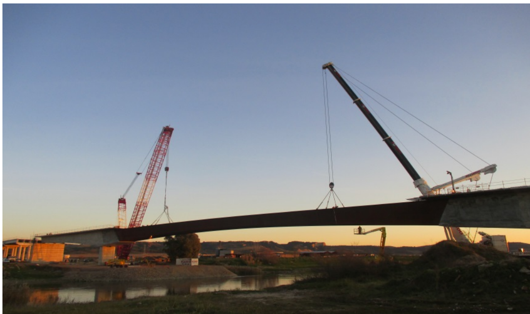
Figura 13. Posicionamiento del tramo central para su unión con el resto
