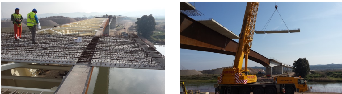
Figura 15. Colocación de prelosas
