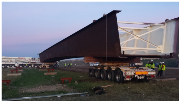
Figura 11. Aproximación tramo central al cauce
