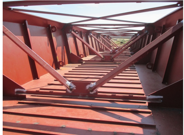
Figura 2. Sección mixta del tramo central
