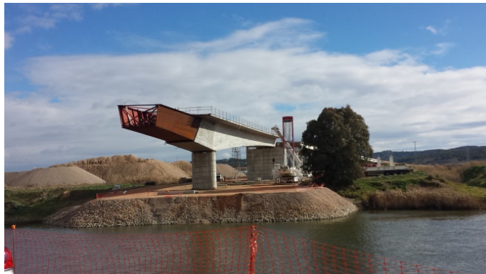
Figura 10. Descimbrado vanos laterales y retirada de apeo provisional para montaje de primer tramo metálico
