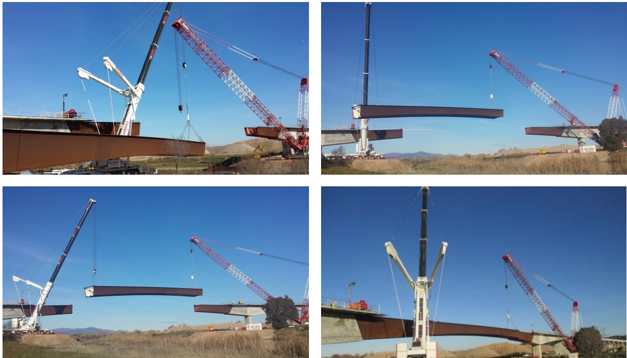
Figura 12. Elevación del tramo central mediante grúas situadas en ambos márgenes del cauce
