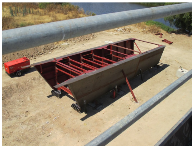
Figura 5. Sección de conexión sección de hormigón con sección metálica
