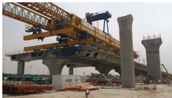
Figura 9. Detalle de elevación de dovelas prefabricadas gracias a la viga lanzadera.
