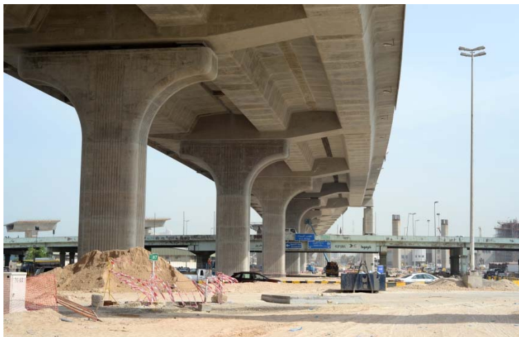
Figura 4. Vista inferior del tronco en zona de incorporación de rampa
