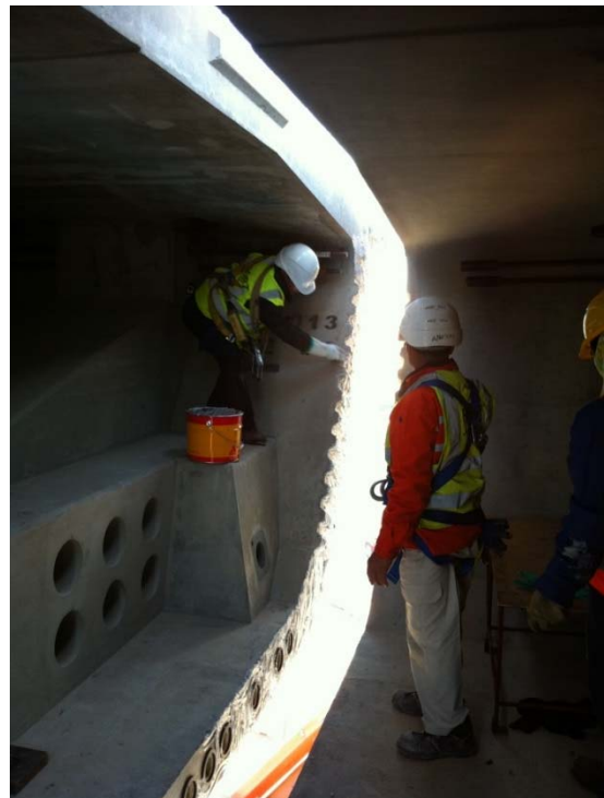
Figura 8. Detalle de unión de dovelas prefabricadas. Aplicación de resina epoxi.
