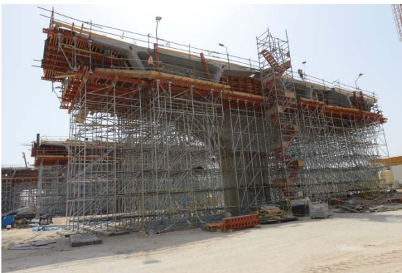
Figura 6. Ejecución de diafragmas sobre pilas. Montaje de dovelas prefabricadas.
