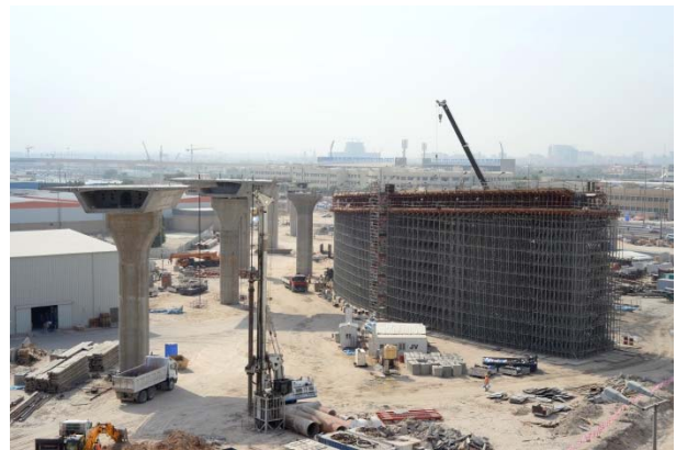
Figura 14. Tramos de rampas ejecutando cimbrados.
