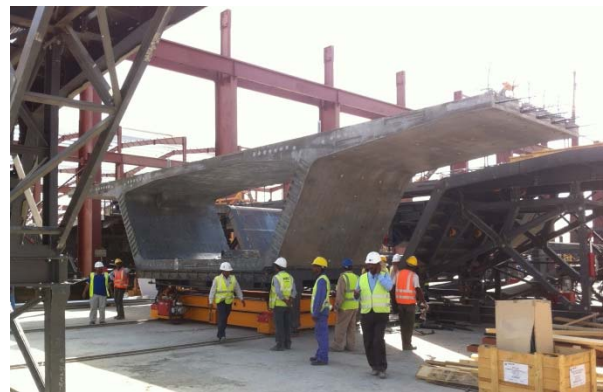
Figura 6. Ejecución de diafragmas sobre pilas. Montaje de dovelas prefabricadas.
