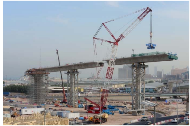
Figura 13. Ejecución de avance en voladizo ayudado de torres provisionales.
