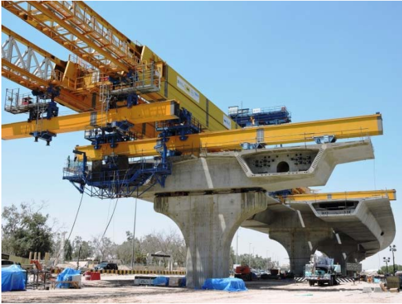
Figura 7. Detalle de viga lanzadera.
