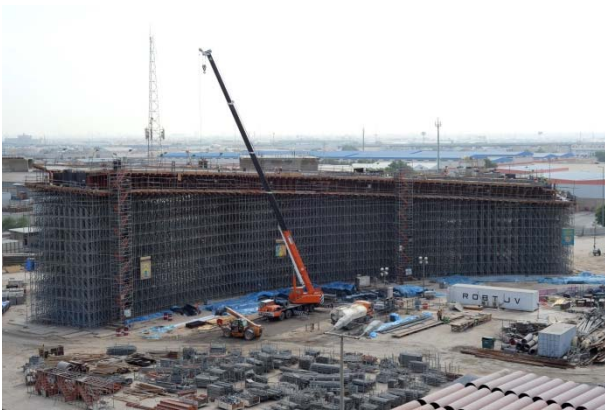
Figura 14. Tramos de rampas ejecutando cimbrados.
