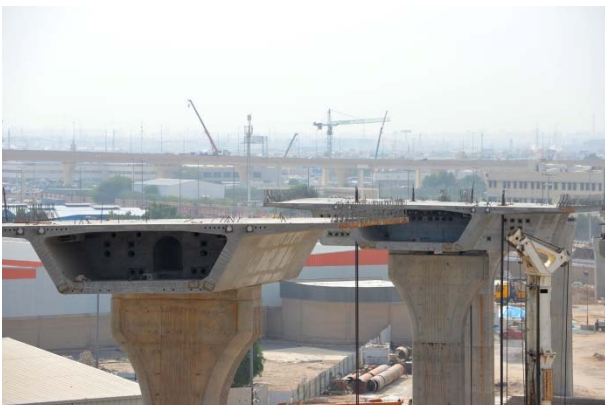
Figura 12. Ejecución de pilas y primeras dovelas.
