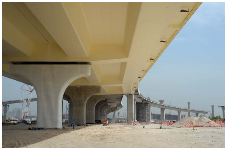
Figura 2. Vista inferior del tablero del tronco principal en el encuentro de una de las rampas de acceso.
