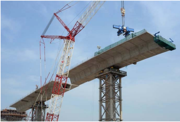
Figura 13. Ejecución de avance en voladizo ayudado de torres provisionales.
