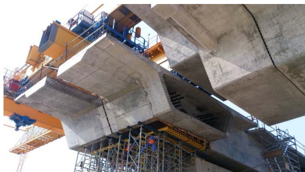
Figura 9. Detalle de elevación de dovelas prefabricadas gracias a la viga lanzadera.
