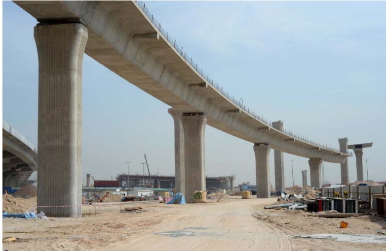
Figura 10. Alzado tipo de rampa de canto constante.
