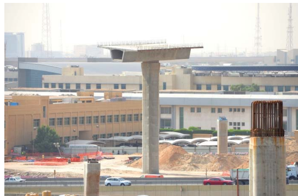
Figura 12. Ejecución de pilas y primeras dovelas.
