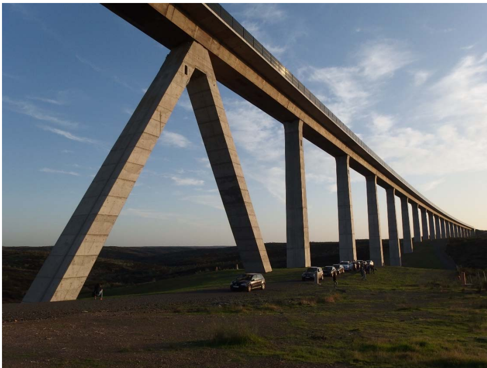
Figura 8. Vista de la pila delta con el viaducto construido
