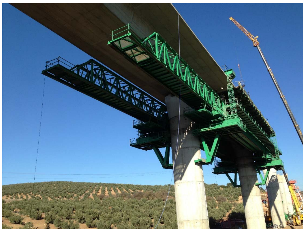
Figura 6. Tablero durante la construcción con la autocimbra
