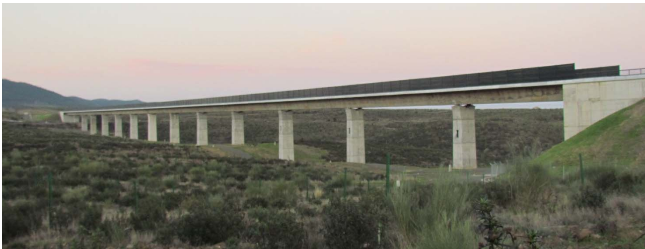
Figura 3. Viaducto de Pizarroso
