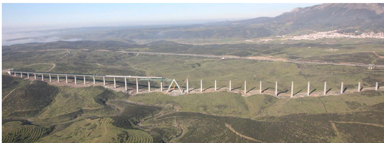
Figura 2. Vista aérea del puente durante la construcción
