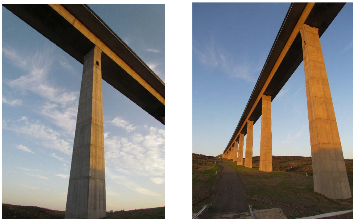
Figura 7. (a) Alzado de pila tipo. (b) Visión de conjunto desde la cercanía al viaducto
