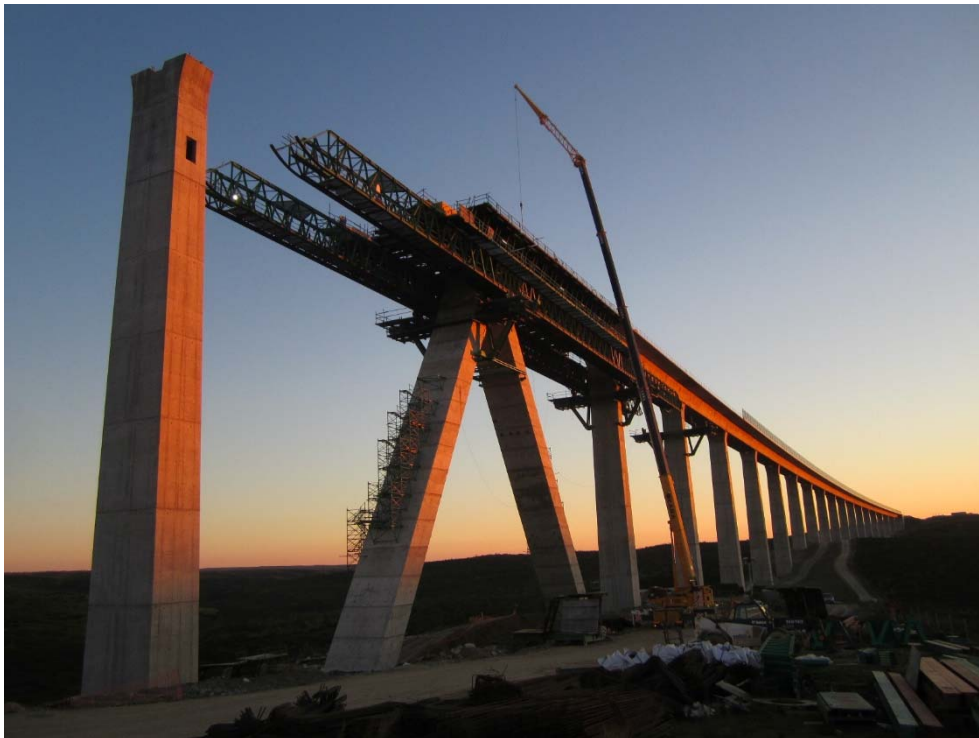
Figura 10. Paso de la autocimbra sobre la pila delta
