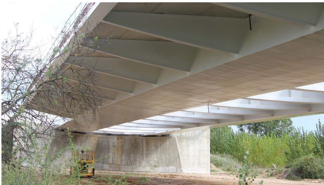
Figura 4. Vista inferior del tablero: cajón, costilla, riostra y viga longitudinal de borde
