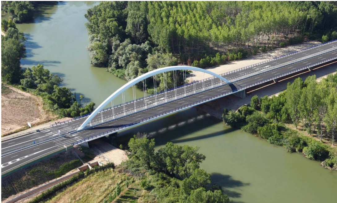
Figura 2. Vista general aérea del puente arco construido
