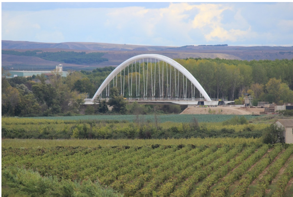
Figura 8. Vista general del puente durante la construcción
