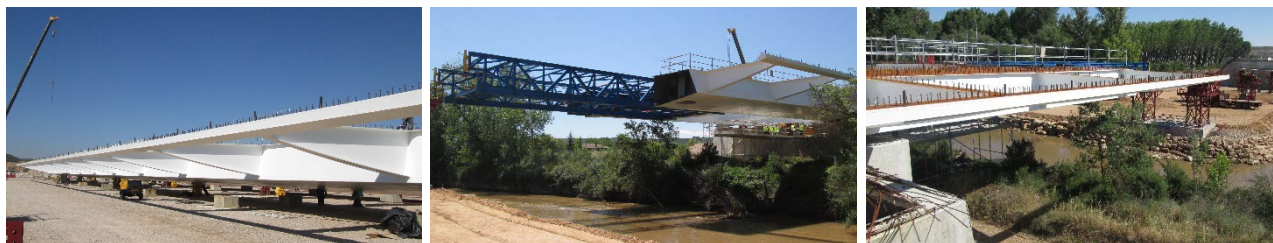
Figura 11. Puente durante el empuje: (a) Parque de empuje; (b) y (c) Tablero durante el empuje
