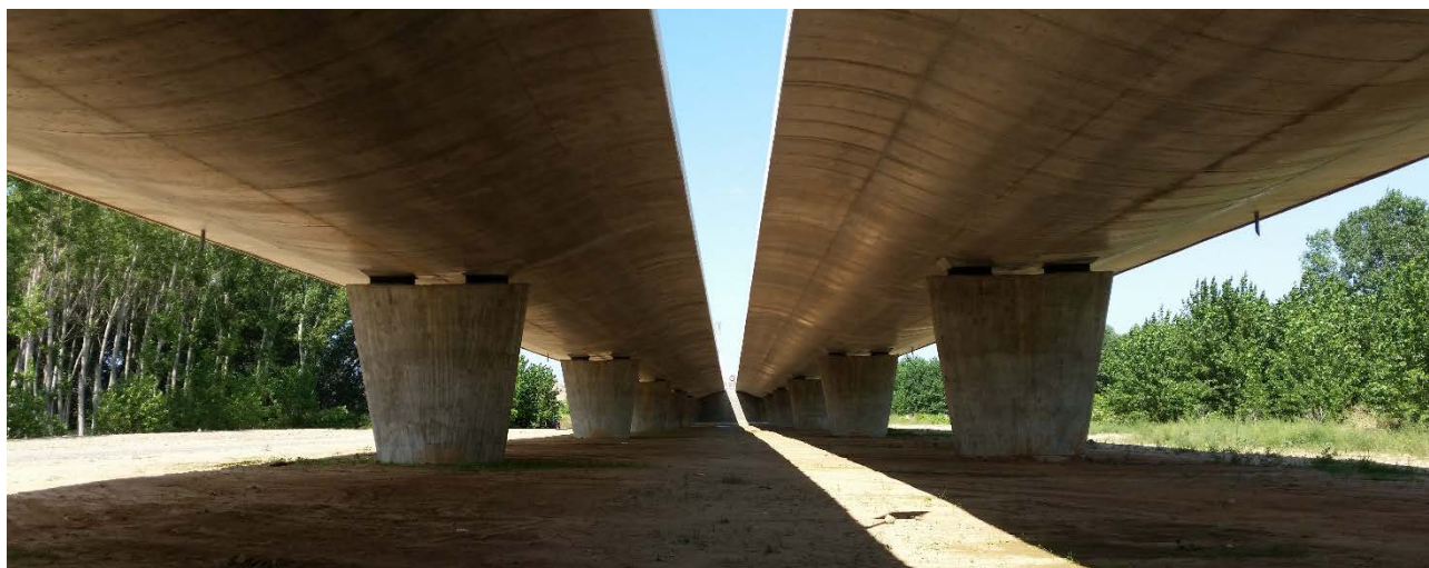
Figura 9. Viaducto de acceso. Vista inferior de los tableros gemelos tipo losa pretensada
