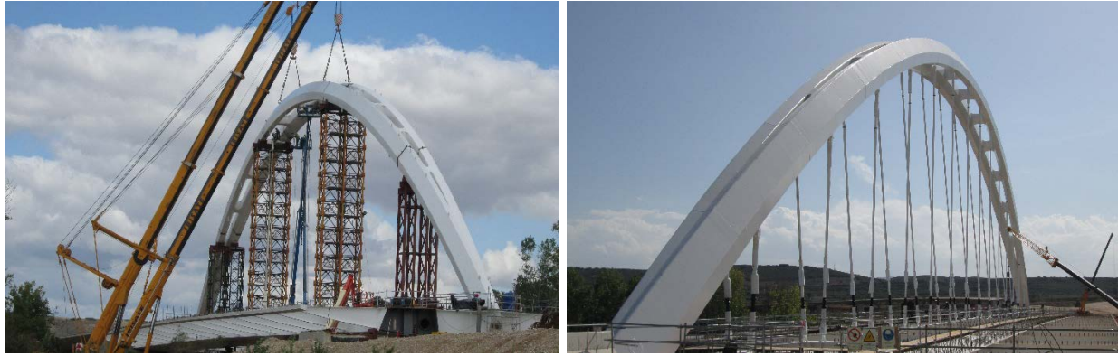
Figura 7. Arco durante la construcción
