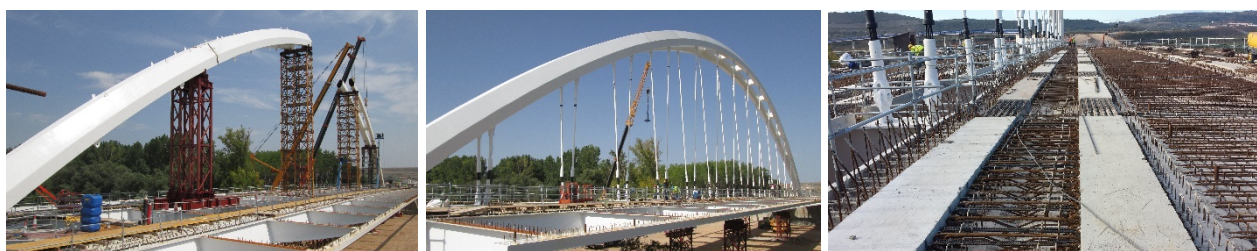
Figura 10. Montaje del arco y colocación de prelosas y ferralla de losa
