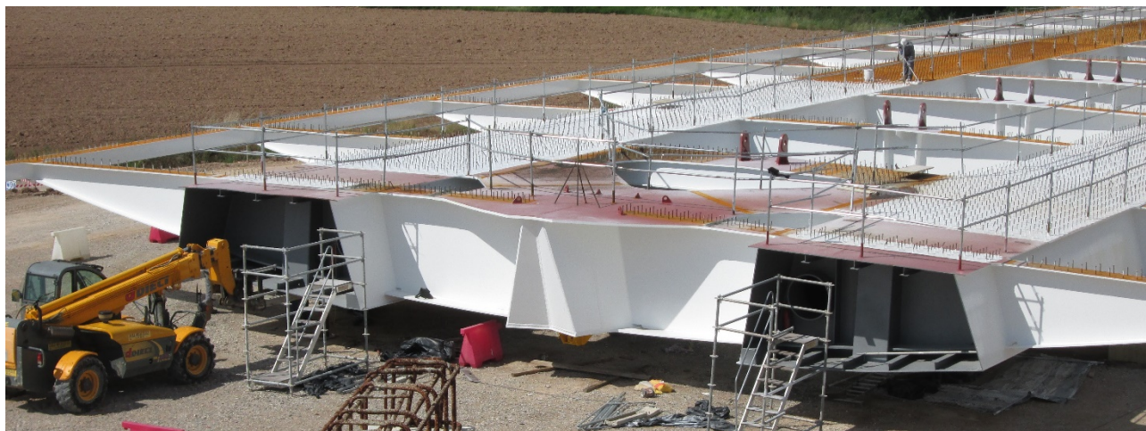
Figura 5. Tablero en parque de empuje. Mamparo sobre estribo y detalle de apoyo del arco
