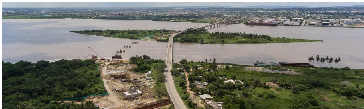
Figura 3. Foto aérea del puente en ejecución desde la margen derecha
