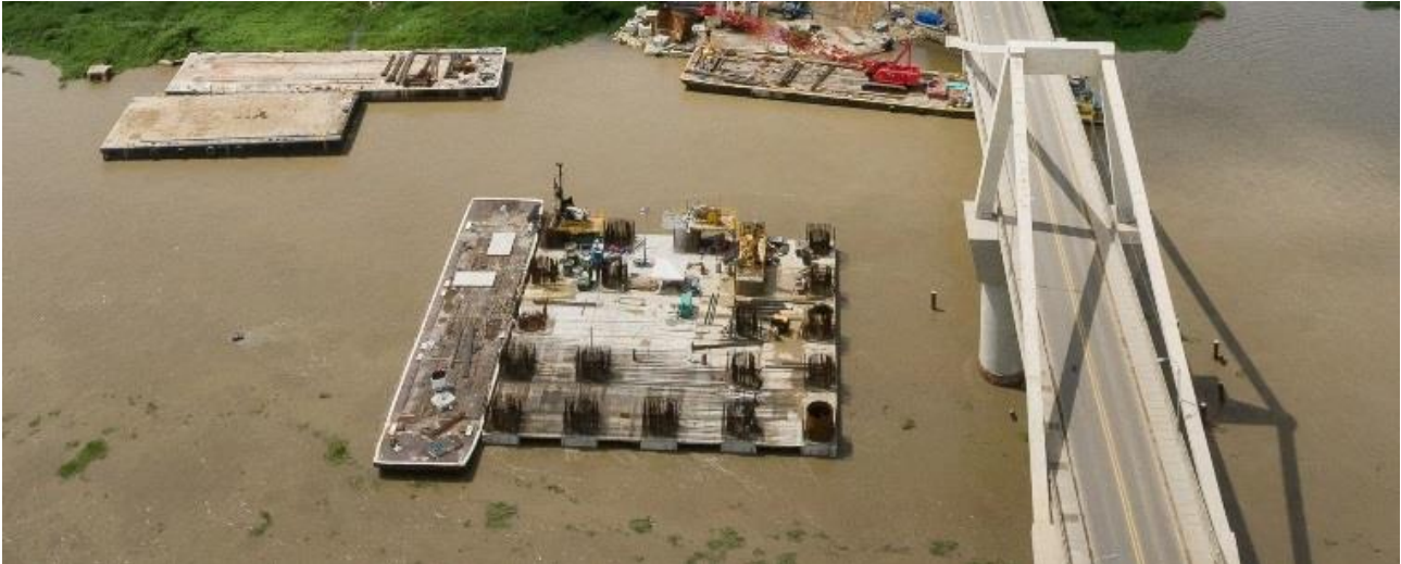
Figura 9. Derecha: cimentación del pilono P14 en ejecución
