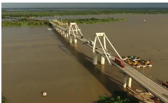
Figura 1. Vista del Puente Pumarejo actual
