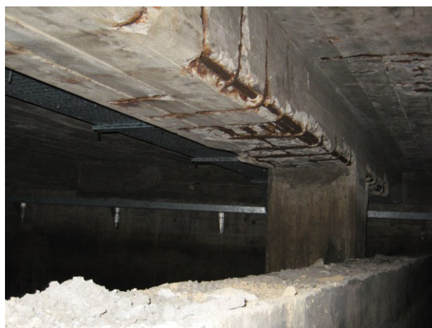
Figuras 7 y 8. Pérdida del hormigón de recubrimiento con importantes daños por corrosión de armaduras, tanto de cortante como de flexión, llegando incluso a la rotura de las barras.
