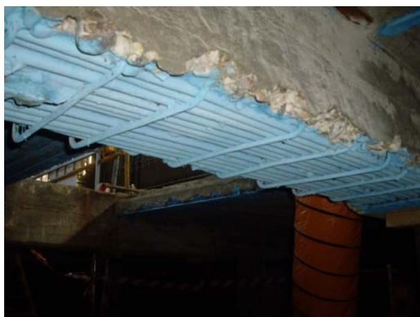
Figuras 15 y 16. Pasivado de armadura tras saneado y comprobación de sección resistente residual.
