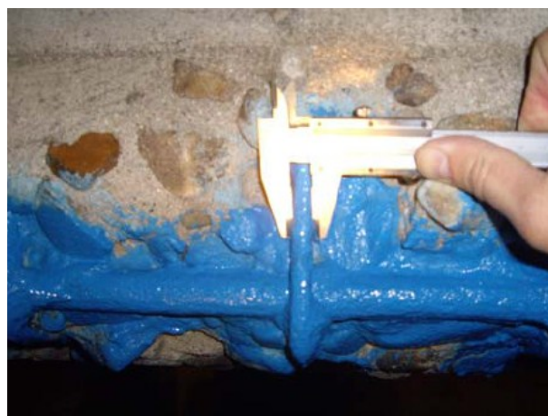
Figuras 15 y 16. Pasivado de armadura tras saneado y comprobación de sección resistente residual.
