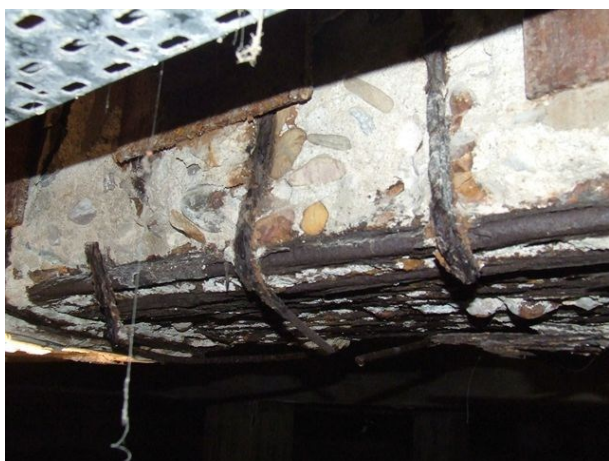
Figuras 7 y 8. Pérdida del hormigón de recubrimiento con importantes daños por corrosión de armaduras, tanto de cortante como de flexión, llegando incluso a la rotura de las barras.
