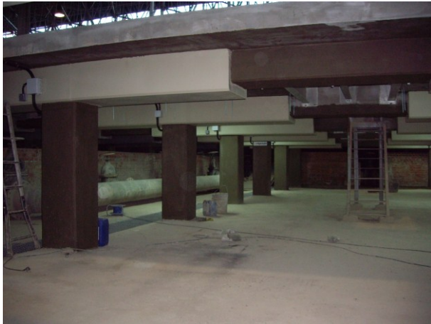
Figura 21. .Refuerzo de cortante de vigas totalmente terminado y protegido con pintura anticorrosión.
