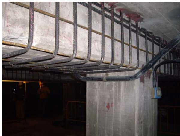
Figura 18. Vista de nudo ferrallado antes de encofrar y hormigonar.
