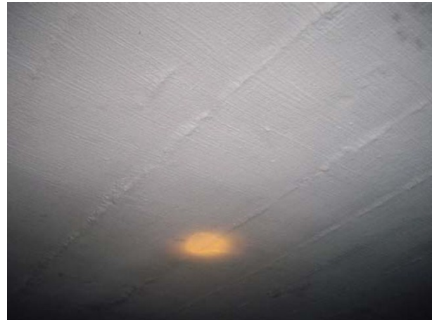
Figura 22. Detalle final de cara inferior de solera restituida con mortero de impermeabilización con malla de fibra de vidrio intermedia
