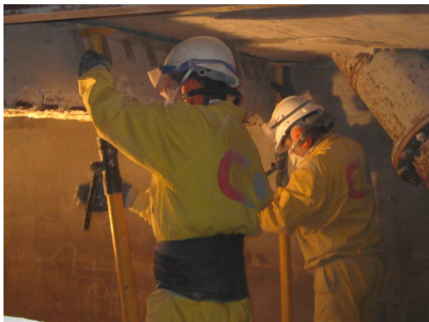
Figura 17. Detalle de plantilla para replanteo de taladros.
