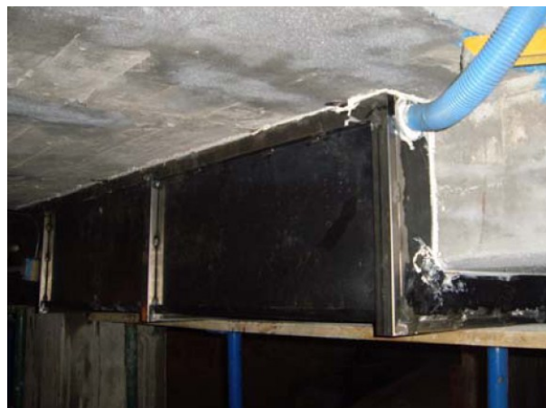
Figura 20. Encofrado metálico durante el hormigonado. Detalle de tubo de purga de aire y hormigonado (lateral opuesto).
