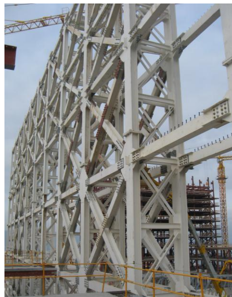
Figura 9b. Vista del pórtico de arriostramiento del eje E-E durante su construcción.
