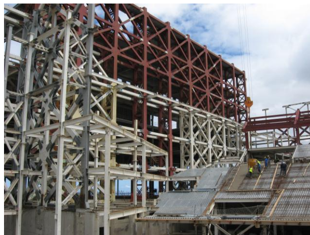
Figura 7b. Vista de los pórticos del eje O-O y del eje 26 durante la construcción.
