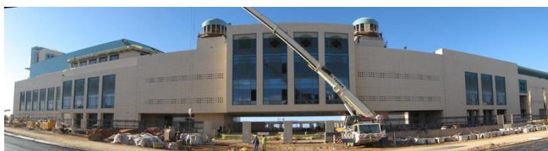
Figura 6b. Vista del Edificio Puente durante su construcción.
