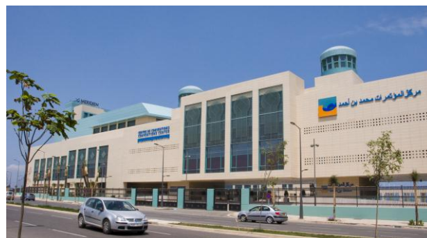
Figura 1b. Vista del Edificio Puente y del Edificio de Oficinas y Auditorio.
