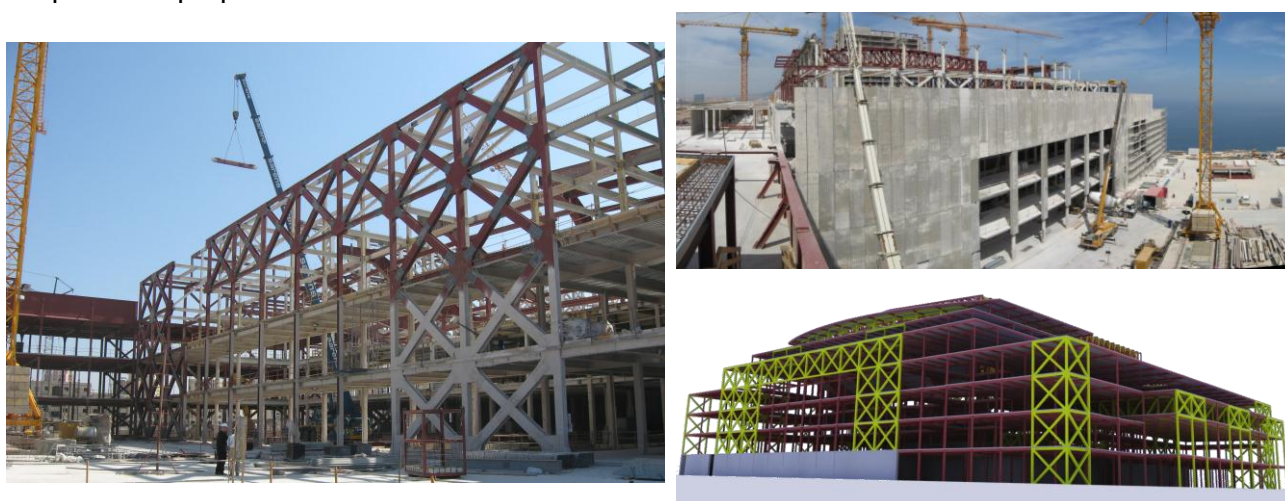
Figuras 12a, 12b, y 12c. Vista del pórtico de arriostramiento del eje 39 durante su construcción, Colocación de los paneles de fachada, y Esquema de su ubicación en el edificio.
