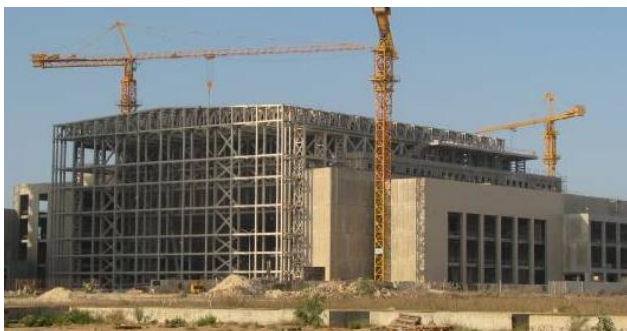
Figura 8a. Vista del Palacio de Congresos durante su ejecución.
