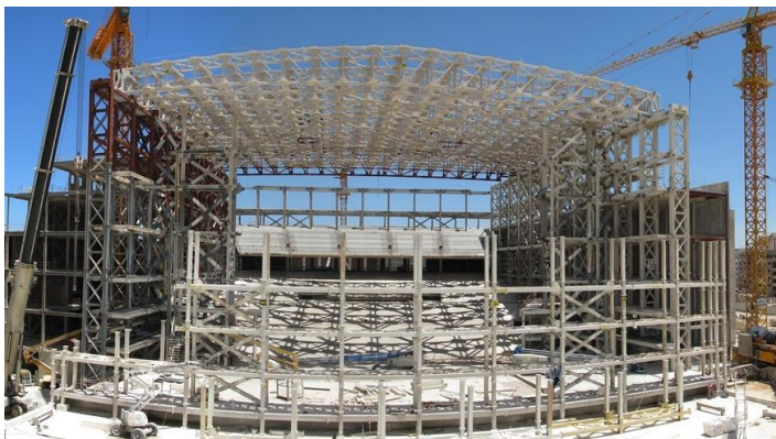
Figura 10a. Vista de la estructura del Auditorio durante su construcción.
