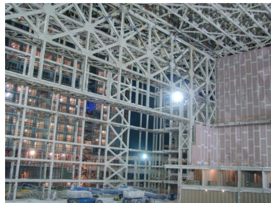
Figura 10b. Vista del pórtico de arriostramiento del eje 26 desde el interior del Auditorio durante su construcción.
