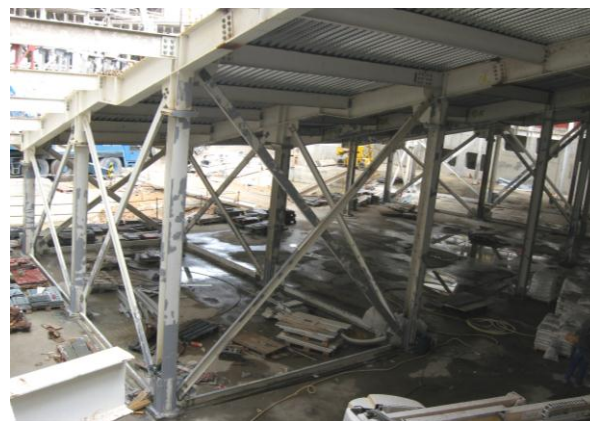
Figura 14b. Vista del arriostramiento del graderío bajo durante su ejecución.
