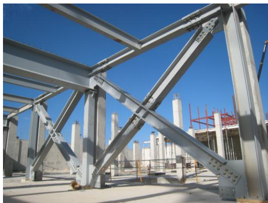
Figura 5b. arriostramientos sismorresistentes de la cubierta.
