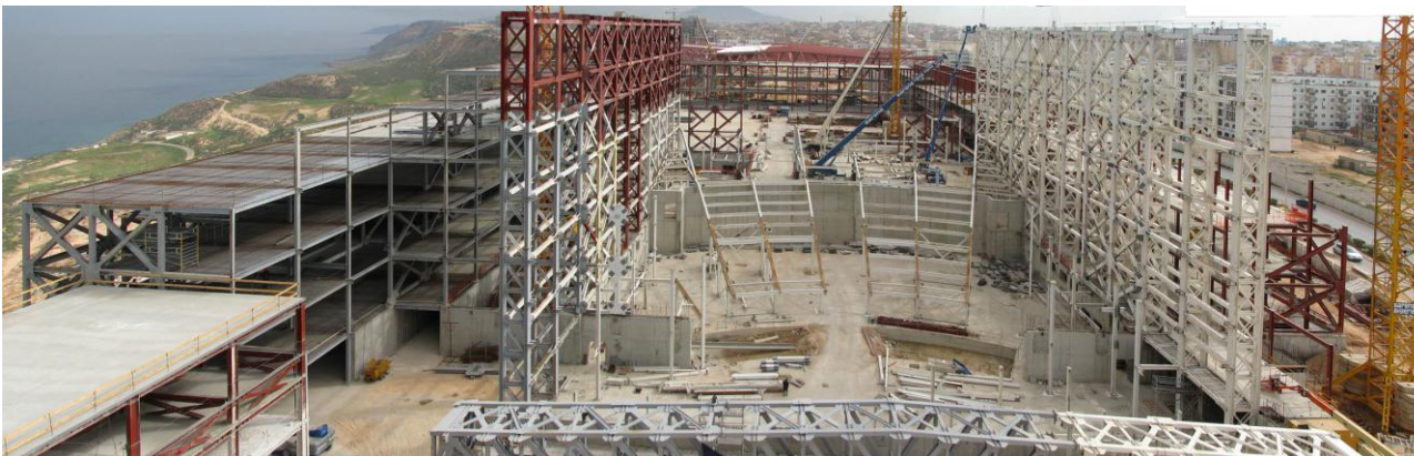
Figuras 7c. Vista de la caja central del auditorio durante la construcción.
