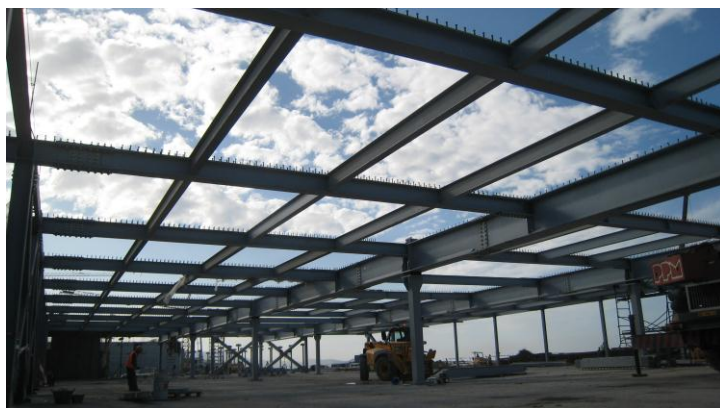
Figura 5a. Vista de la cubierta mixta del restaurante durante el montaje de la estructura metálica.
