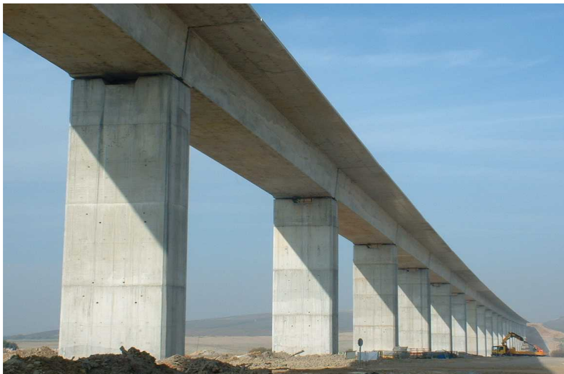
Figura 1. Viaducto sobre el Río Genil (L.A.V. Córdoba-Málaga).
