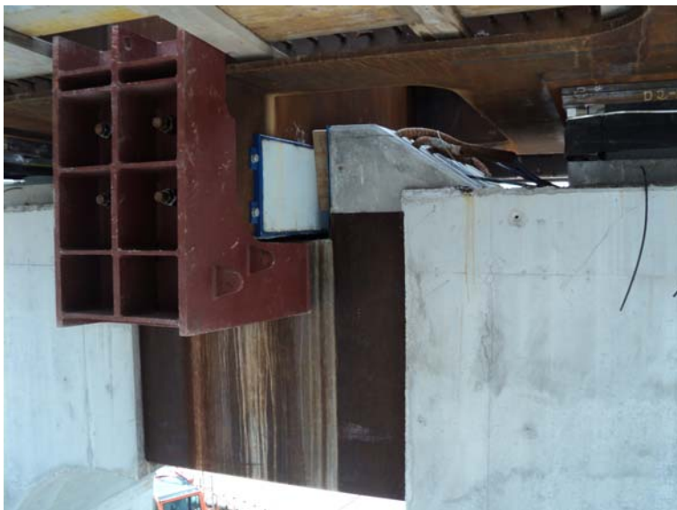
Figura 8. Viaducto de Archidona. Detalle de tope transversal.
