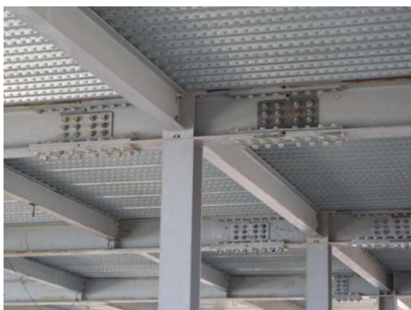
Figura 6a. Detalle de uniones atornilladas.
