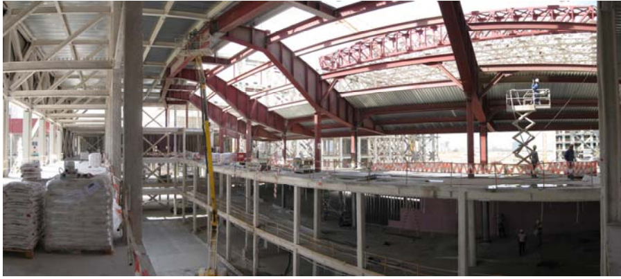
Figura 15. Vista trasera de las vigas principales del graderío superior durante la ejecución.
