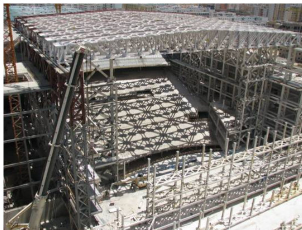
Figura 17. Vista de la cubierta prácticamente concluida.
