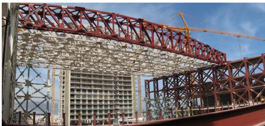
Figura 18. Vista de la cubierta durante la ejecución del ripado.
