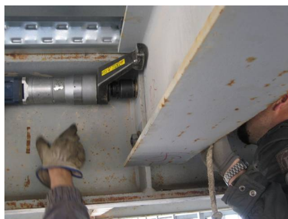
Figura 6b. Tesado de unión atornillada.
