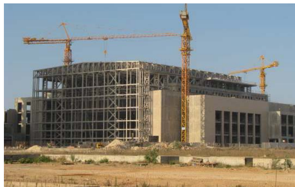
Figura 5b. Vista durante la ejecución del edificio de Oficinas y el Auditorio.
