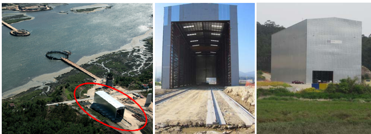
Figura 7. Nave de ensamblaje de piezas del lado de Rianxo (Lado A Coruña). Fabricación Martifer.
