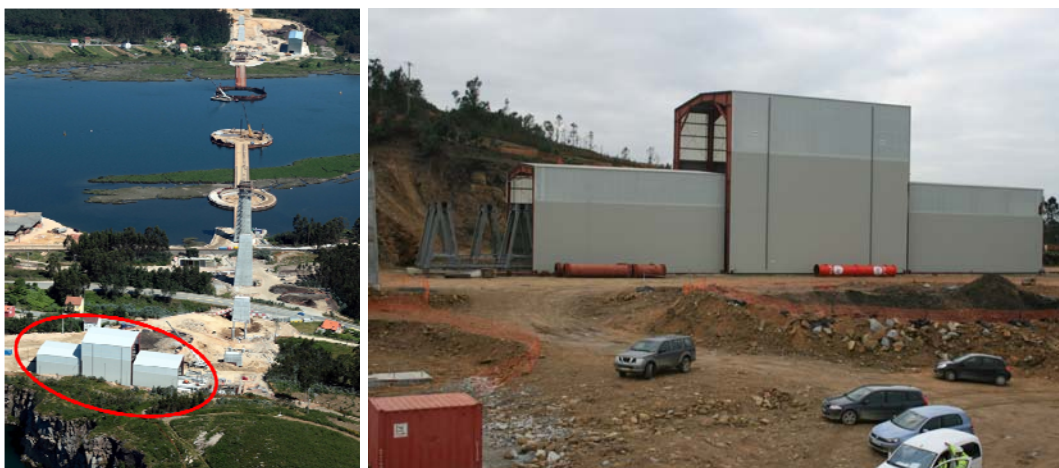
Figura 6. Naves de ensamblaje de piezas del lado de Catoira (Lado Pontevedra). Montaje en obra Masa y fabricación en taller Ascamón y Joama.
