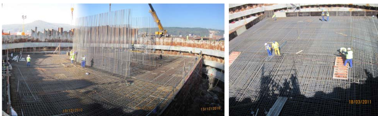
Figuras 10a, y 10b. Vista de la ferralla del encepado de P-5 (30x24,5x4,5m), y de la zapata de la P-7.
