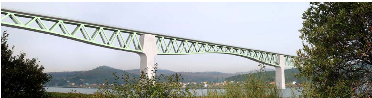
Figura 3. Vista lateral del vano principal del Viaducto sobre el río Ulla
