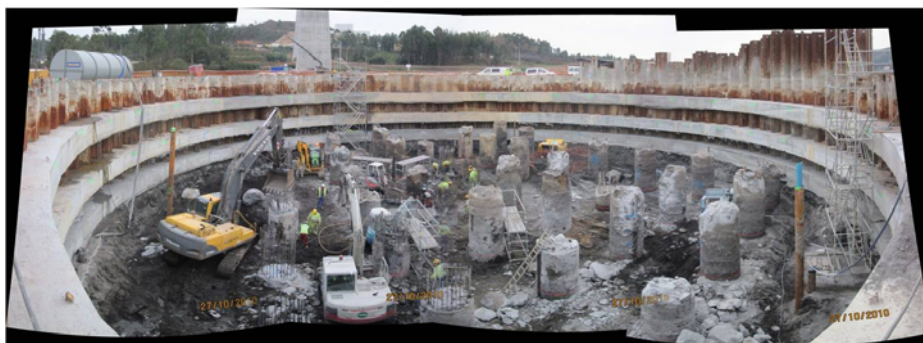
Figura 9. Descabezado de pilotes del encepado de P-5.
