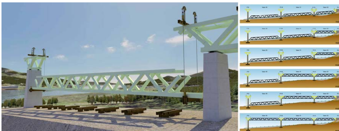
Figura 13. Secuencia del proceso de izado de los vanos laterales 10, 11 y 12.
