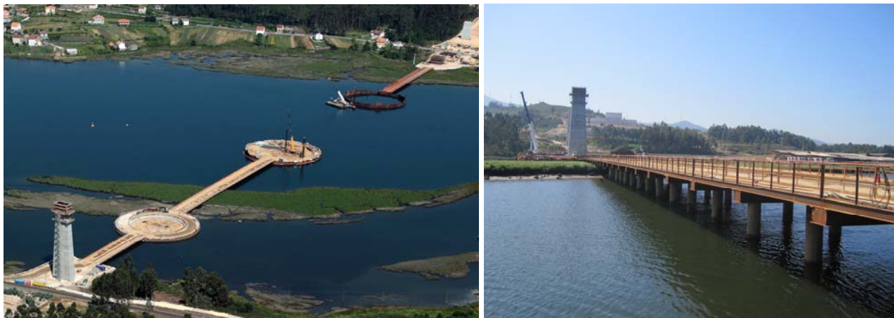
Figuras 8a, y 8b. Vista aérea de los recintos de las pilas P-5, P-6 y P-7, e imagen del pantalán.
