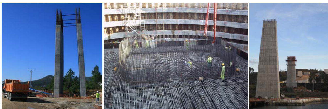
Figuras 7a, 7b, y 7c. Vista del fuste de P-8, arranque de P-6 en ejecución, y vista de pilas laterales.
