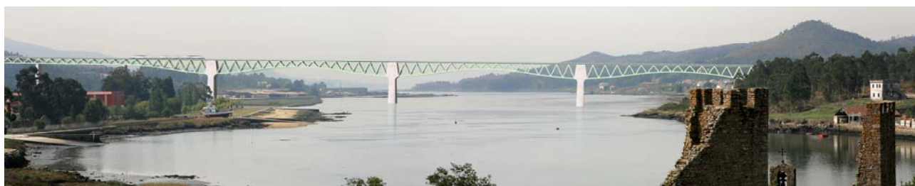
Figura 2. Vista del Viaducto sobre el río Ulla
