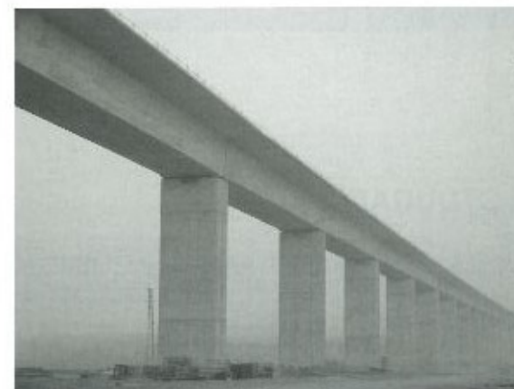
Figura 7.- Vista del puente terminado.
