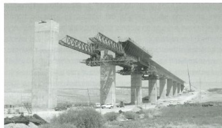
Figura 1.- Pilas y tablero durante la ejecución.
