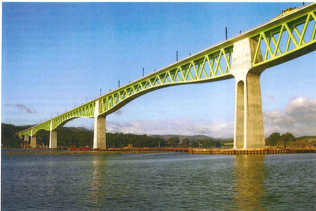
Fig. 8. Vista del viaducto concluido
