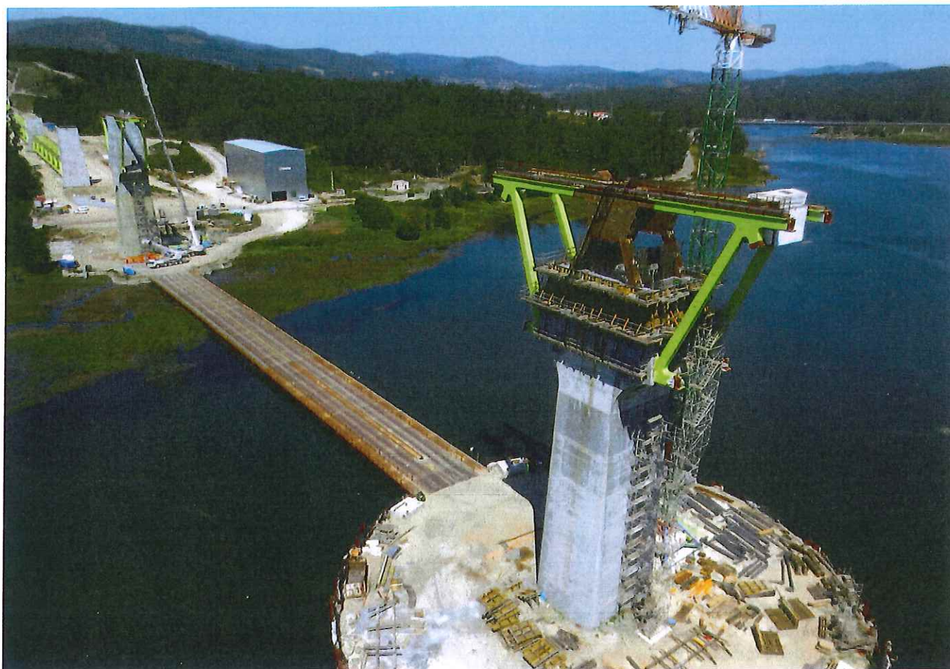
Fig. 6b. Ejecución del cabecero de hormigón
