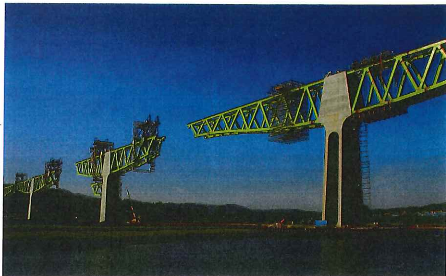
Fig. 7. Vista del avance por voladizos sucesivos
