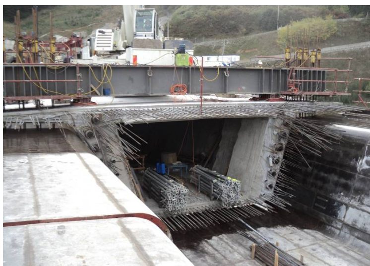
Figura 11. Vista del frente de fase y del sistema de cuelgue de la cimbra del extremo del voladizo
