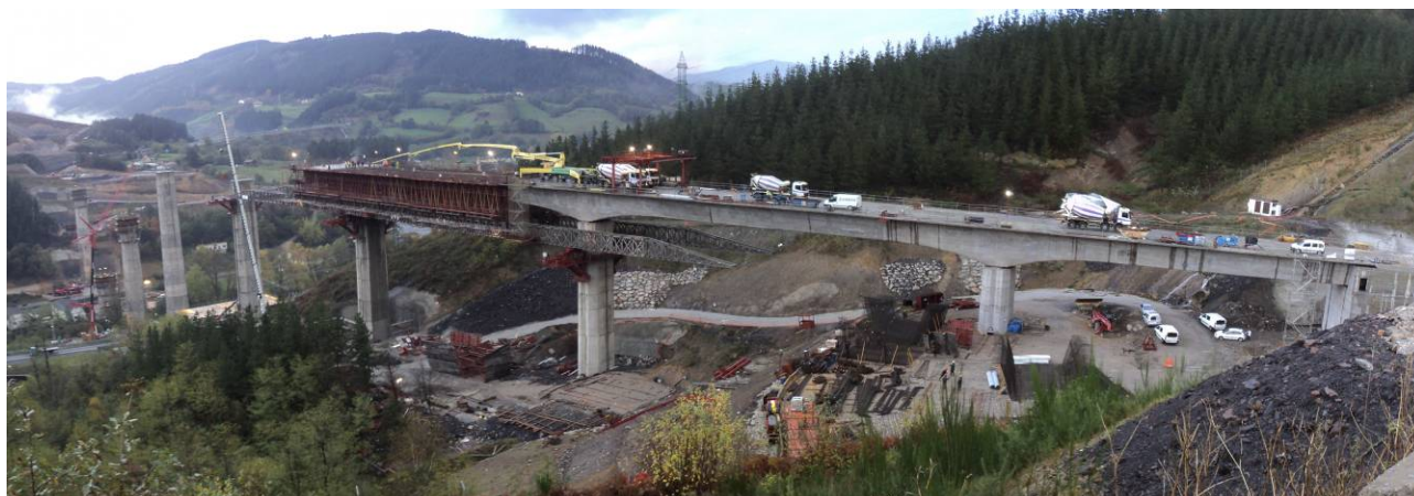
Figura 12. Vista de la ejecución del tablero con autocimbra desde el E-2 (noviembre 2013)
