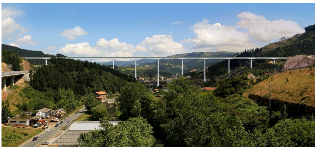
Figura 7. Fotomontaje de la solución construida de hormigón pretensado
