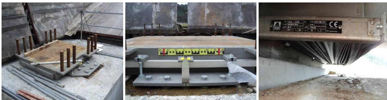
Figuras 9a, 9b y 9c: Vista de un apoyo, sistema de medición con regleta y protección guardapolvo
