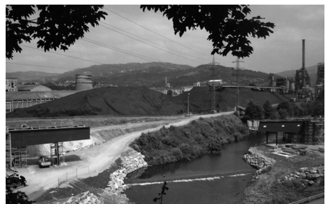
Figura 15. Vista de los 2 tramos laterales metálicos apeados.
