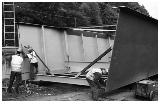
Figura 20. Corte de demasías en el tramo central.
