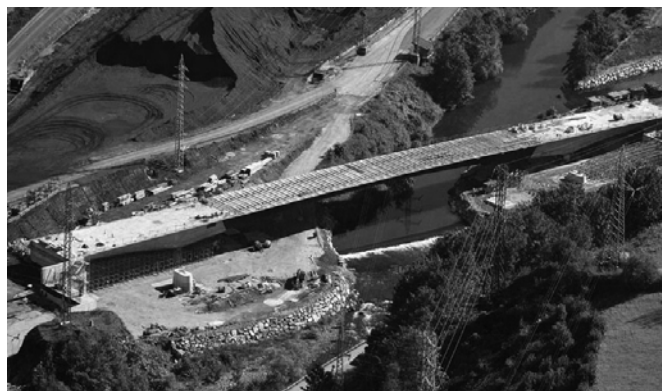
Figura 24. Vista aérea del primer viaducto con todas las prelasas ya colocadas.
