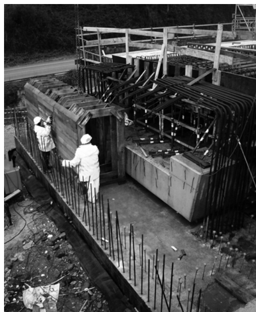
Figura 10 b. Ejecución de estribo, con galería para inspección de apoyos inversos.
