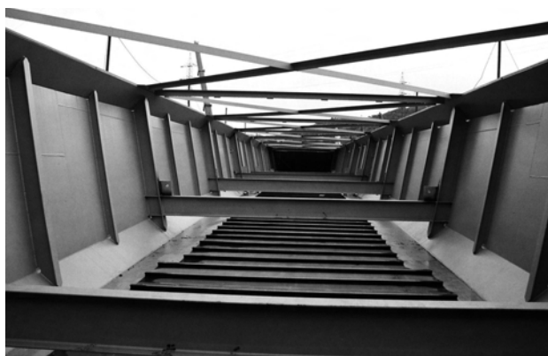
Figura 22. Vista interior del centro de vano.
