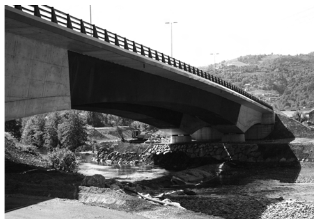
Figura 28. Vista inferior de los dos viaductos concluidos.
