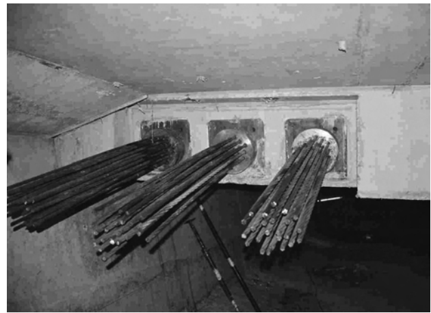
Figura 7. Vista de anclajes de pretensado en cuñas
