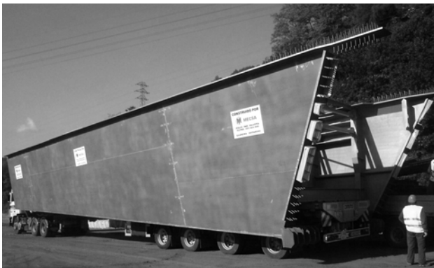
Figura 13. Transporte del primer tramo metálico.
