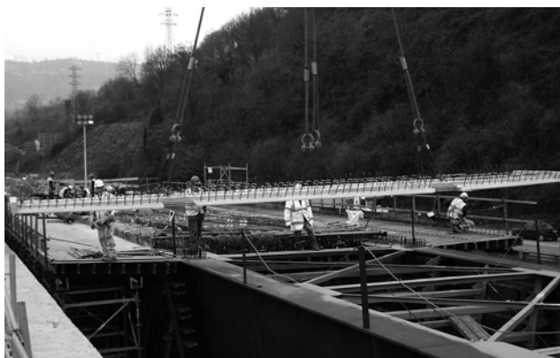
Figura 23. Colocación de prelasas prefabricadas.
