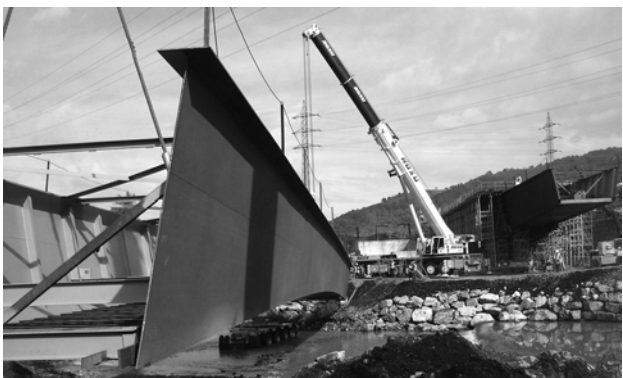
Figura 19. Izado del tramo central metálico.
