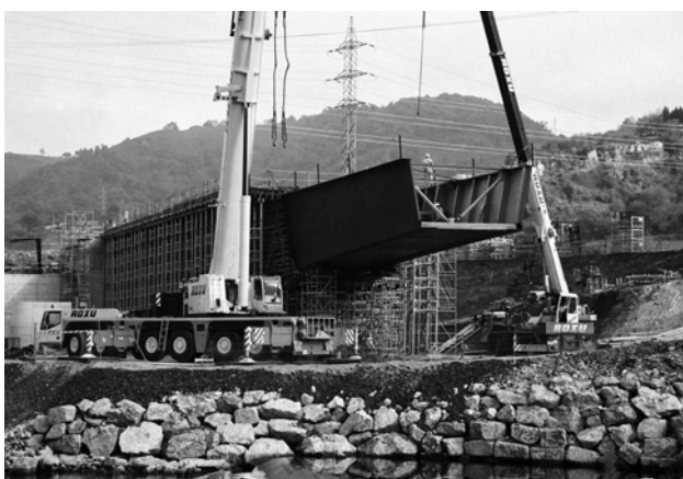
Figura 17. Vista del voladizo pretensado y desapeado.
