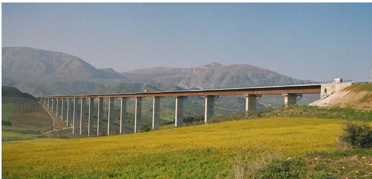
Fig. 18 Vista del viaducto concluido
