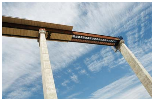
Figs. 2 y 3 Vista general y durante el empuje del Viaducto sobre el Arroyo de las Piedras
