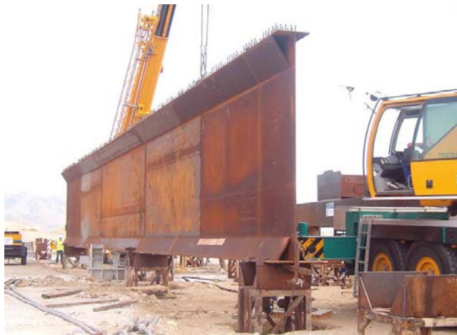
Fig. 10 Transporte y colocación de una de una viga metálica
