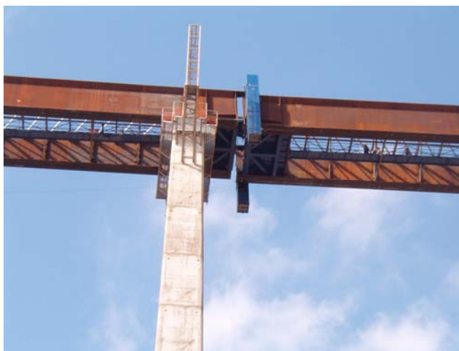
Fig. 17 Vista inferior del instante de unión de tramos
