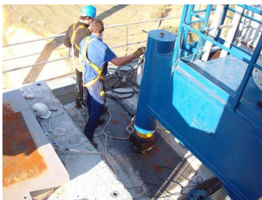
Fig. 14 Detalle del gato frontal y el gato en la nariz
