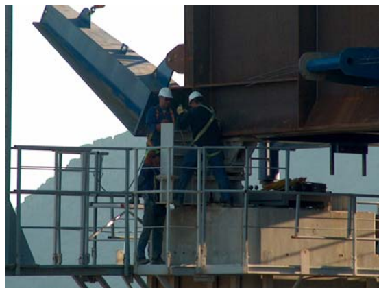
Fig. 15 Operación de paso de pila y repliegue de patines
