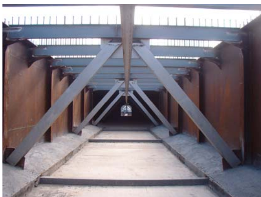
Fig. 4 Vista de prelasas inferiores y hormigón de fondo
