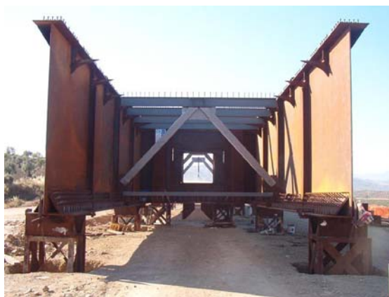
Fig. 6 Estructura metálica apeada en el parque de empuje. Ejecución de dovelas
