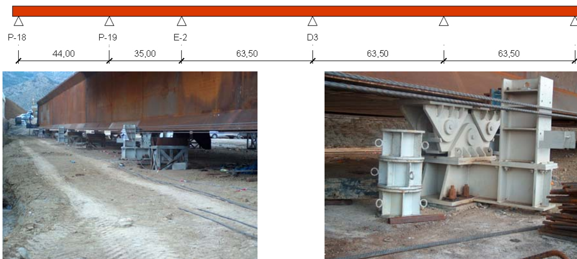
Fig. 19 Condiciones de apoyo durante la prueba
