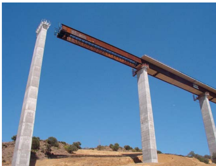
Fig. 16 Vista del voladizo antes de llegar a pila durante el empuje
