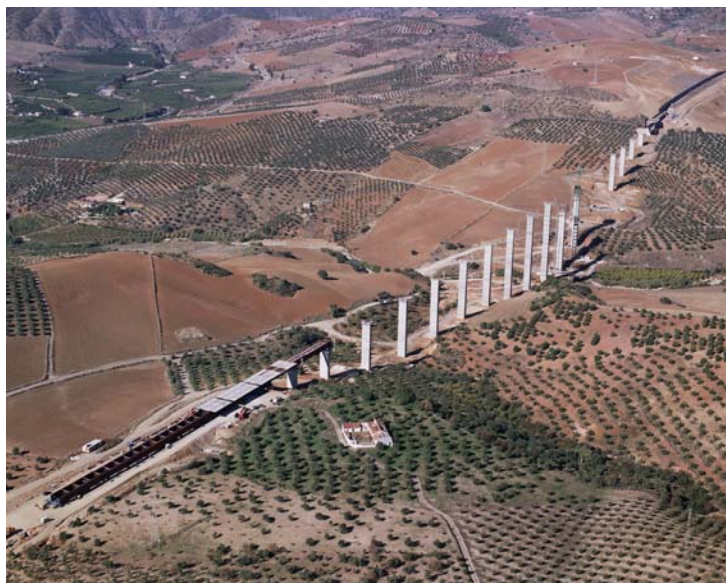
Fig. 11 Vista aérea del viaducto en construcción, con parte del tablero en el parque de empuje del Estribo 2
