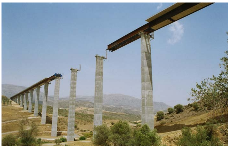
Fig. 24 Vista de pilas durante el empuje
