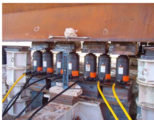
Fig. 23 Aplicación reacción localizada con gatos
