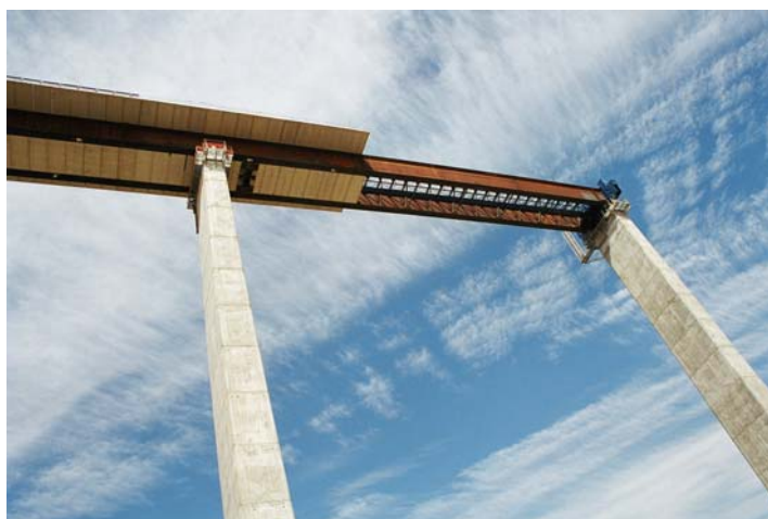
Fig. 12 Vista del primer vano sin prelasas inferiores ni superiores durante el empuje
