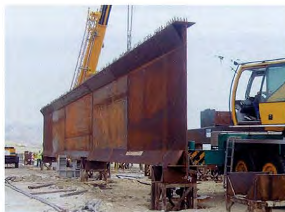
Photo 8 : Déchargement et positionnement d'une poutre métallique / Unloading and positioning of a steel girder
