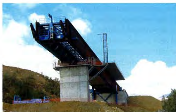
Photo 18 : Patins de glissement et vérins en bout de l'avant-bec / Sliding pads and hydraulic jacks at front of launching nose
