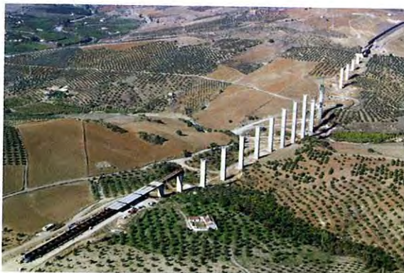
Photo 10: Viaduc en construction avec le tablier lancé jusqu'à la travée 2 / Bridge mounting with the steel deck launched over the second span
