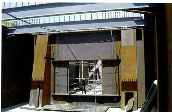
Photo 5: Pièce de pont sur pile / Support cross beam
