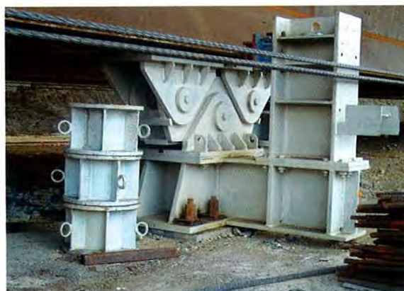
Photos 21a et 21b : Appuis pendant le lançage / Launching supports
