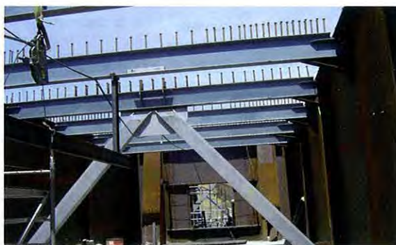
Photo 6: Pièces de pont en travée / Diagonal cross beams in span
