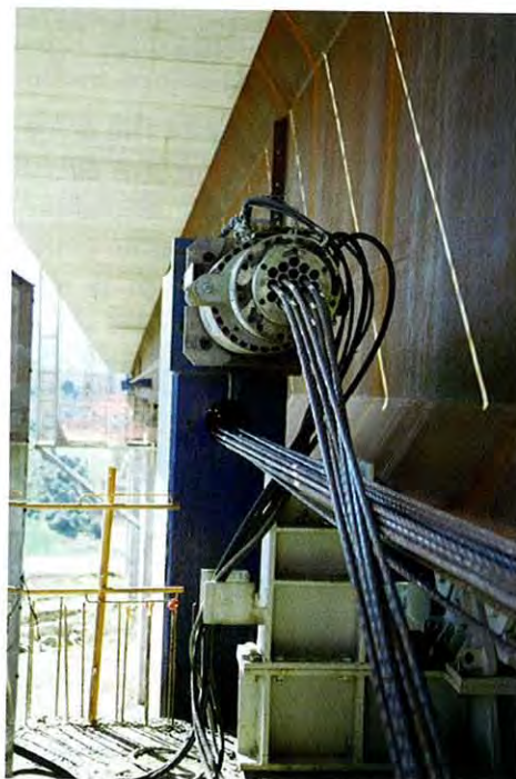
Photos 14 et 15: Câbles de lancement et de retenue de la première partie arrière / Launching and retaining cable of the first back part of the structure
