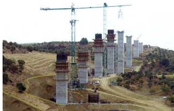
Photo 7 : Construction des piles par coffrage grimpant / Pier construction with climbing formwork
