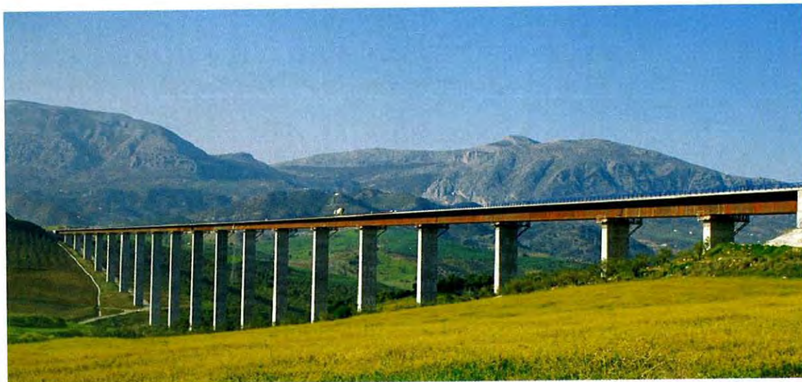
Photo 26 : Viaduc en fin de montage / Viaduct at end of launching
