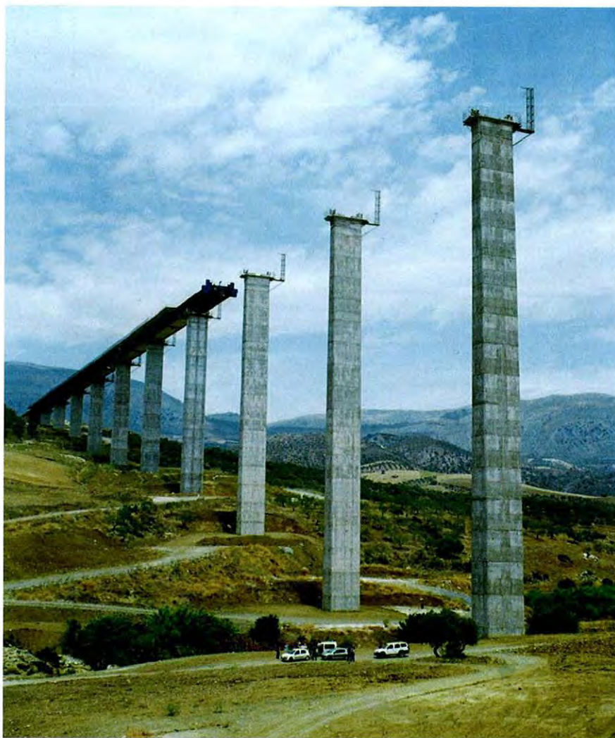
Photo 2: Lancement du tablier / Deck launching
