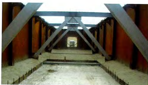
Photo 12: Panneaux de hourdis préfabriqués inférieurs et dalle mixte inférieure au fond / Prefabricated lower slab panels and composite lower deck at the back
