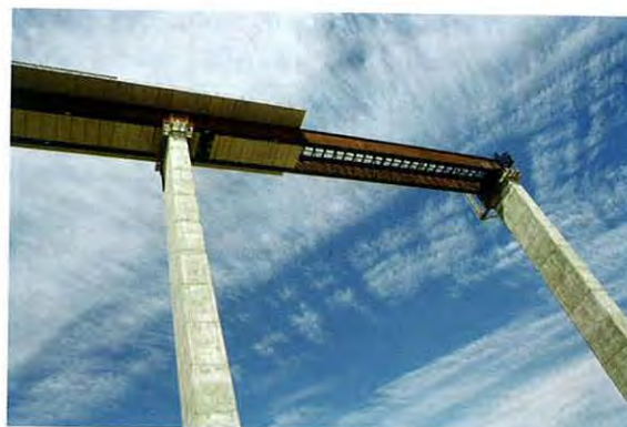
Photo 13: Lancement avec la première travée sans dalle inférieure ni supérieure / Launching with first span without lower on upper deck
