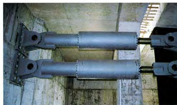
Photo 25 : Amortisseurs visqueux longitudinaux et transmetteurs de choc / Longitudinal dampers and shock transmission devices
