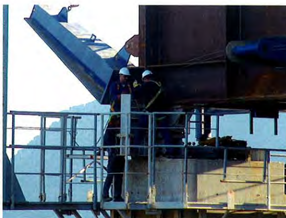
Photo 19 : Passage sur pile et repli des patins de glissement / Passage over pier with launching pad folded
