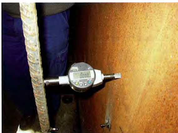
Photo 23 : Contrôle de la déformation transversale de l'âme / Control of transversal deformation of web
