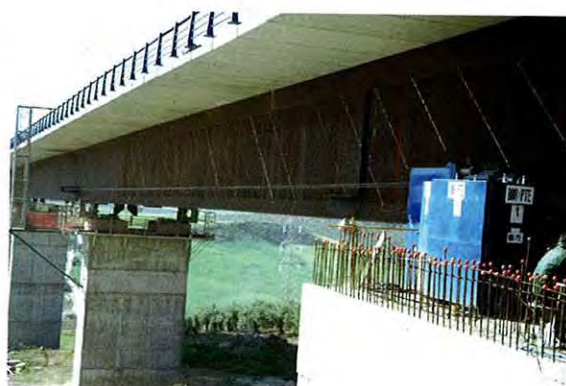
Photos 14 et 15: Câbles de lancement et de retenue de la première partie arrière / Launching and retaining cable of the first back part of the structure
