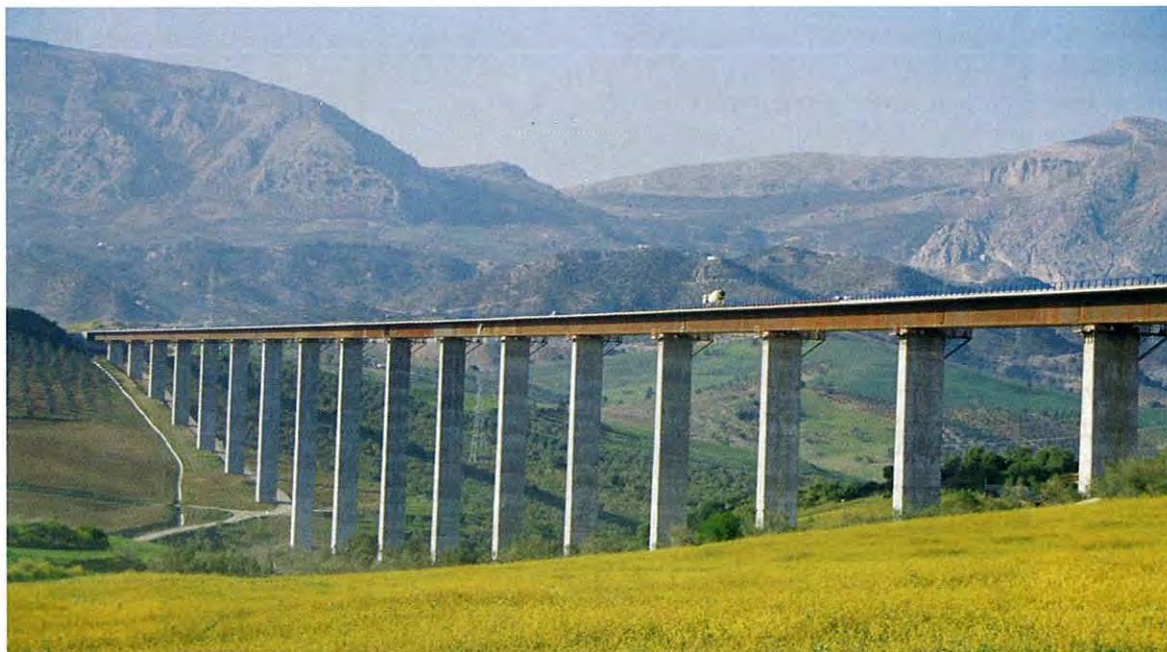
Photo 1 : Vue générale du viaduc La Piedras / General view of Las Piedras viaduct
