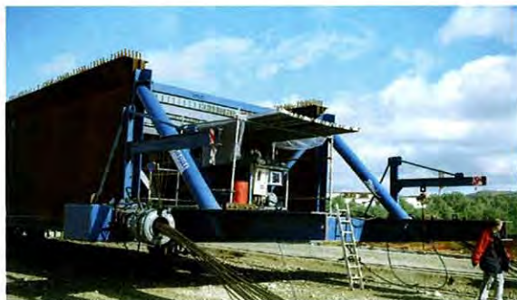
Photo 16 : Détail de la structure auxiliaire de lancement avec les câbles et galets / Details of auxiliary launching structure with cables and launching rollers
