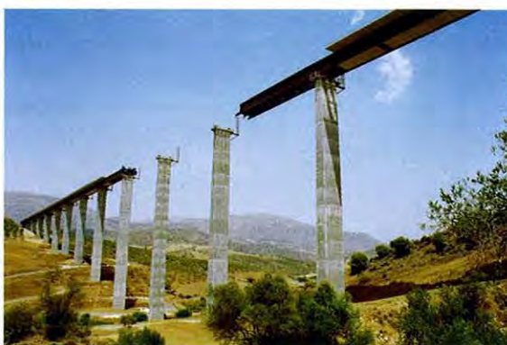
Photo 20 : Lancement du tablier des deux côtés / Launching of deck from the two sides
