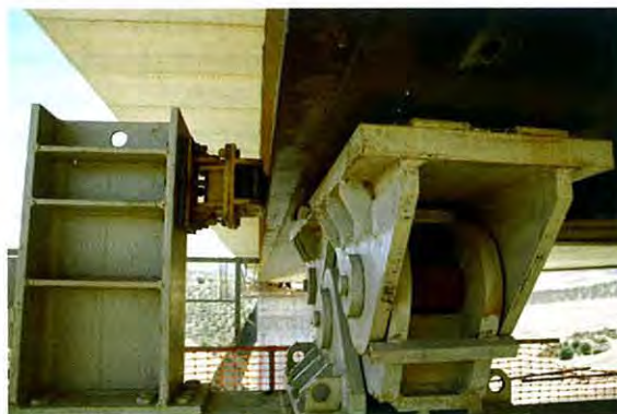
Photo 17 : Détail des appuis glissants avec guidage latéral pendant le lancement / Details of sliding support with lateral guidance during launching
