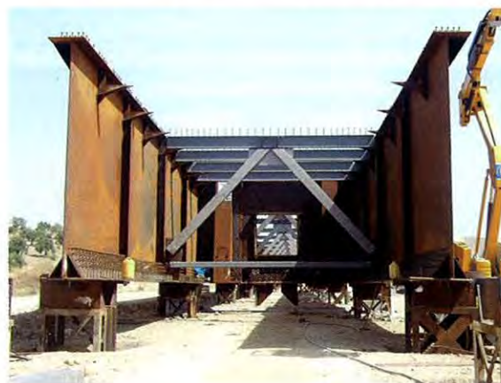
Photo 9 : Assemblage d'un tronçon complet de la structure métallique / Assembly of complete segment of steel structure
