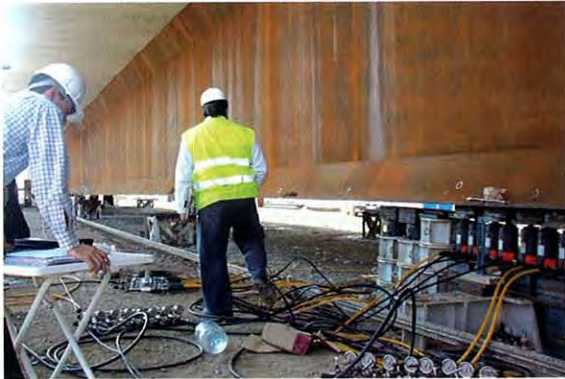
Photo 22: Mesure de la rigidité transversale / Measurement of transversal stiffness
