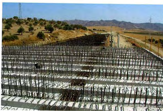
Photo 11: Prédalles de coffrage du hourdis supérieur / Pre-fabricated slabs for coffering of upper slab
