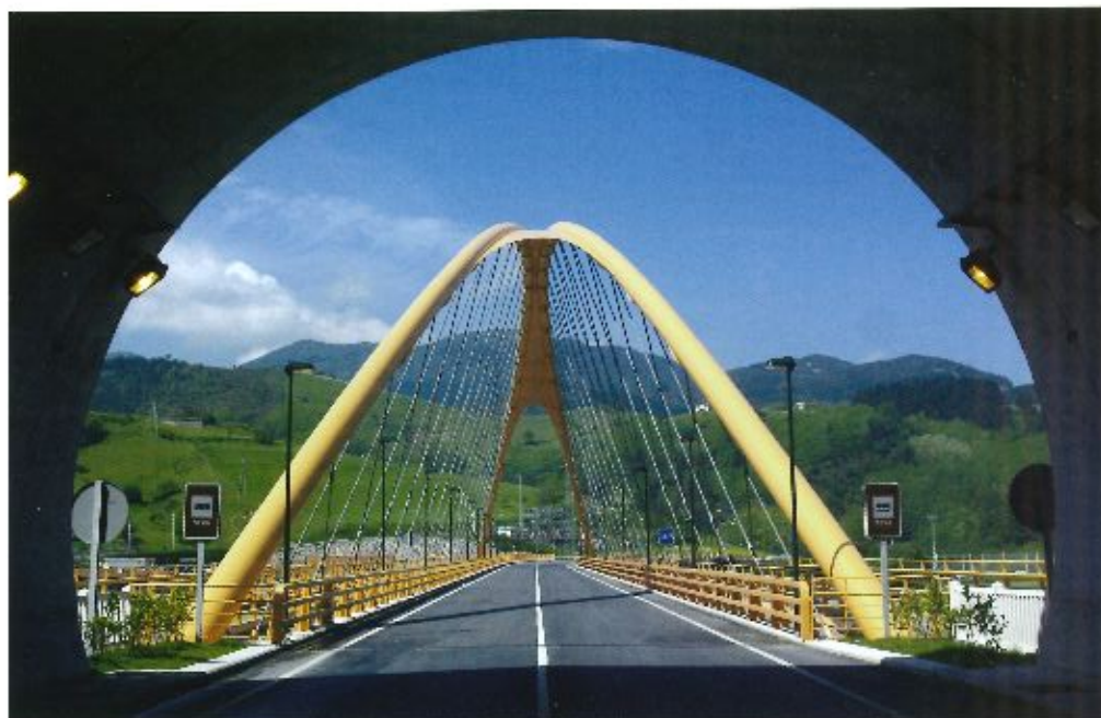
Vista del arco desde el interior del túnel.
