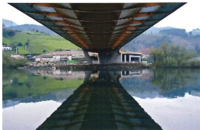
Vista inferior del tablero del puente.
