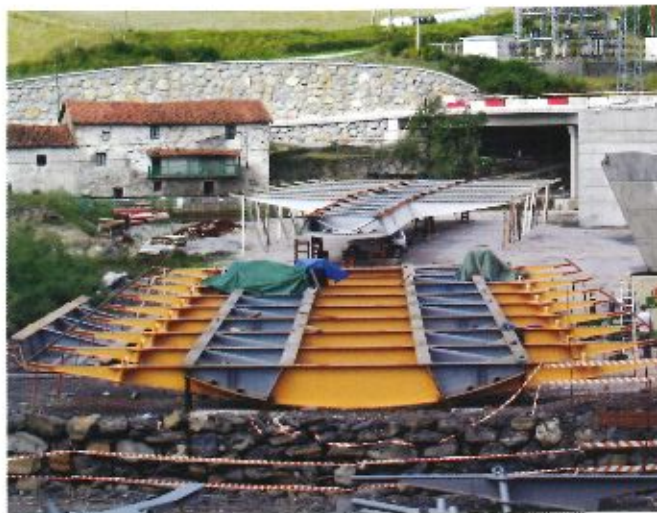
Arriba y debajo, secuencia del montaje del tablero metálico en apoyos provisionales
