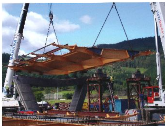
Arriba y debajo, secuencia del montaje del tablero metálico en apoyos provisionales
