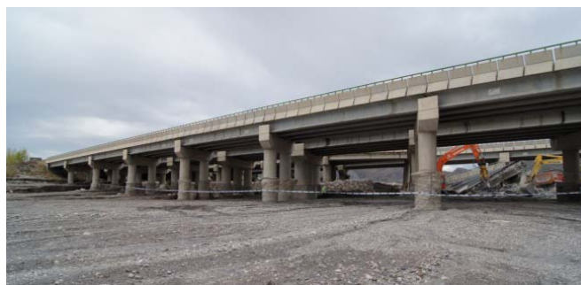
Figura 7. Arrastre de material del lecho aguas abajo de la estructura. Pilotes descubiertos del orden de 2,5 - 3 m
