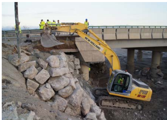
Figura 10. Ejecución de muro provisional de escollera asegurando el terraplén de acceso. Aprovechamiento de bloques de hormigón del estribo colapsado para la ejecución de la protección
