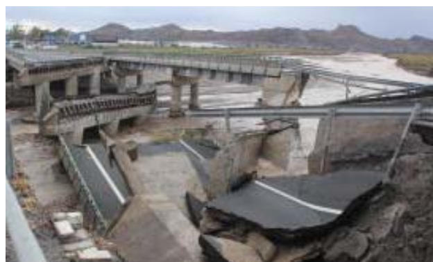
Figura 5. Pila 6 de calzada sentido Almería colapsada. Giros y asentos sufridos inadmisibles
