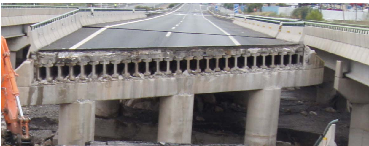
Figura 1. Vista general de la sección transversal de la calzada sentido Almería
