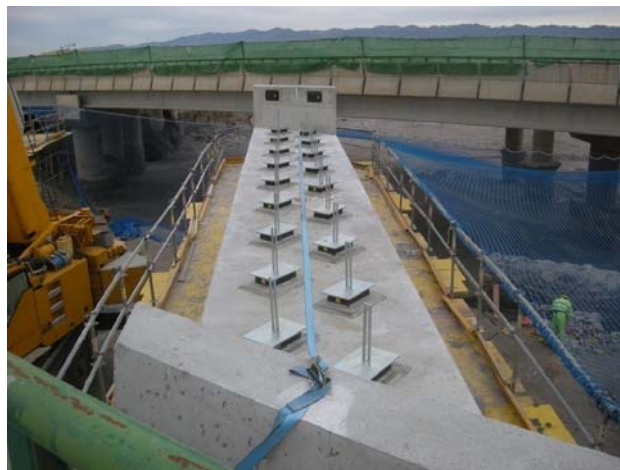
Figura 15. Detalle de aparatos de apoyo anclados en espera
