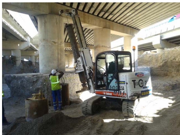
Figura 20. Ejecución de pilotes bajo tablero
