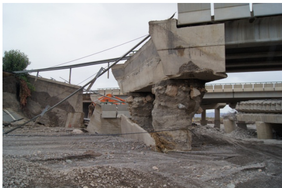
Figura 4. Estribo 2 de vía de servicio sentido Almería
