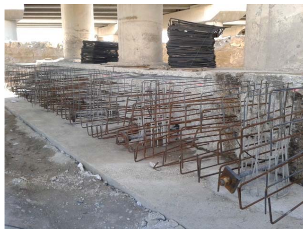
Figura 21. Detalle de armado de conexión cimentación existente-encepado
