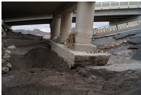
Figura 5. Pila 6 de calzada sentido Almería colapsada. Giros y asentos sufridos inadmisibles
