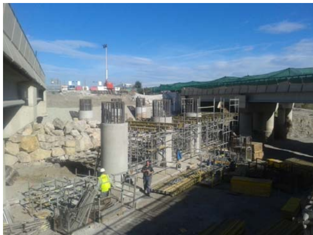
Figura 14. Vista general de la reconstrucción de las pilas
