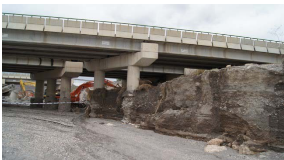
Figura 7. Arrastre de material del lecho aguas abajo de la estructura. Pilotes descubiertos del orden de 2,5 - 3 m
