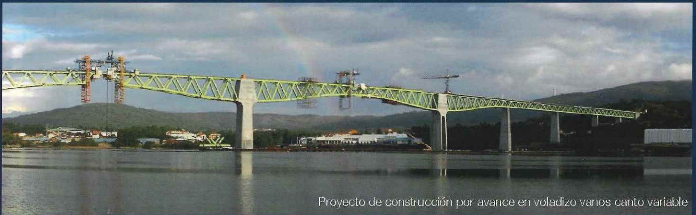
Izado dovelas canto variable
