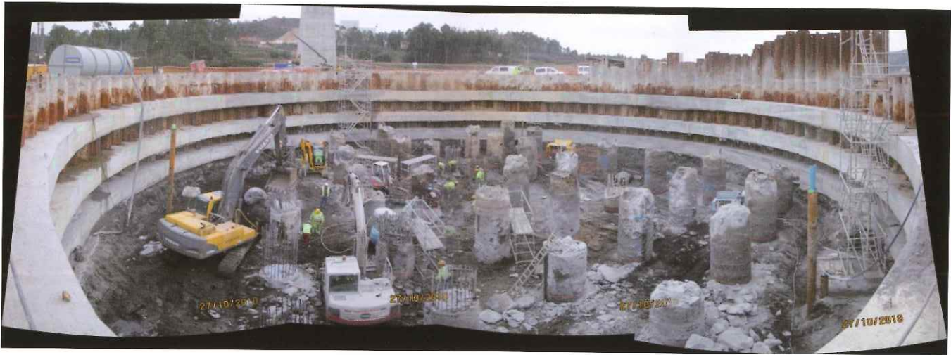
Fig. 5. Descabezado de pilotes del encepado de P-5
