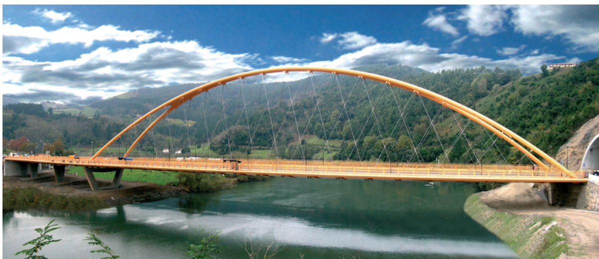
Figura 11. Vista desde aguas abajo Figure 11. Downstream view
