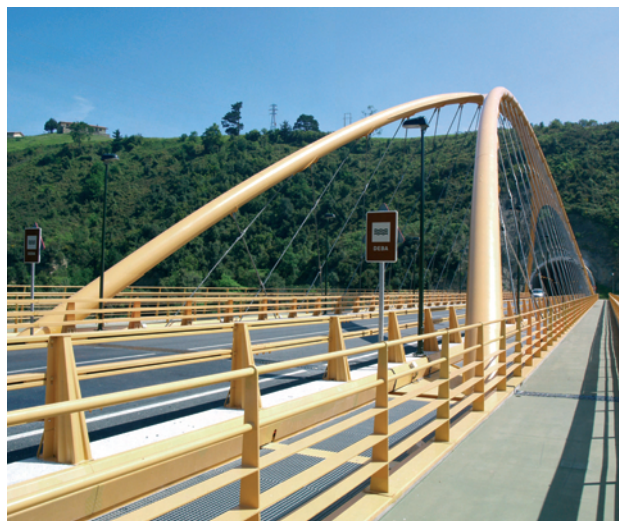
Figura 10. Vista de las aceras voladas laterales
