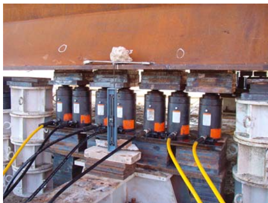
Figura 32. Aplicación reacción localizada con gatos
