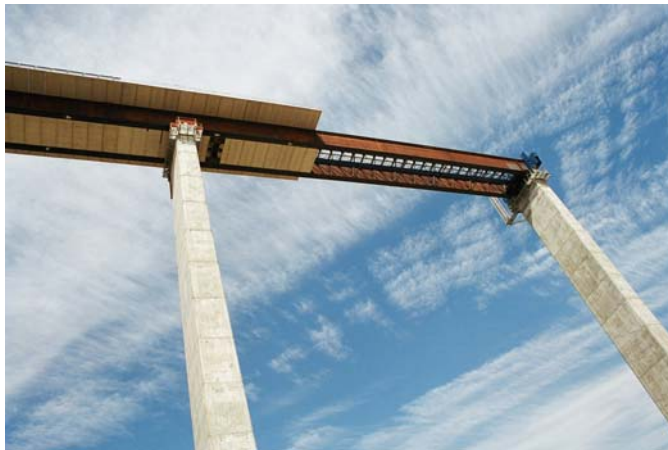
Figura 28. Vista del primer vano sin prelosas inferiores ni superiores durante el empuje
