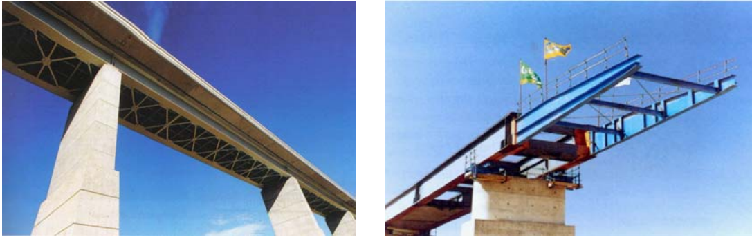
Figura 14. Viaductos bijácena de la Haute Colme y Bonpas
