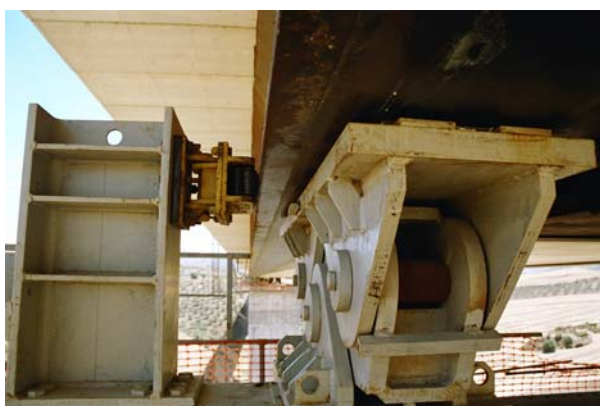
Figura 29. Detalle de apoyos deslizantes con topes laterales durante el empuje
