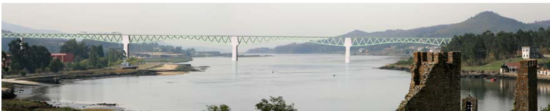
Figura 39. Vista del Viaducto sobre el río Ulla
