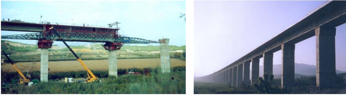
Figura 3. Viaducto sobre el río Jalón (2.238 m.)
