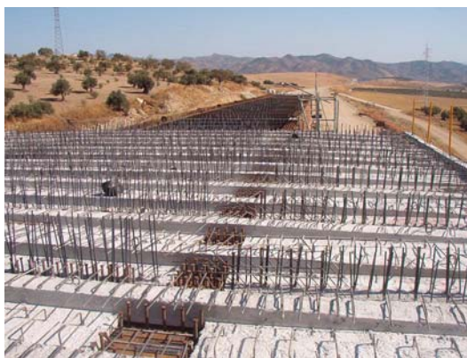
Figura 26. Vista de prelasas superiores
