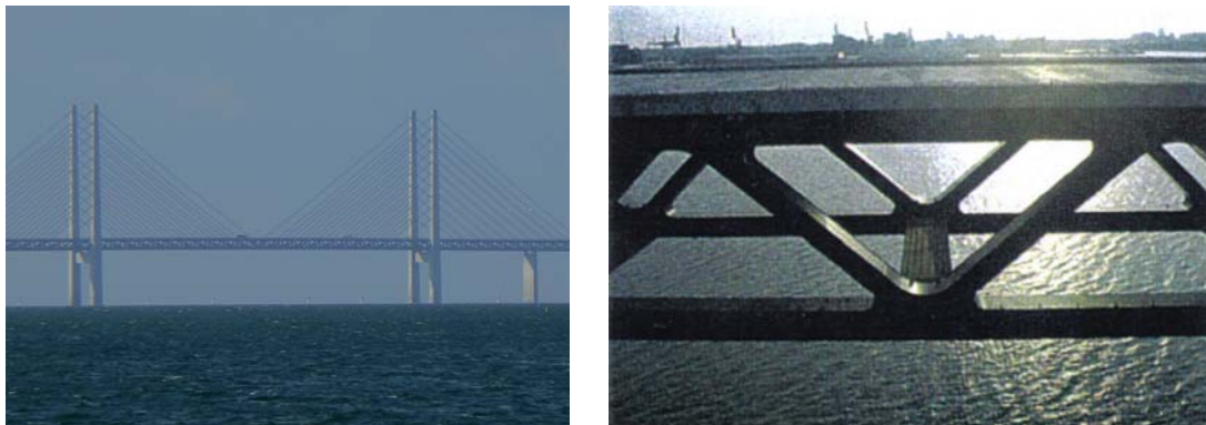
Figura 21. Puente atirantado de Oresund y celosía vanos de acceso
