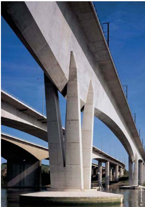
Figura 9. Viaductos de Medway (152 m.), Roquemaure (115 m.) y de Ventraben (100 m.), en voladizos sucesivos
