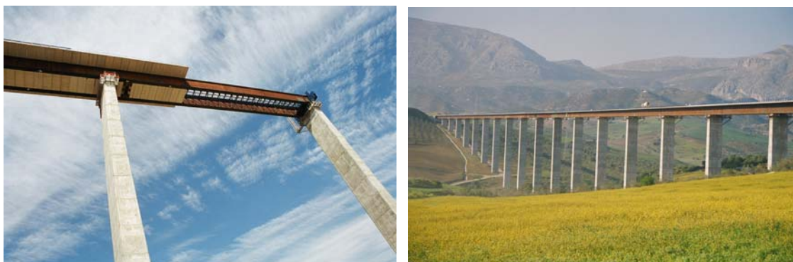
Figura 11. Viaducto Arroyo de las Piedras
