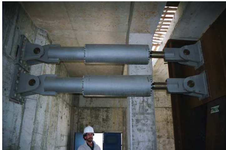
Figura 24. Amortiguadores-Transmisores de Impacto
