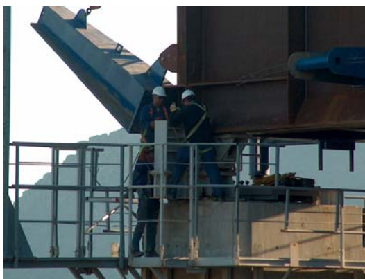
Figura 30. Operación de paso de pila y repliegue de patines
