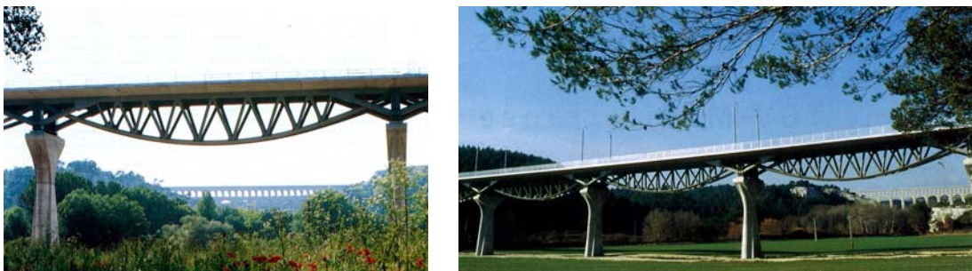
Figura 18. Viaducto des Arcs
