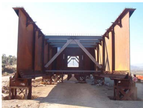
Figura 25. Estructura metálica apeada en el parque de empuje
