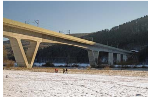
Figura 8. Viaducto de Gemunden (135 m)
