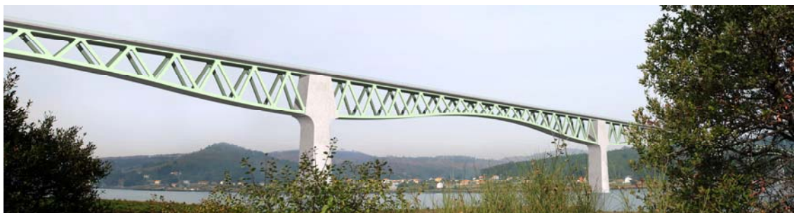
Figura 40. Vista lateral del vano principal del Viaducto sobre el río Ulla
