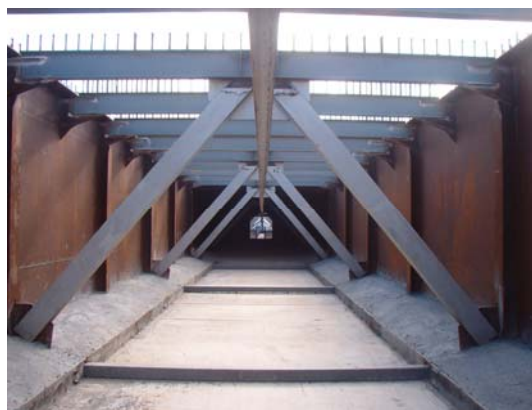
Figura 27. Vista de prelasas inferiores y hormigón de fondo
