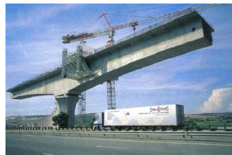
Figura 9. Viaductos de Medway (152 m.), Roquemaure (115 m.) y de Ventraben (100 m.), en voladizos sucesivos
