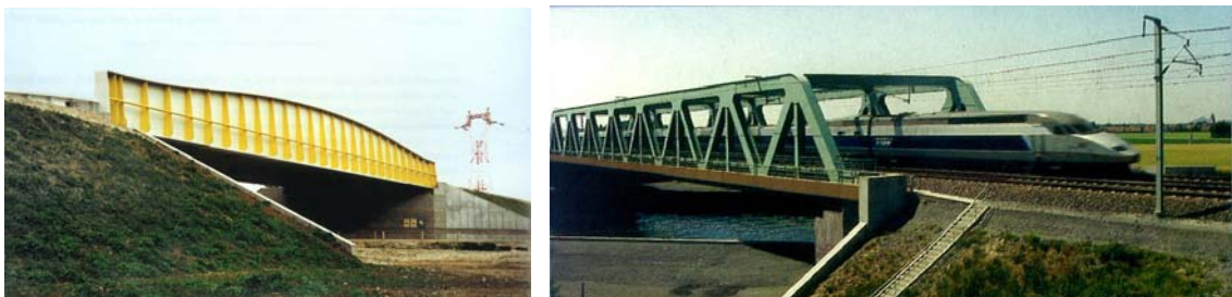
Figura 16. Tableros tipo RAPL o en celosía
