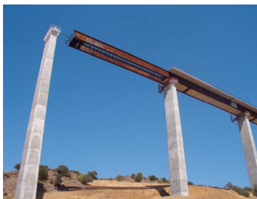
Figura 31. Vista del voladizo antes de llegar a la pila durante el empuje
