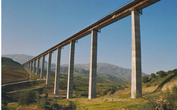
Figura 23. Viaducto Arroyo las Piedras
