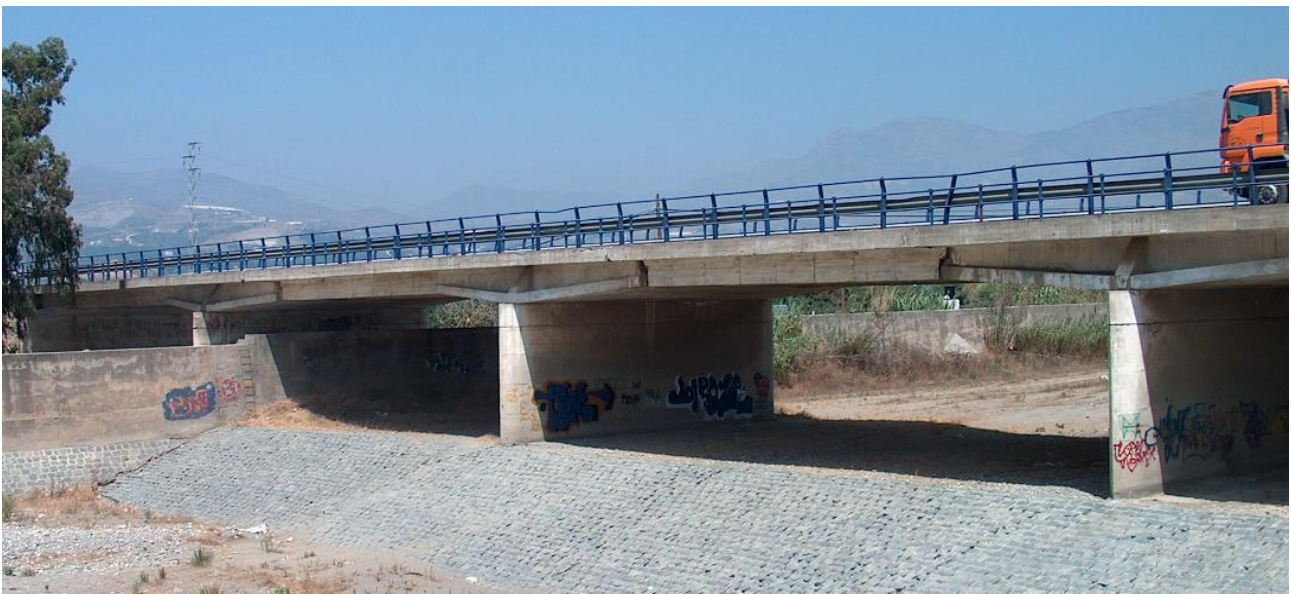
Figura 3. Vista general del puente en la que se aprecia la configuración longitudinal de los diferentes tramos y las medias maderas.
