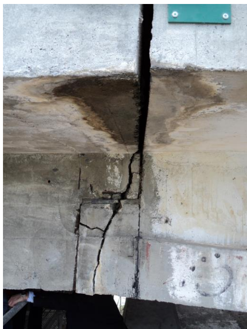
Figura 9. Vista general del apoyo 2A antes de comenzar los trabajos de demolición
