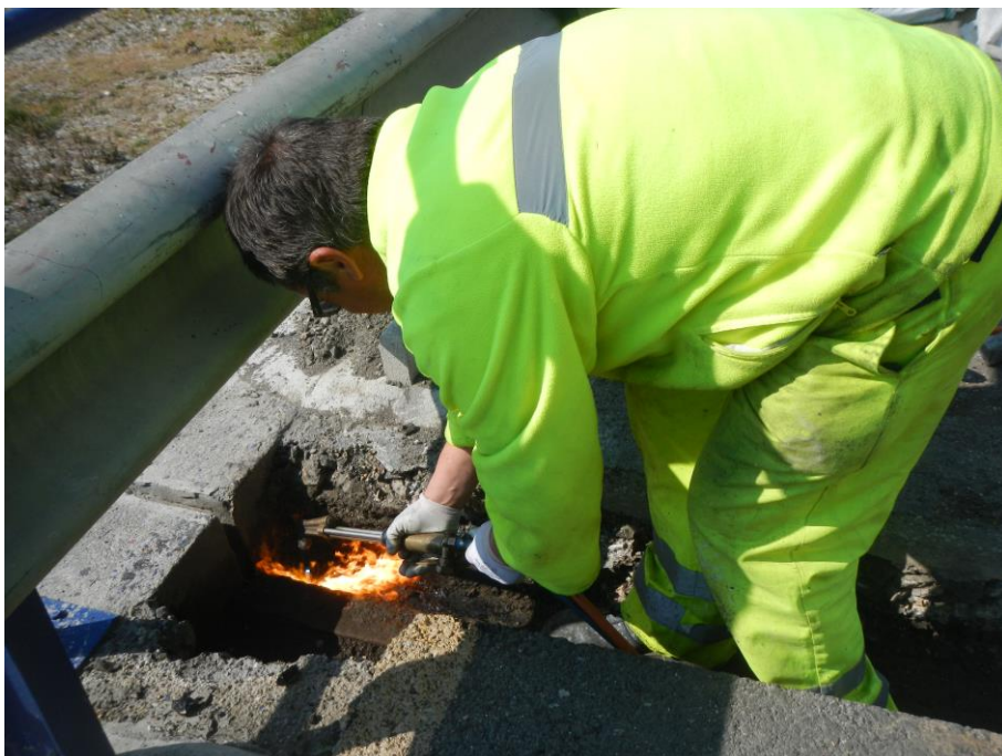
Figura 13. Trabajos de preparación y sellado de lámina estanca en junta de dilatación
