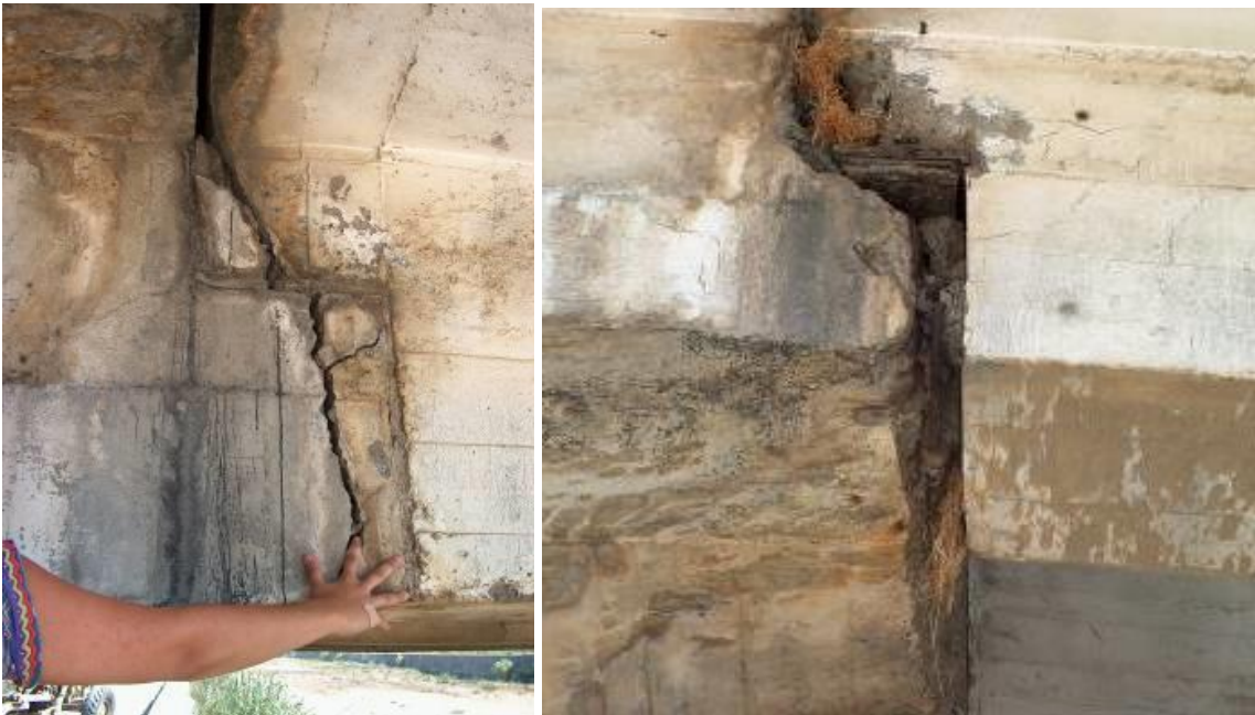
Figura 5. Estado en el que se encontraban algunas de las medias maderas
