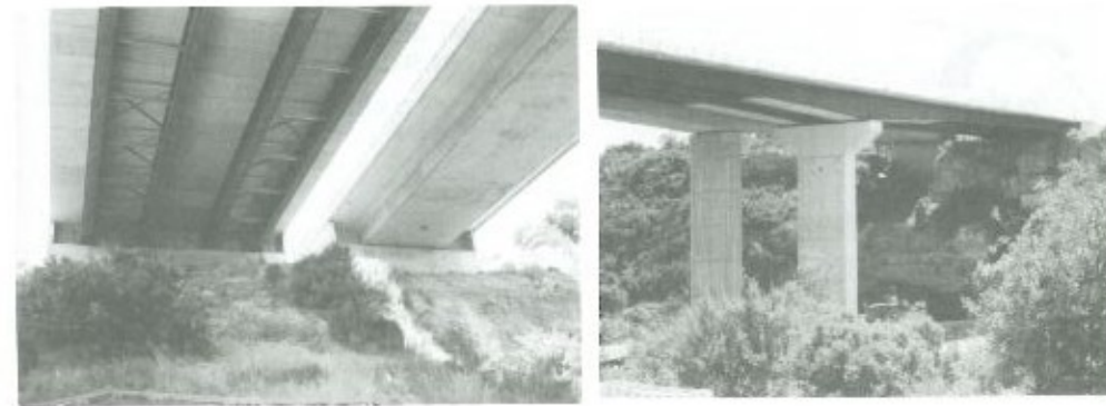
Figura 9. Vistas del puente acabado
