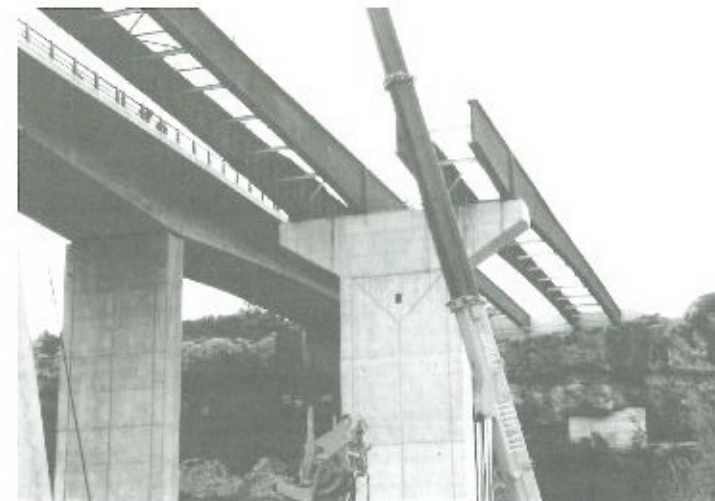
Figura 6. Montaje del vano lateral
