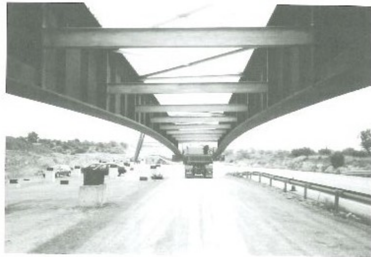
Figura 3. Pareja de vigas del vano central sobre camión
