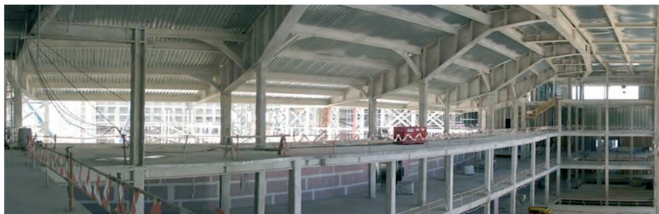
Figura 35. Vista trasera de las vigas principales del graderío superior
