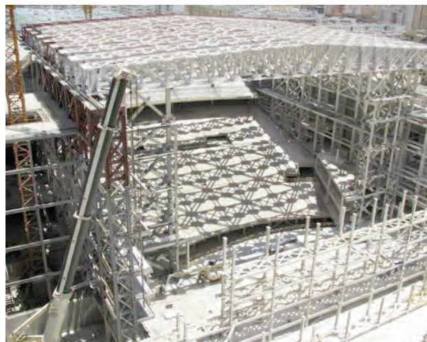
Figura 37. Vista de la cubierta prácticamente concluida
