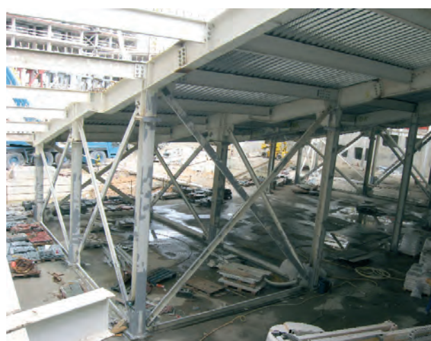
Figura 34. Vista de los arriostramientos durante la ejecución
