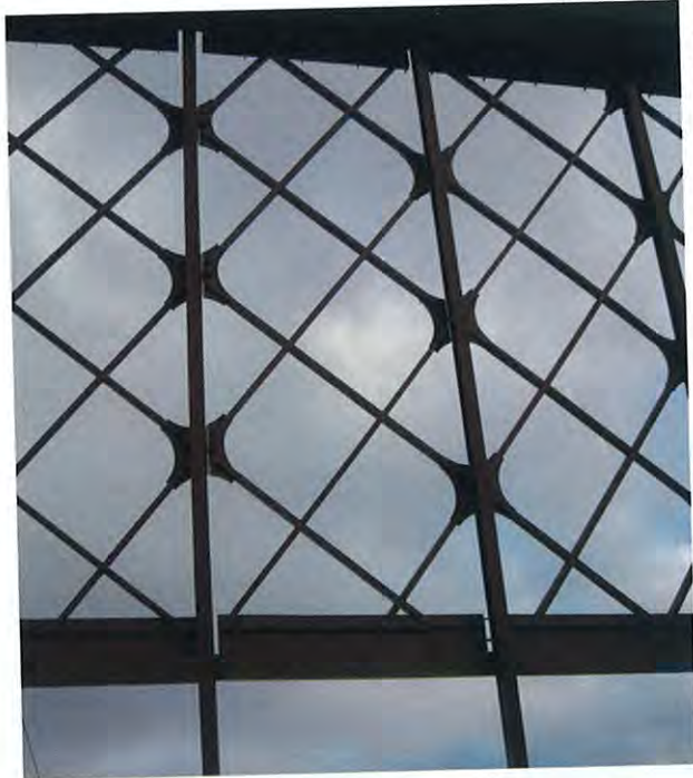
Detalle del diagrid y costillas.
