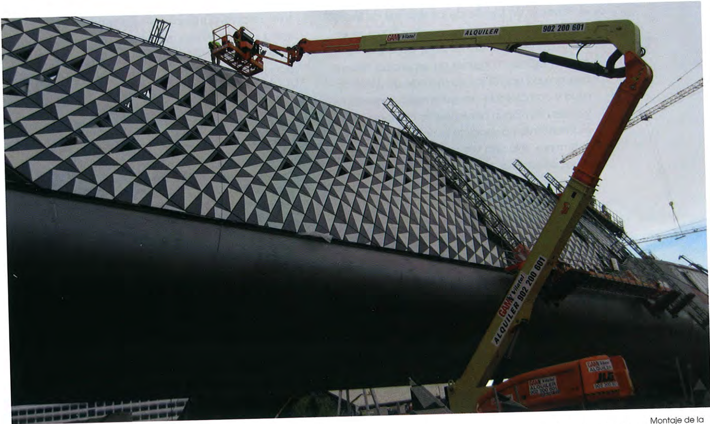
Montaje de la piel de fachada.
