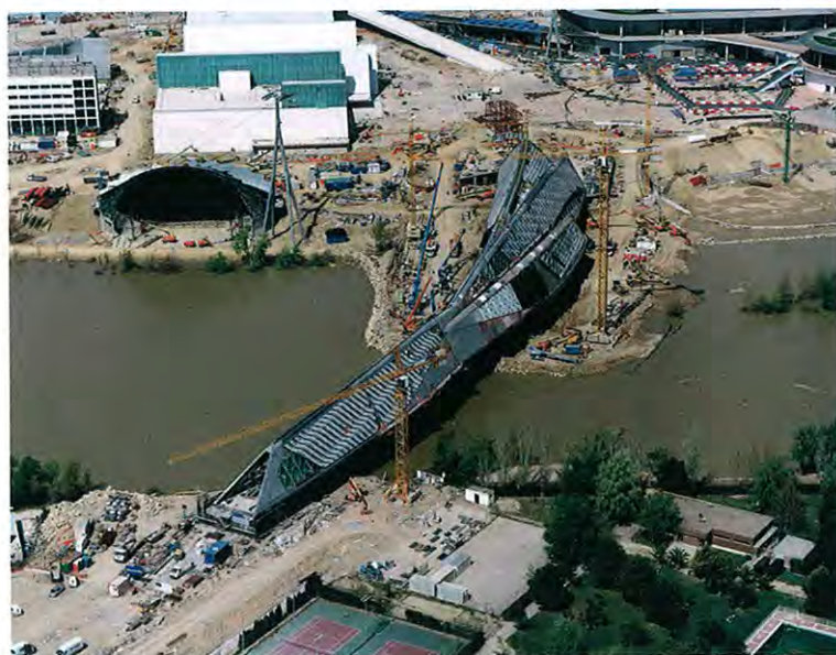
El Pabellón Puente durante su construcción.
