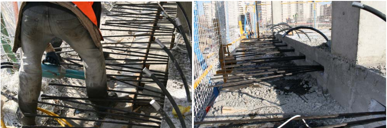
Figs. 10a y 10b: Vista durante le tesado de una unidad con gato unifilar, y vista de los anclajes en el extremo de una losa una vez hormigonada y tesada la planta.
