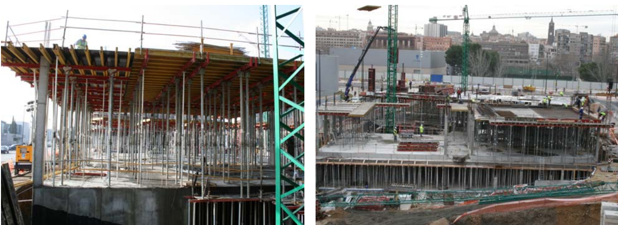
Figs. 12a y 12b: Cimbrado de una planta mediante el empleo de mesas de encofrado móviles, y vista del proceso de cimbrado de una planta con otra reapuntalada.
