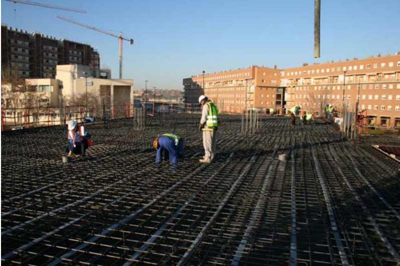
Fig 9 : Vista de un módulo ferrallado con el pretensado dispuesto para el hormigonado
