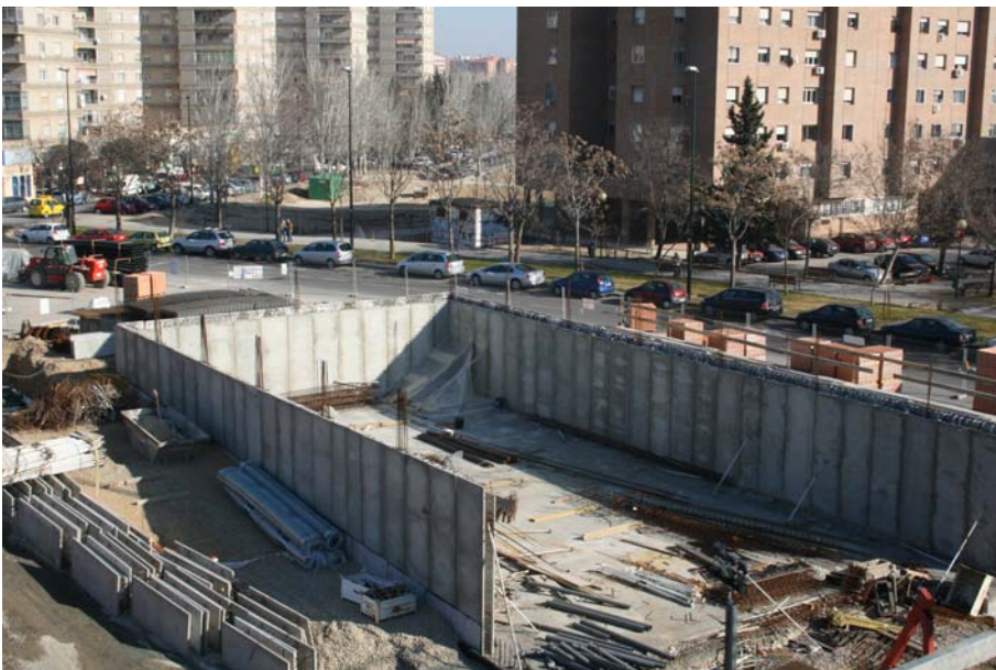
Fig. 14: Vista de la zona diáfana del sótano del gimnasio entre los muros perimetrales para alojar una pista polideportiva
