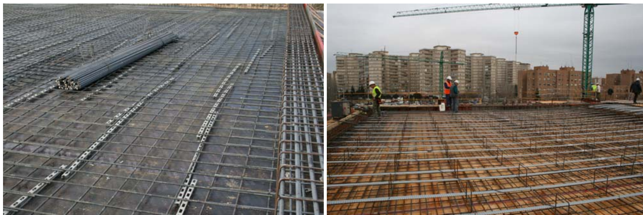
Figs. 8a y 8b: Ferrallado de malla de acero pasivo inferior, y replanteo de pates y vainas de pretensado
