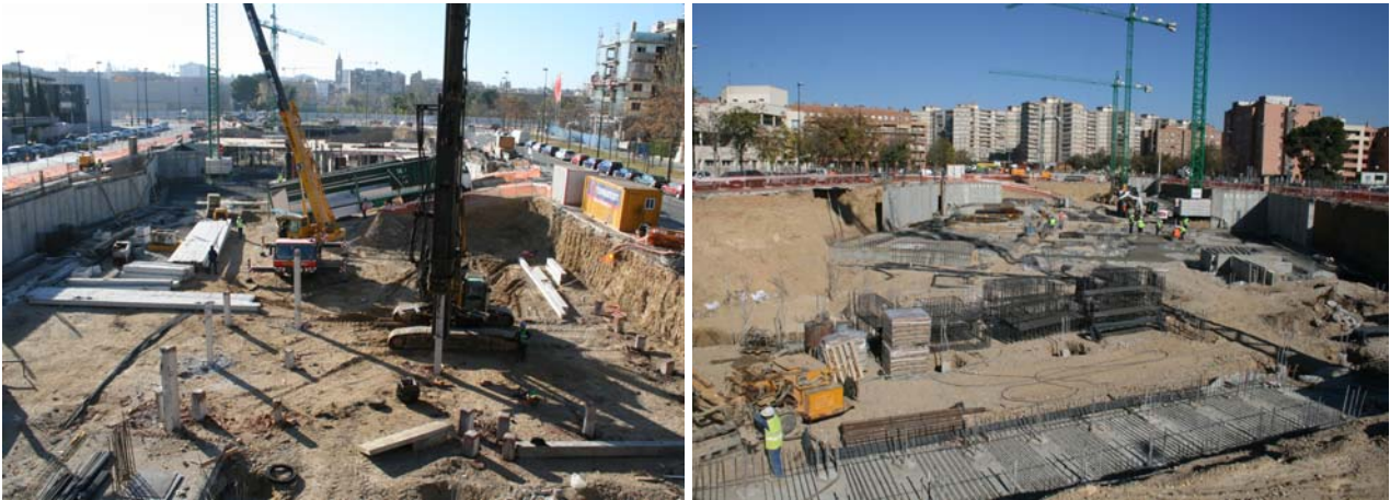
Figs. 11a y 11b: Detalle de ejecución de cimentaciones mediante pilotes prefabricados hincados, y de ejecución de encepados de pilares y muros perimetrales
