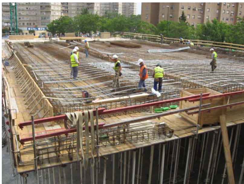
Fig. 16: Vista de la planta primera del Gimnasio durante las labores de ferrallado y colocación de vainas de pretensado
