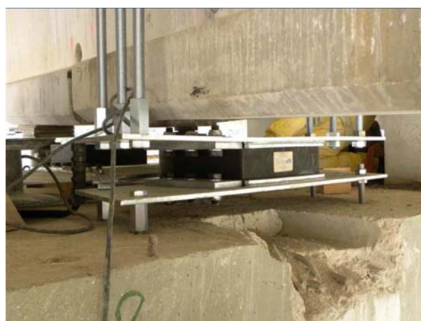
Figura nº 16. Aparato de apoyo montado en su posición definitiva a falta de ejecutar las mesetas de nivelación.
