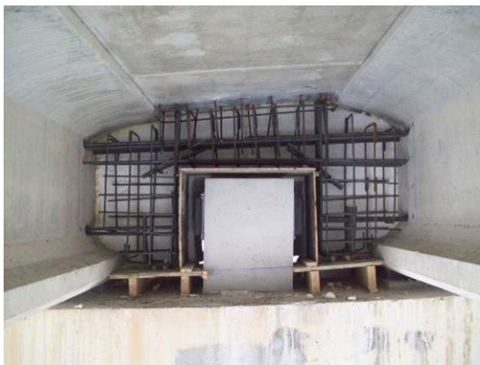
Figura nº 14. A la izquierda, detalle del tope sísmico y ferrallado de riostra. A la derecha, detalle de apoyos en tope transversal.
