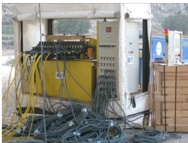
Figura nº 19. Centralita sincronizada para levantamiento simultáneo.
