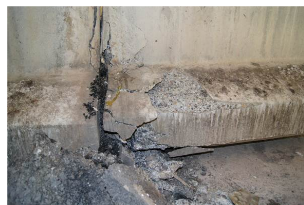
Figura nº 11. Desconchado de vigas por impacto longitudinal entre ellas. Roturas puntuales en extremos de vigas.
