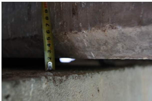
Figura nº 17. Holgura inicial para colocación de gatos de 3-4 cm de media.
