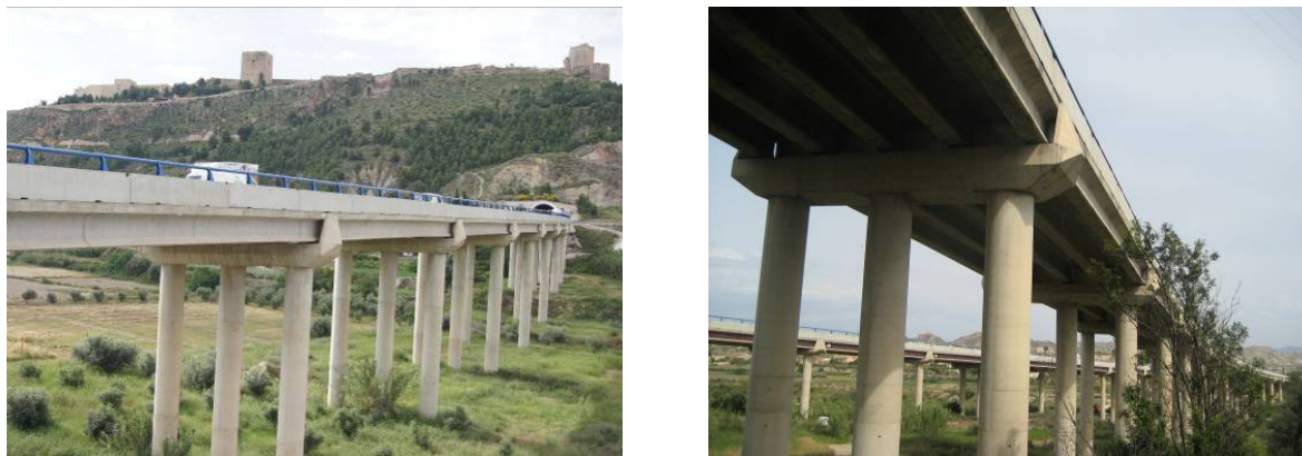
Figura nº 2. Vista general del tablero de la calzada sentido Murcia.
