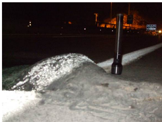
Figura nº 9. Compresión excesiva de las juntas de
