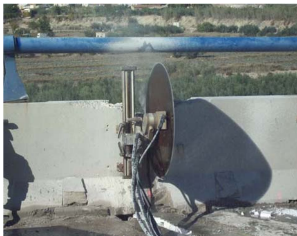
Figura nº 24. Corte de pretil con disco de diamante.
