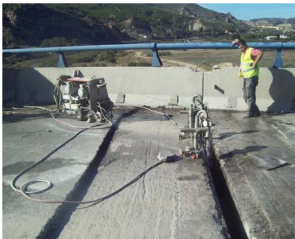
Figura nº 23. Corte de vigas con hilo de diamante desde el tablero.
