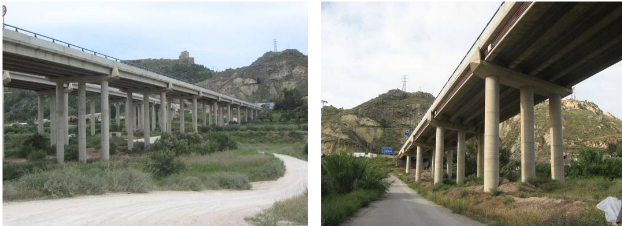
Figura nº 1. Vista general del tablero de la calzada sentido Almería.
