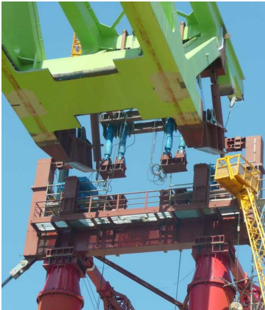
Figura 8: Fases de deslizamiento y llegada apoyo
