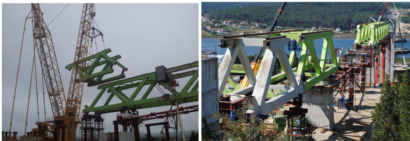
Figura 7a: Montaje de dovelas con grúa. Figura 7b: Montaje de vanos 1 y 2 después del lanzamiento
