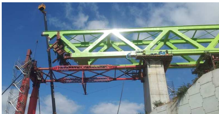
Figura 6: Sistema de recuperación de flecha en punta.
