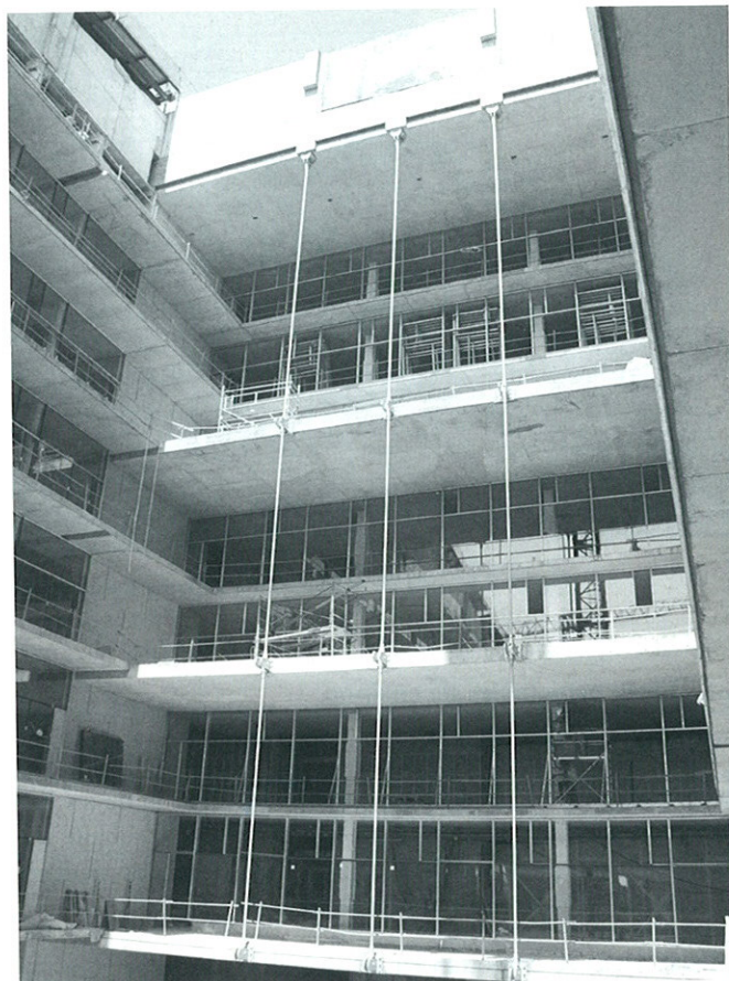
Figura 20. Interior del Sector I colgado con 2 HEM 300, y 3 tirantes de 76 mm de diámetro.
