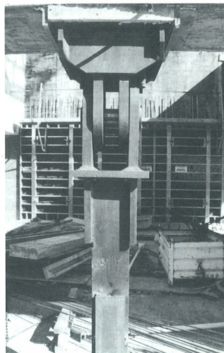
Figura 19. Enganche de tirantes interiores de Sectores II y III, a Vigas de Cuelgue y a Riostras Interiores.
