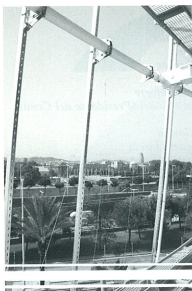
Figura 26. Detalle de tubo perimetral y montantes para sujeción de cerramiento exterior con lamas de madera, y detalle de fachada exterior.
