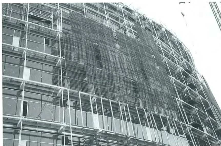
Figura 26. Detalle de tubo perimetral y montantes para sujeción de cerramiento exterior con lamas de madera, y detalle de fachada exterior.
