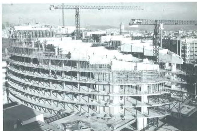
Ejecución de estructura superior de cuelgue (Enero 2004).
