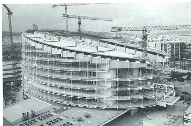
Desapeo y cuelgue del edificio (Septiembre 2004)
