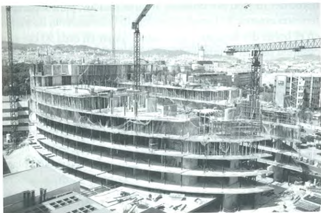
Ejecución de forjados apeados (Septiembre 2003).
