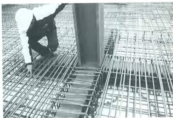
Figura 17. Tirantes interiores de Sectores II, y III. Unión mediante crucetas a forjados.
