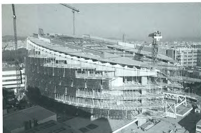
Ejecución de fachada exterior (Diciembre 2004).
